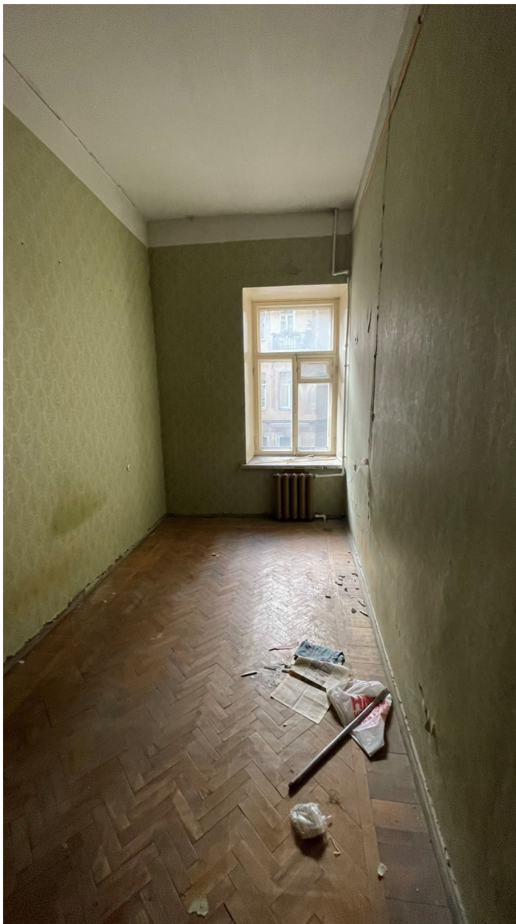
9. Фрагмент интерьера комнаты (помещение №2/11.5);
