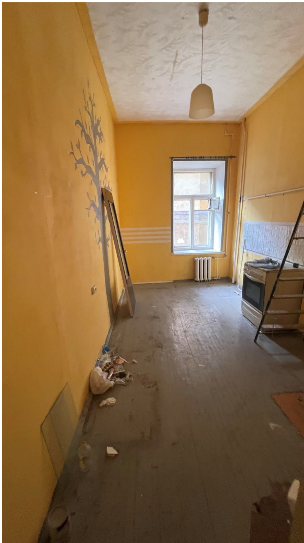
13.Фрагмент интерьера кухни (помещение №8/12.8);
