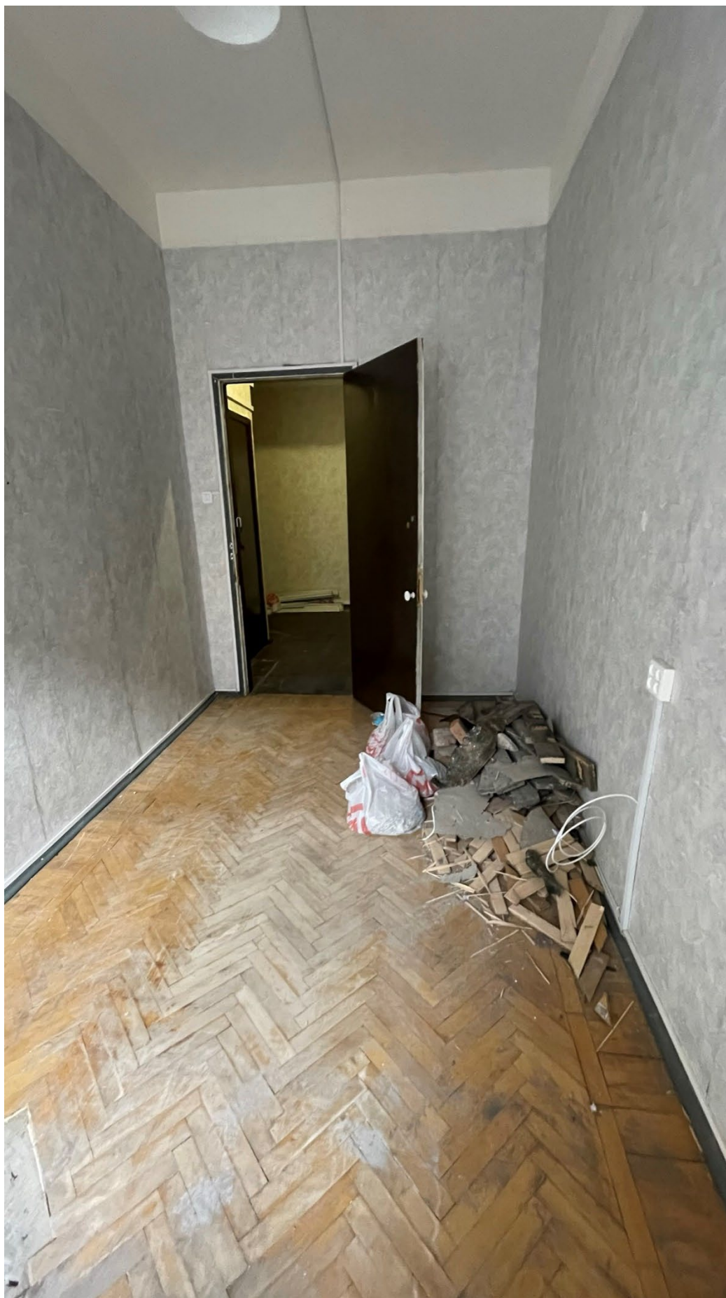
6. Фрагмент интерьера комнаты (помещение №1/10.7);
