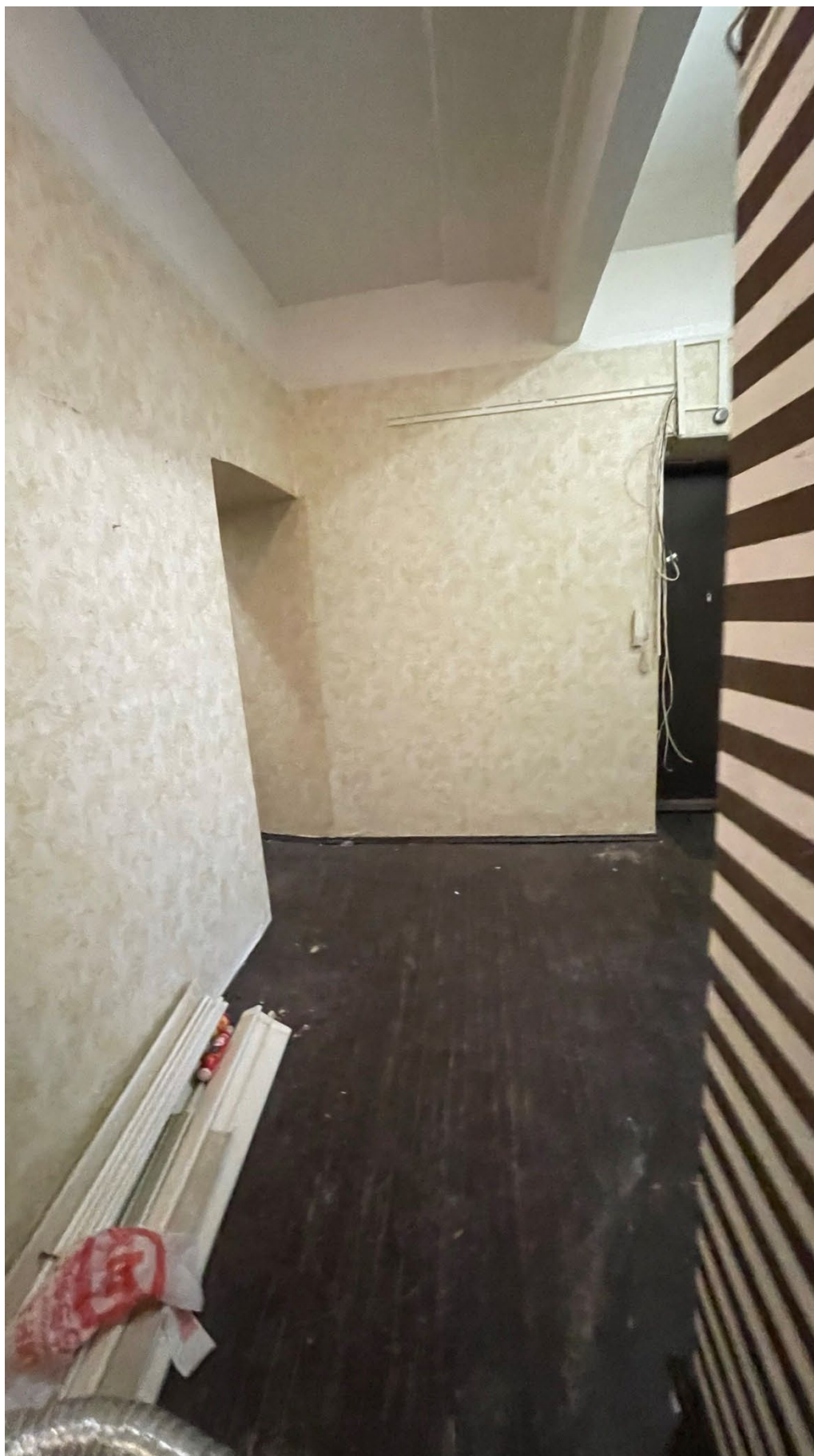
15. Фрагмент интеръера коридора (помещение 5/25.2);
