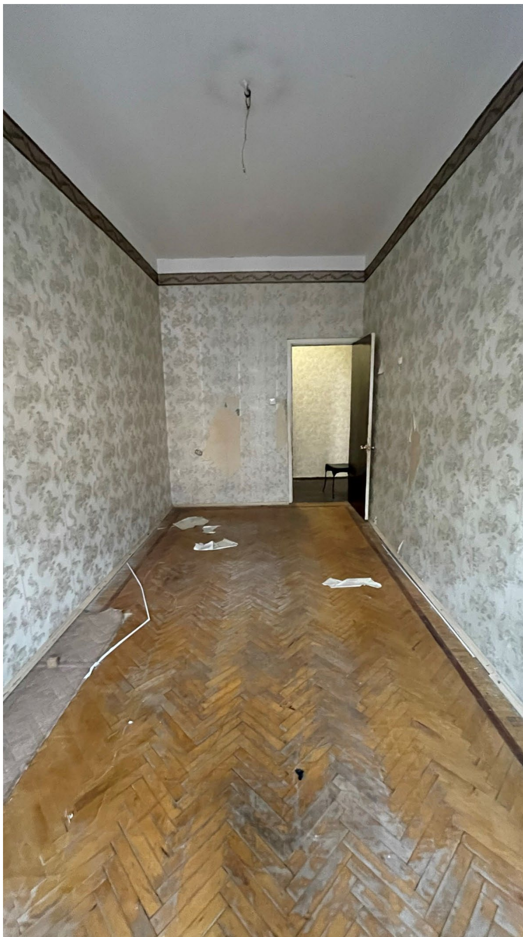
20.Фрагмент интерьера комнаты (помещение №3/17.4);
