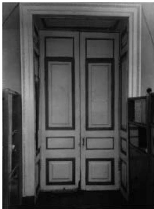
71. Дверь в золотую гостиную. Фото 1995. Архив КГИОП.
