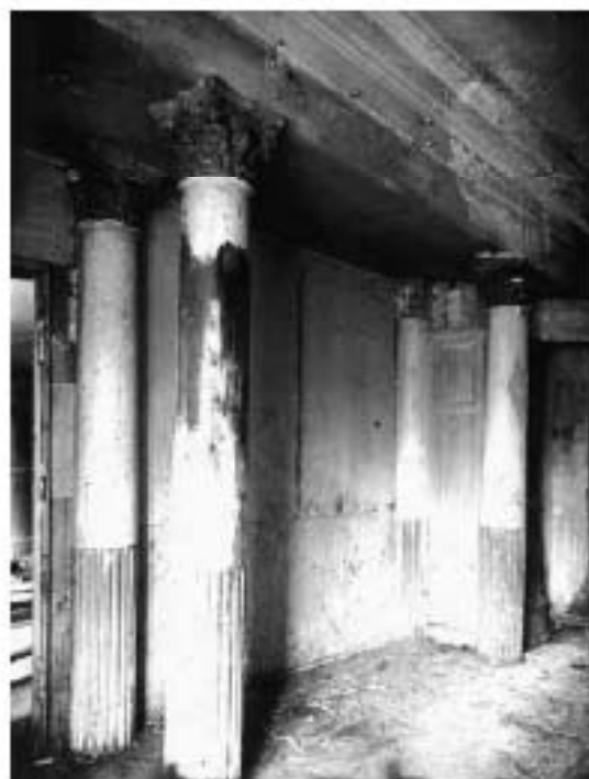
64. Колонны в главном парадном вестибюле. Фото 1946. Архив КТИОП.
