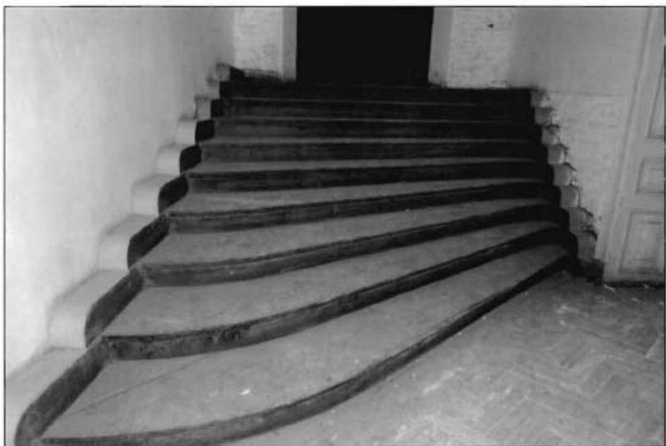
23. Интерьер объекта культурного наследия. Фрагмент. Пом. 3-Н(33). Лицевой корпус. Деревянная лестница в северный церковный флигель (фото от 11.05.2022).
