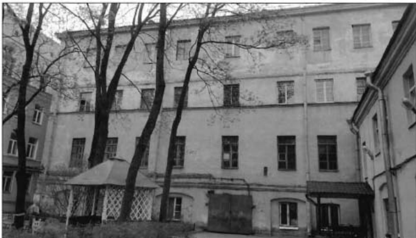
3. Восточный фасад восточного (поперечного) флигеля объекта культурного наследия. Общий вид (фото от 11.05.2022).
