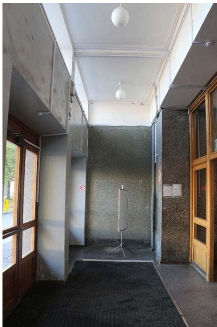
8. Подъезд №2. Входная группа. Интерьер тамбура объекта культурного наследия федерального значения «Райсовет Кировский», расположенного по адресу: г. Санкт-Петербург, пр. Стачек, д. 18, литера А. 09.11.2022.
