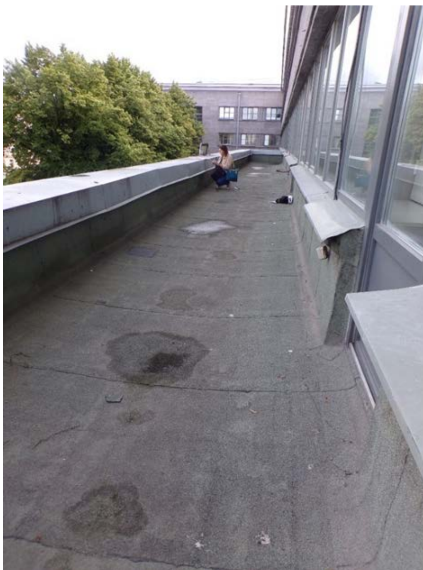
4. Общий вид покрытия балкона в осях 3-8 северо-западного фасада объекта культурного наследия федерального значения «Райсовет Кировский», расположенного по адресу: г. Санкт-Петербург, пр. Стачек, д. 18, литера А. 09.11.2022.
