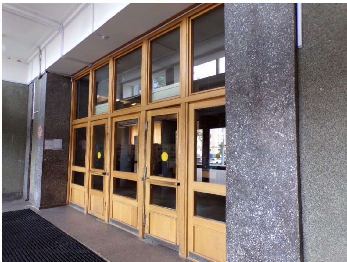
9. Подъезд №2. Входная группа. Интерьер тамбура объекта культурного наследия федерального значения «Райсовет Кировский», расположенного по адресу: г. Санкт-Петербург, пр. Стачек, д. 18, литера А. 09.11.2022.
