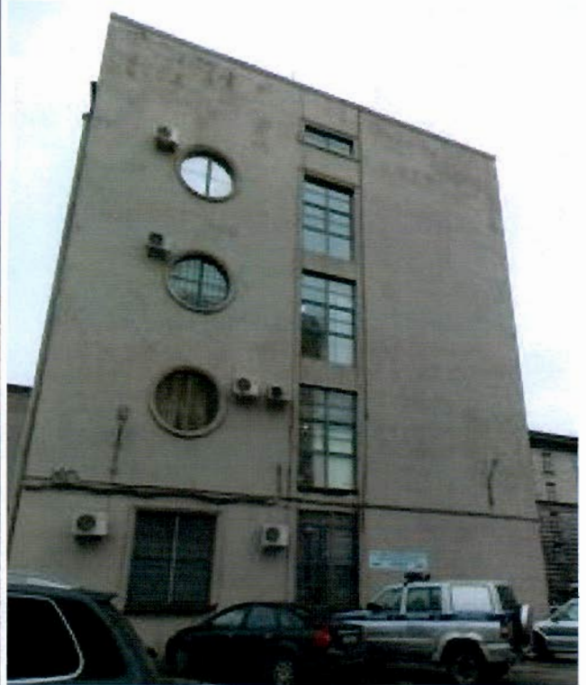
6. Основной объем. Торцевой фасад
