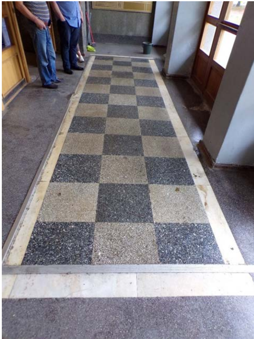
10. Подъезд №2. Входная группа. Интерьер тамбура объекта культурного наследия федерального значения «Райсовет Кировский», расположенного по адресу: г. Санкт-Петербург, пр. Стачек, д. 18, литера А. 09.11.2022.
