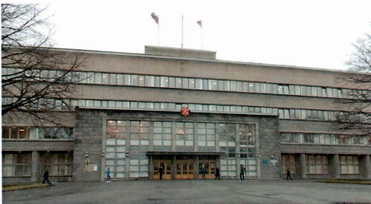
1. Лицевой фасад основного объема. Главный вход
