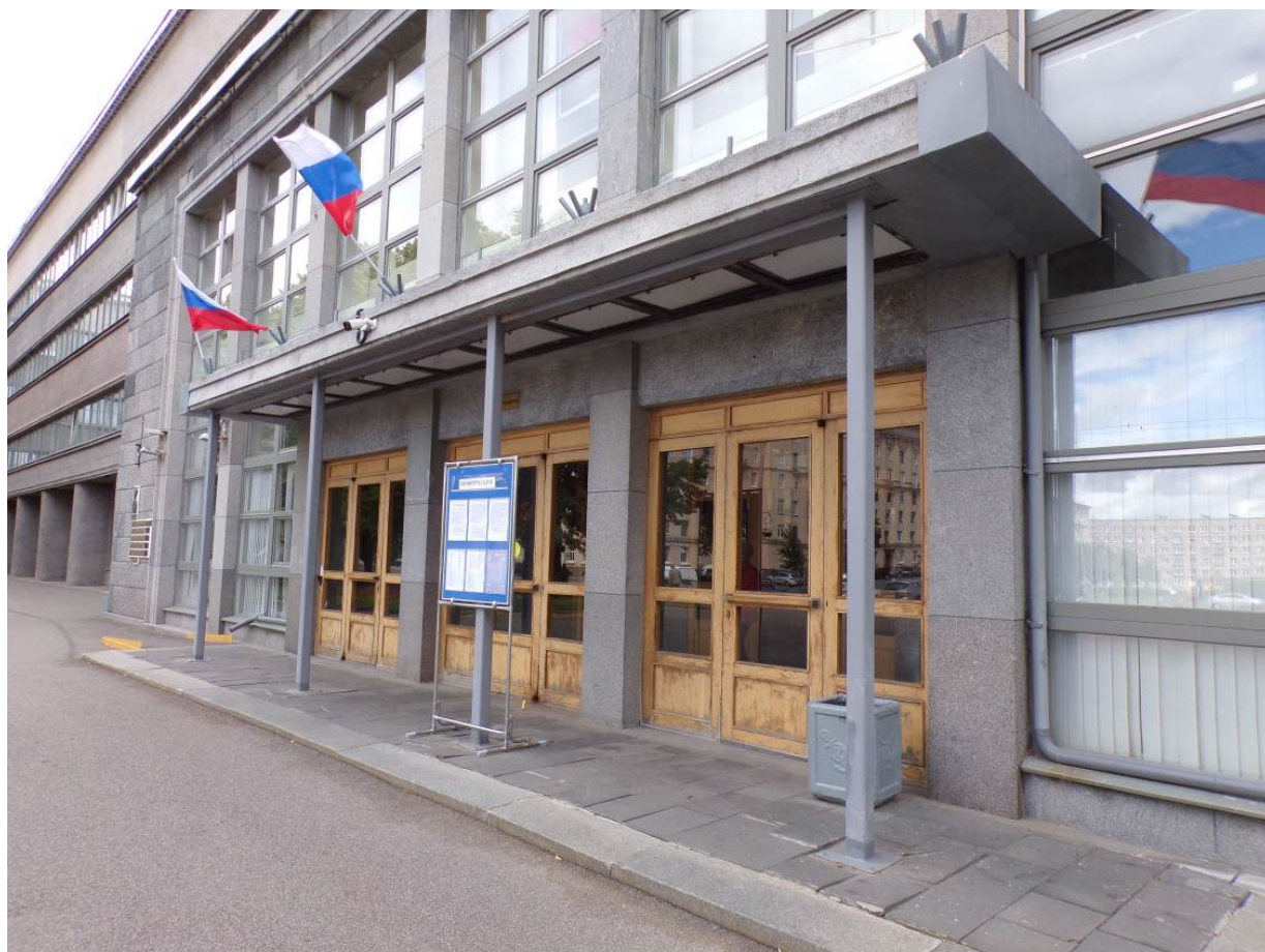
2. Подъезд №2 северо-западного фасада объекта культурного наследия федерального значения «Райсовет Кировский», расположенного по адресу: г. Санкт-Петербург, пр. Стачек, д. 18, литера А. 09.11.2022.
