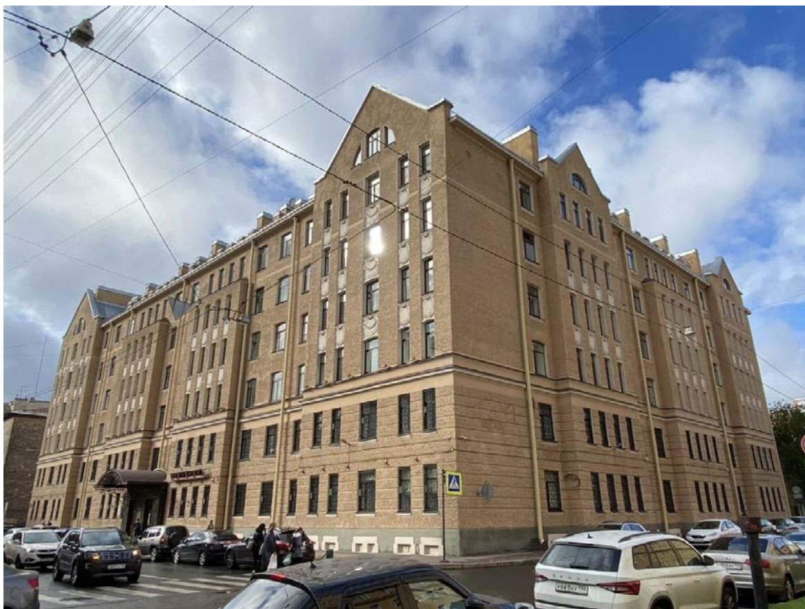
Фото 6. Вид на объект культурного наследия «Жилой дом Экспедиции заготовления государственных бумаг» (угол Дровяной ул. и Курляндской ул.).
