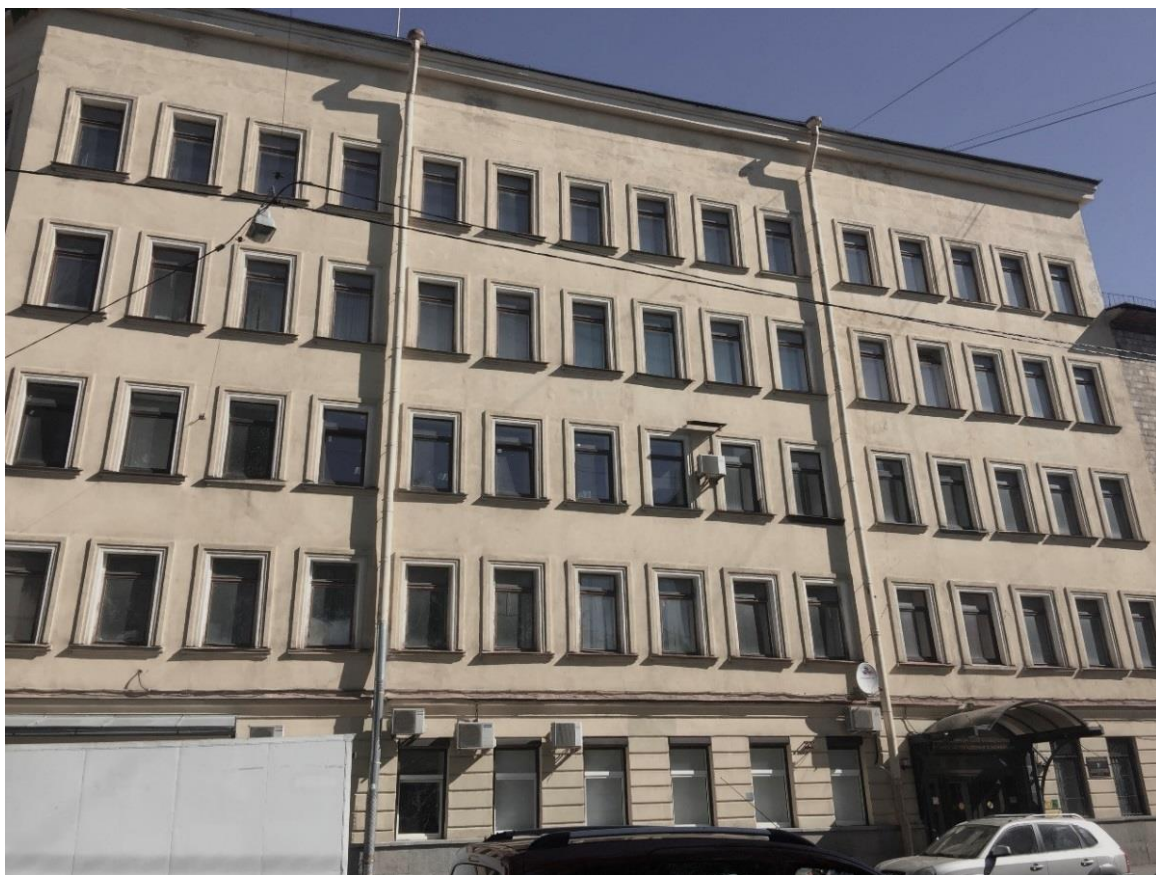
Фото 2. Вид на Объект по адресу: Рижский пр, д.26, лит. Б (подлитера Б2) Фасад по Курляндской улице.
