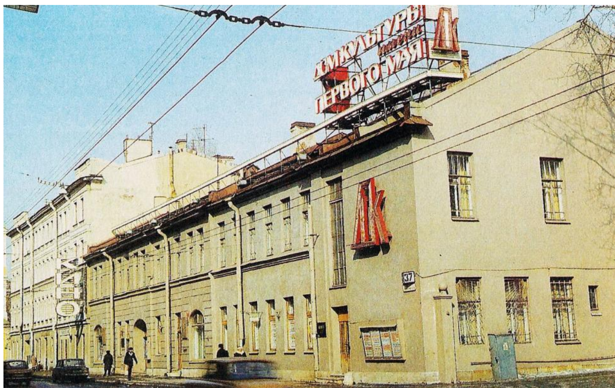
40. Дом культуры им. 1 Мая. Здесь в 1917 году работал VI съезд РСДРП(б).
