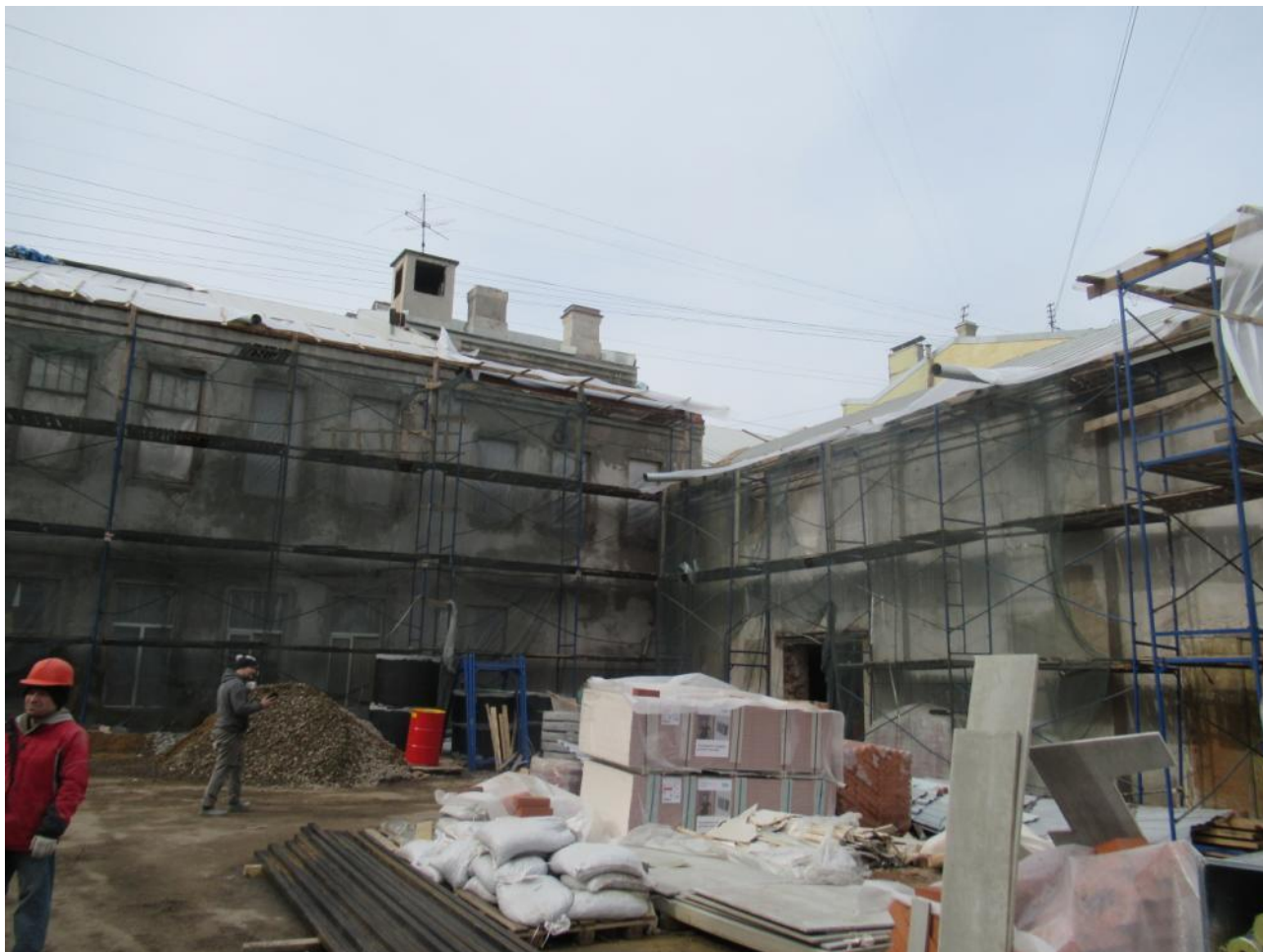
6. Фрагменты восточного фасада двухэтажного флигеля и южного фасада одноэтажной пристройки со стороны двора.
