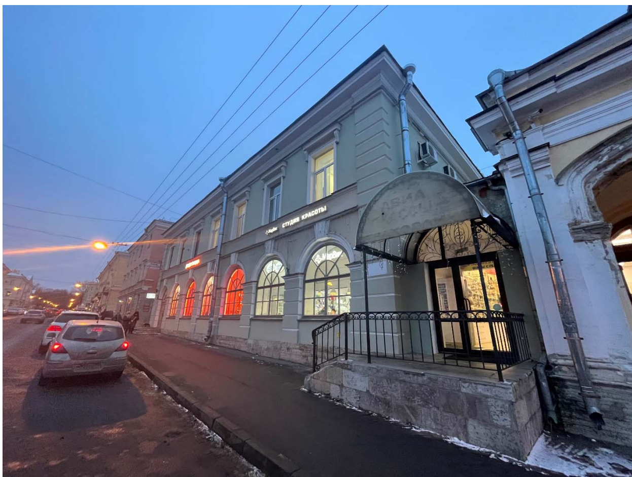
Фото №2. Лицевой юго-восточный фасад.
