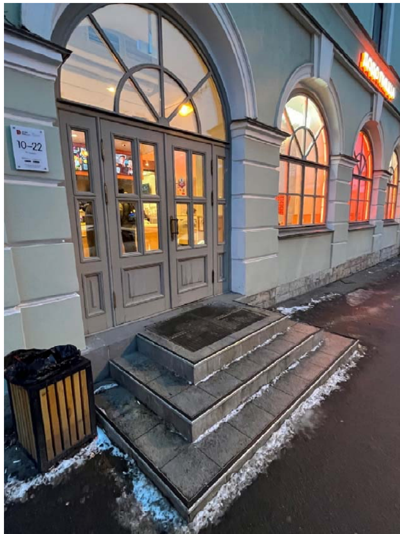
Фото №3. Лицевой юго-восточный фасад, главный вход, крыльцо.
