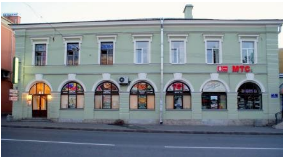
Илл. 24. Здание по адресу г. Пушкин, Оранжерейная ул., 20. 2011 г.
