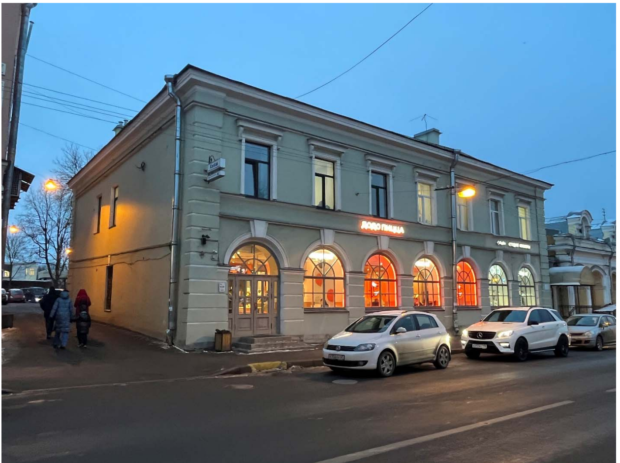
Фото №1. Лицевой юго-восточный фасад.
