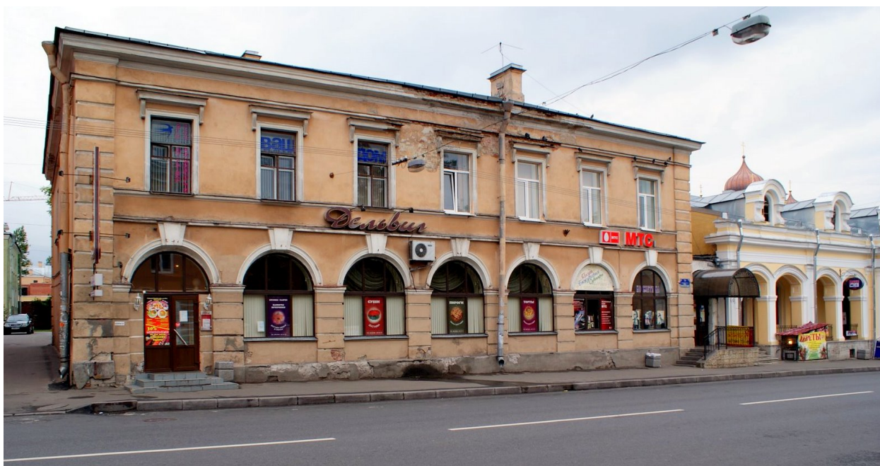
Илл. 23. Здание по адресу г. Пушкин, Оранжерейная ул., 20. 2010 г.
