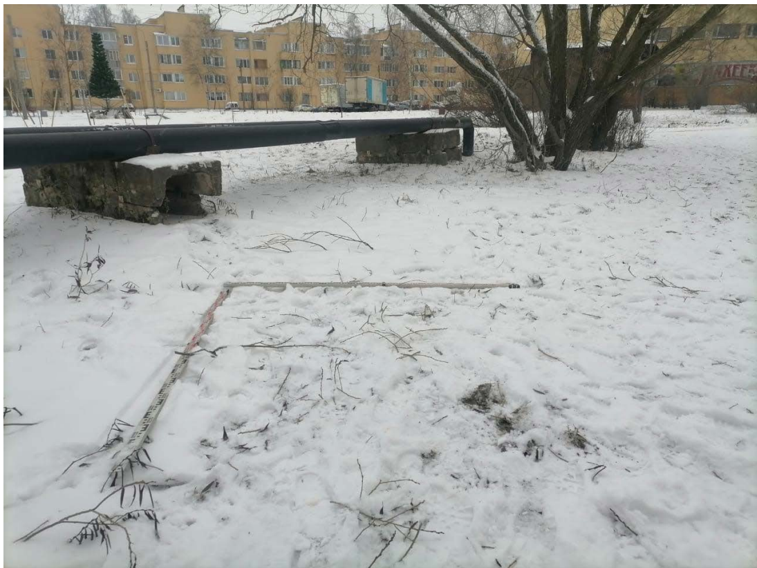
Рис. 20. СПб 2022, Пушкинский район «Реконструкция тепловых сетей отопления и ГВС от групповой котельной в пос. Шушары, Пулковское шоссе, д. 42, лит. А». Шурф 1. Вид шурфа 1 до начала работ. Вид с запада
