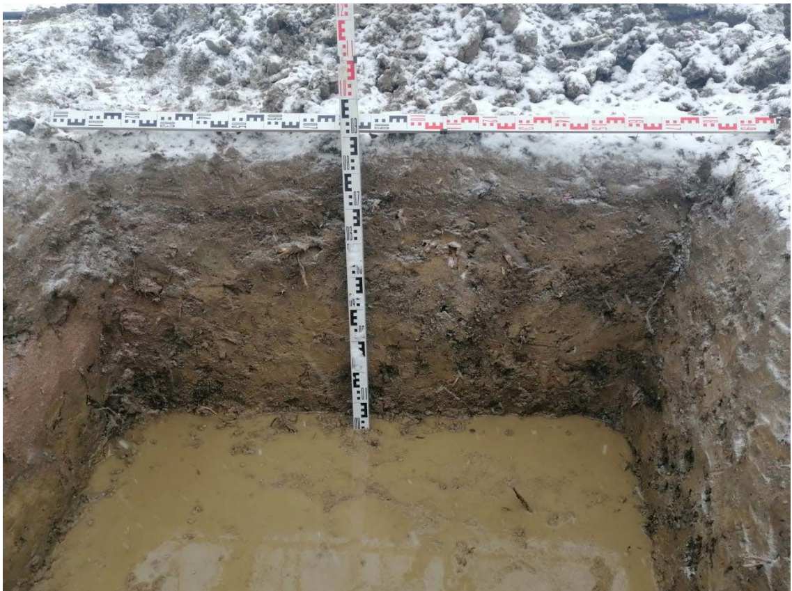
Рис. 26. СПб 2022, Пушкинский район «Реконструкция тепловых сетей отопления и ГВС от групповой котельной в пос. Шушары, Пулковское шоссе, д. 42, лит. А». Шурф 1. Фиксация по уровню грунтовых вод. Западная стенка.
