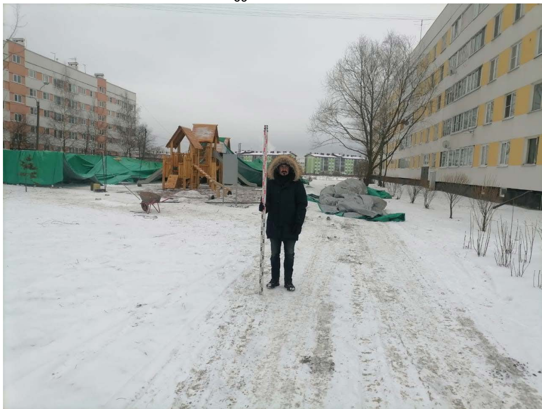
Рис. 10. СПб 2022, Пушкинский район «Реконструкция тепловых сетей отопления и ГВС от групповой котельной в пос. Шушары, Пулковское шоссе, д. 42, лит. А». Точка фотофиксации 4. Вид на юг.
