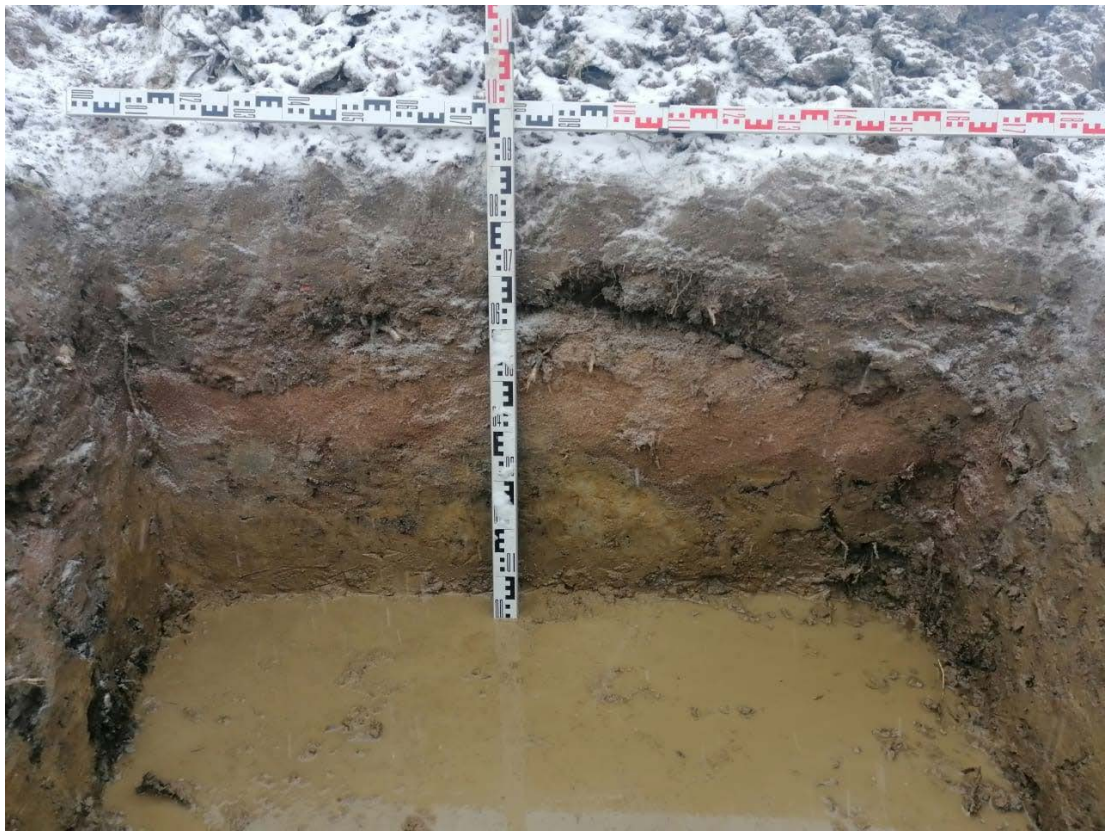
Рис. 28. СПб 2022, Пушкинский район «Реконструкция тепловых сетей отопления и ГВС от групповой котельной в пос. Шушары, Пулковское шоссе, д. 42, лит. А». Шурф 1. Фиксация по уровню грунтовых вод. Южная стенка.
