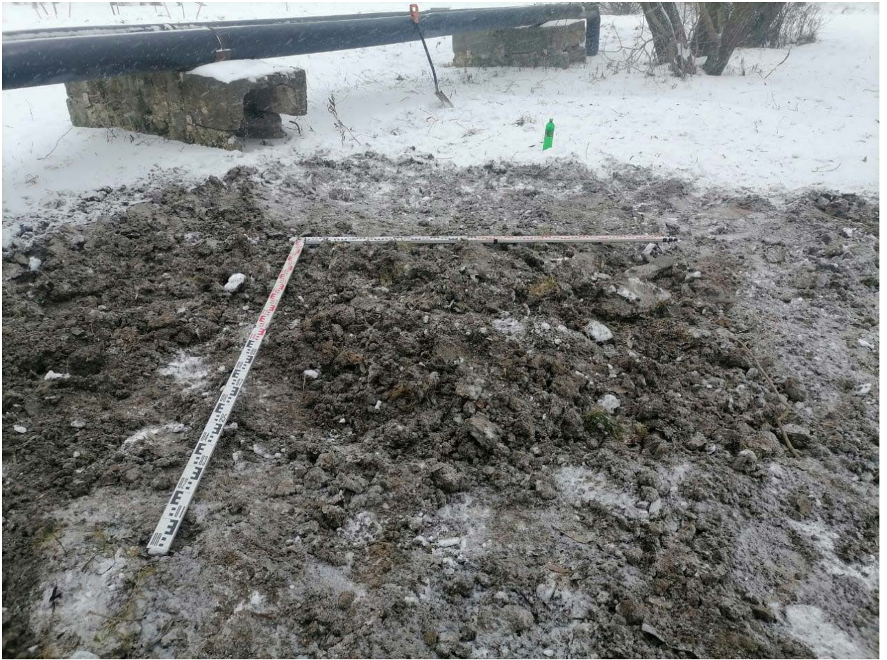
Рис. 29. СПб 2022, Пушкинский район «Реконструкция тепловых сетей отопления и ГВС от групповой котельной в пос. Шушары, Пулковское шоссе, д. 42, лит. А». Шурф 1. Фото рекультивированного шурфа. Вид с запада.
