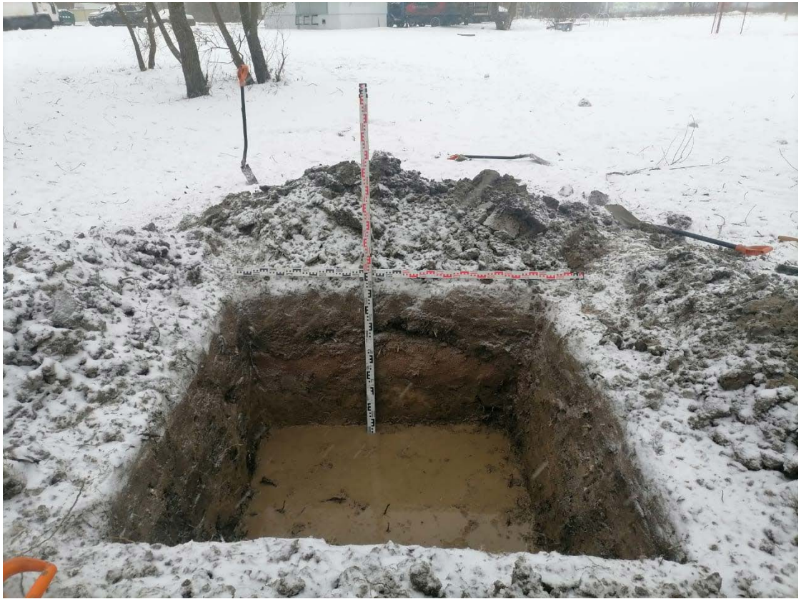
Рис. 27. СПб 2022, Пушкинский район «Реконструкция тепловых сетей отопления и ГВС от групповой котельной в пос. Шушары, Пулковское шоссе, д. 42, лит. А». Шурф 1. Фиксация по уровню грунтовых вод. Вид на юг.
