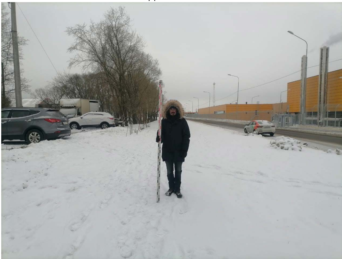
Рис. 14. СПб 2022, Пушкинский район «Реконструкция тепловых сетей отопления и ГВС от групповой котельной в пос. Шушары, Пулковское шоссе, д. 42, лит. А». Точка фотофиксации 8. Вид на юго-запад.
