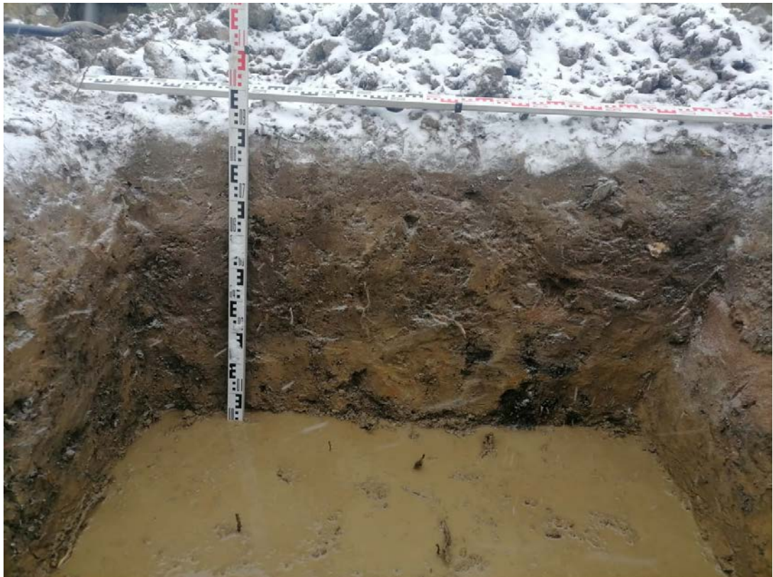
Рис. 22. СПб 2022, Пушкинский район «Реконструкция тепловых сетей отопления и ГВС от групповой котельной в пос. Шушары, Пулковское шоссе, д. 42, лит. А». Шурф 1. Фиксация по уровню грунтовых вод. Восточная стенка.
