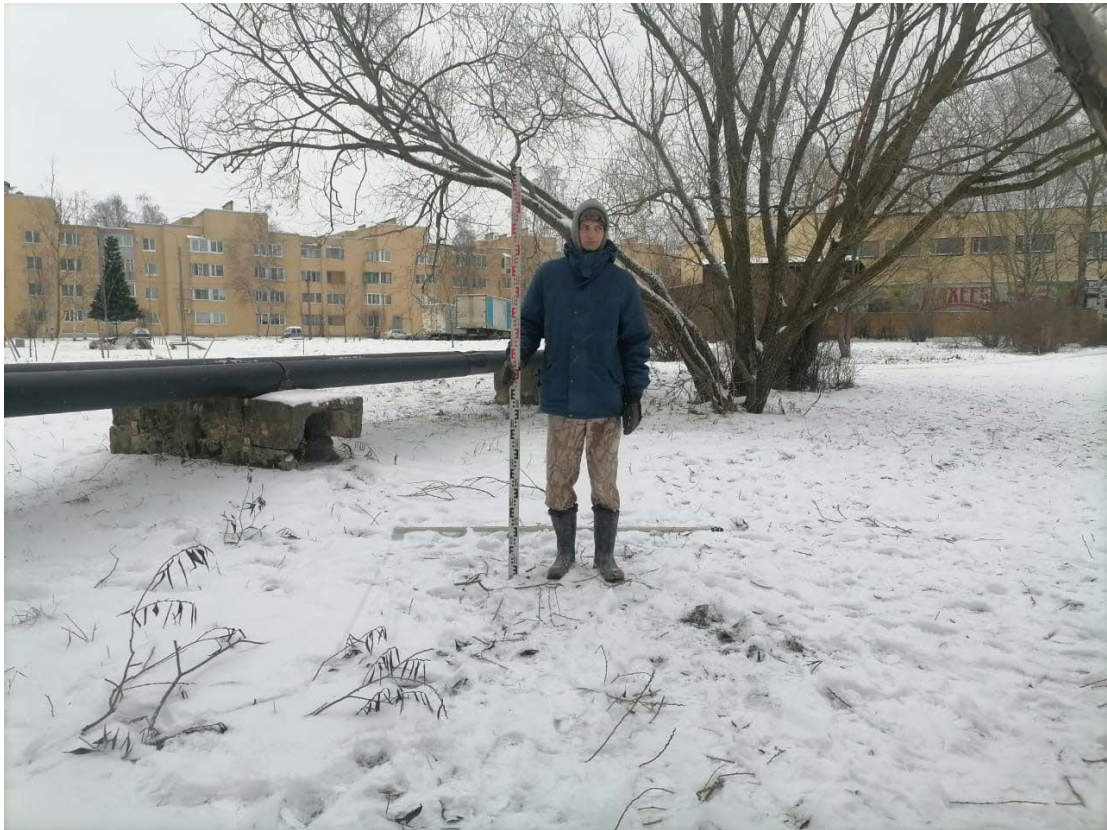
Рис. 19. СПб 2022, Пушкинский район «Реконструкция тепловых сетей отопления и ГВС от групповой котельной в пос. Шушары, Пулковское шоссе, д. 42, лит. А». Общий вид до начала работ. Вид с юга.
