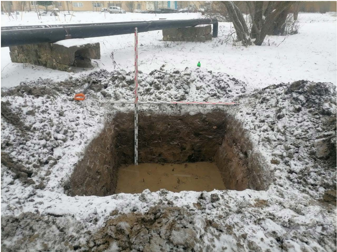
Рис. 21. СПб 2022, Пушкинский район «Реконструкция тепловых сетей отопления и ГВС от групповой котельной в пос. Шушары, Пулковское шоссе, д. 42, лит. А». Шурф 1. Фиксация по уровню грунтовых вод. Вид на восток.
