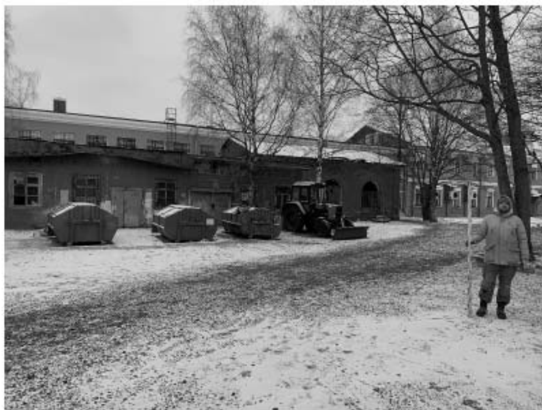
Рис. 37. г. Санкт-Петербург, Кронштадтский район, г. Кронштадт, ул. Макаровская, д.2 – 2022 г. Точка фиксации №5. Вид с ЮЗ.
