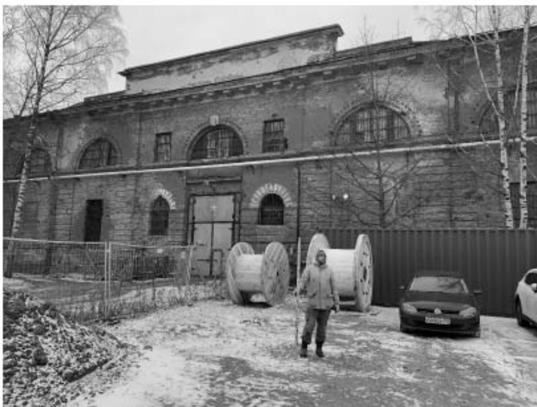
Рис. 32. г. Санкт-Петербург, Кронштадтский район, г. Кронштадт, ул. Макаровская, д.2 – 2022 г. Точка фиксации №3. Вид с В.
