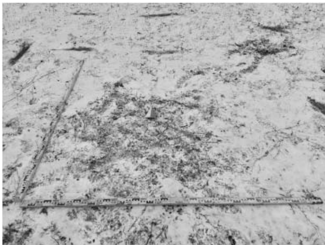
Рис. 43. г. Санкт-Петербург, Кронштадтский район, г. Кронштадт, ул. Макаровская, д.2 – 2022 г. Шурф №1. До начала работ. Вид с Ю.
