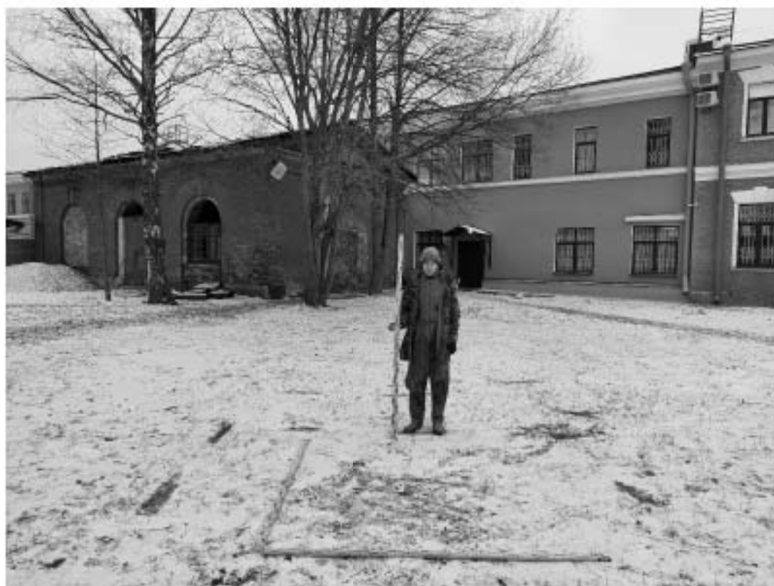
Рис. 42. г. Санкт-Петербург, Кронштадтский район, г. Кронштадт, ул. Макаровская, д.2 – 2022 г. Шурф №1. Местоположение. Вид с Ю.
