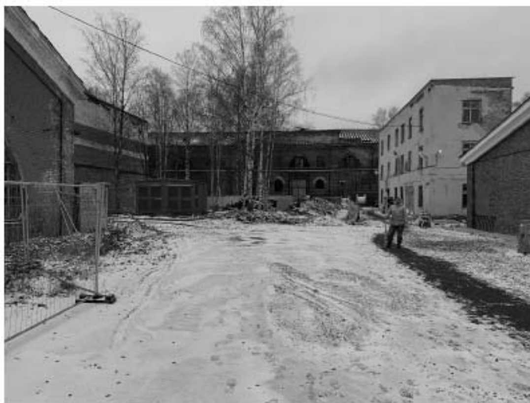
Рис. 33. г. Санкт-Петербург, Кронштадтский район, г. Кронштадт, ул. Макаровская, д.2 – 2022 г. Точка фиксации №4. Вид с ЮВ.
