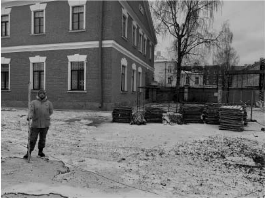
Рис. 38. г. Санкт-Петербург, Кронштадтский район, г. Кронштадт, ул. Макаровская, д.2 – 2022 г. Точка фиксации №6. Вид с Ю.
