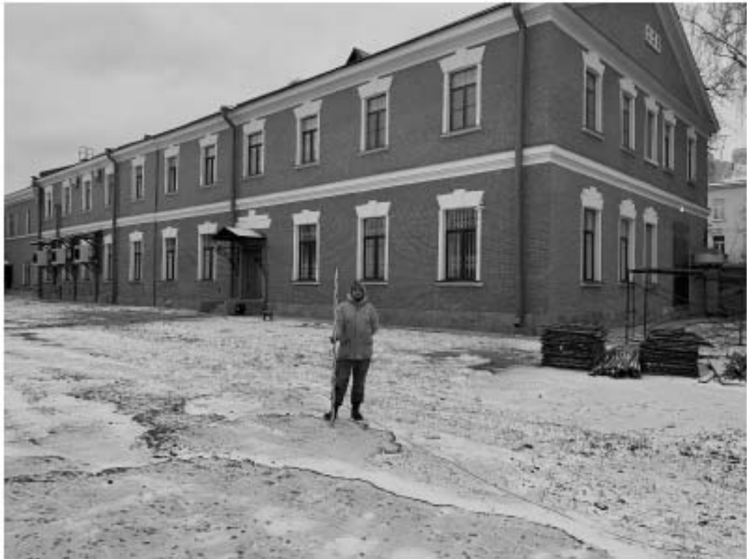
Рис. 39. г. Санкт-Петербург, Кронштадтский район, г. Кронштадт, ул. Макаровская, д.2 – 2022 г. Точка фиксации №6. Вид с ЮВ.
