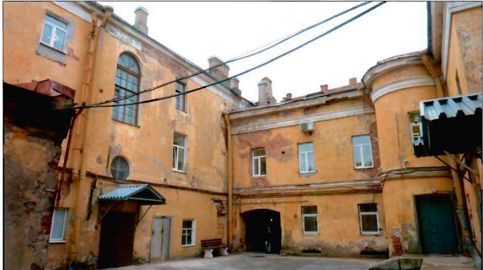
15. Фасады объекта культурного наследия, выходящие на северо-восточную дворовую территорию.
