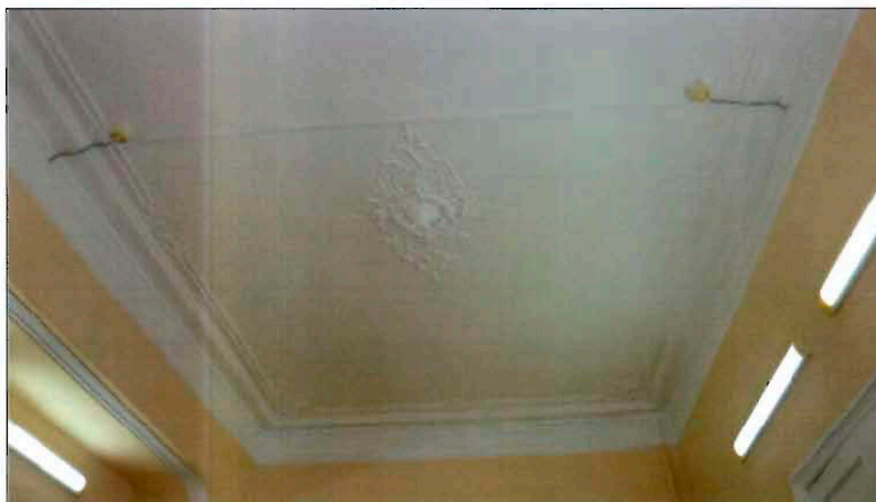
30. Оформление потолка в пом. 52-Н (8).
