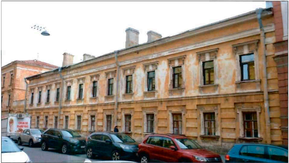
18. Объект культурного наследия. Лицевой фасад двухэтажного корпуса по ул. Почтамтской. Вид с запада.
