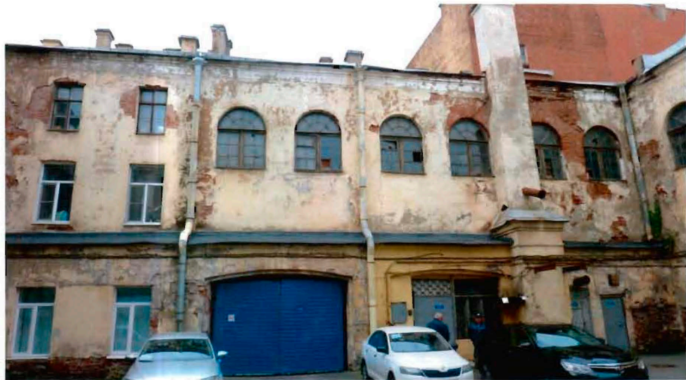
9. Юго-западный двор. Вид с севера.
