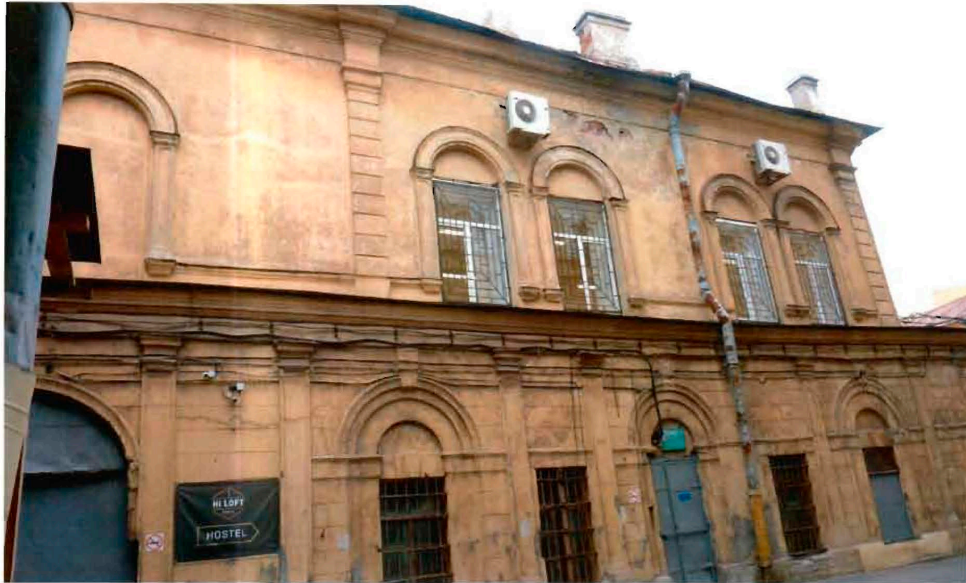
6. Объект культурного наследия. Северный фасад дворового корпуса.
