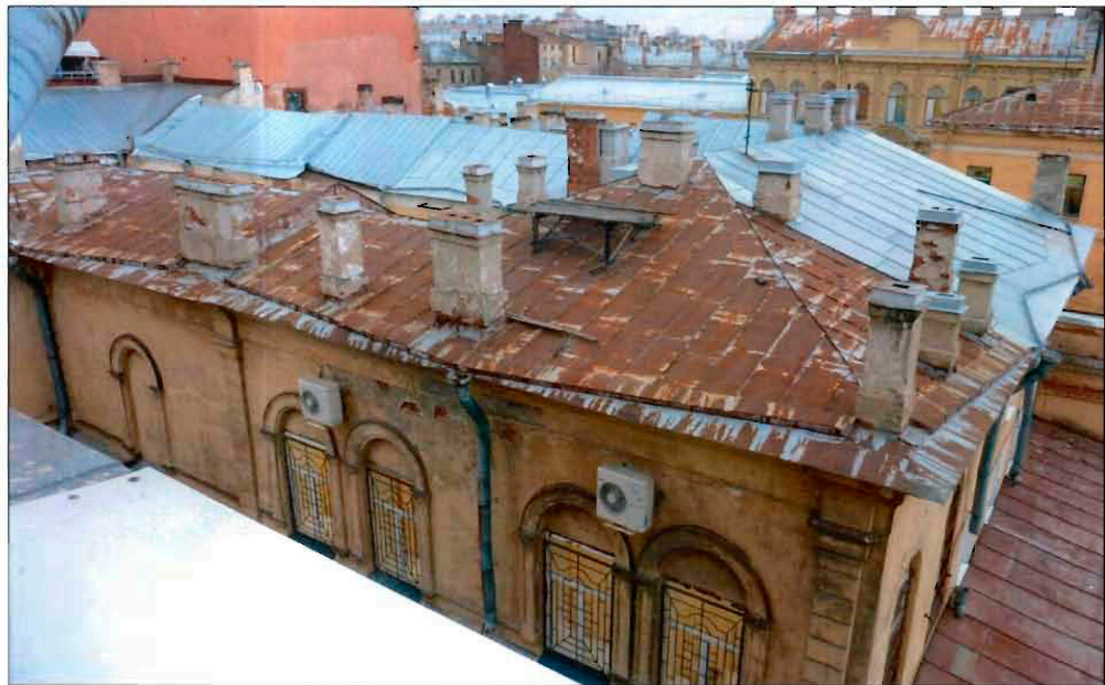
19. Объект культурного наследия. Вид с юго-востока на кровлю дворовых флигелей.
