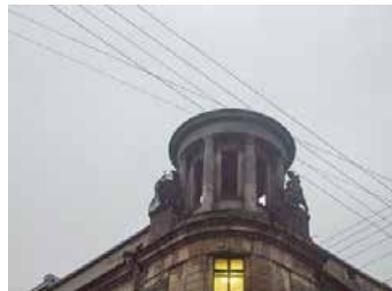
лопатки, оформленные дощатым рустом; междуэтажная профилированная тяга в уровне 2-3-го этажей; венчающий профилированный карниз;
