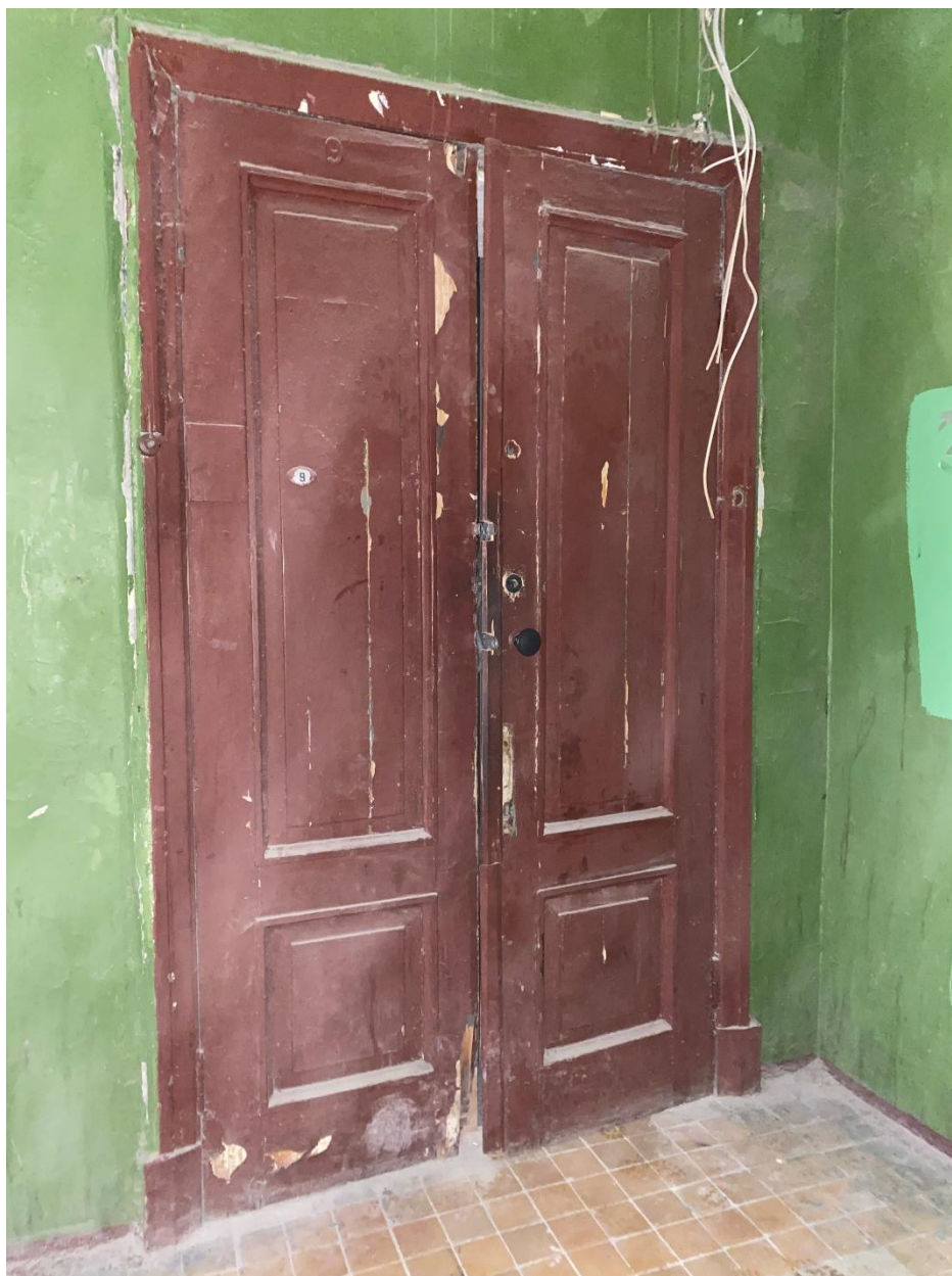
Фото 14. Вид на входной дверной проем квартиры № 9 в 11 ЛК.
