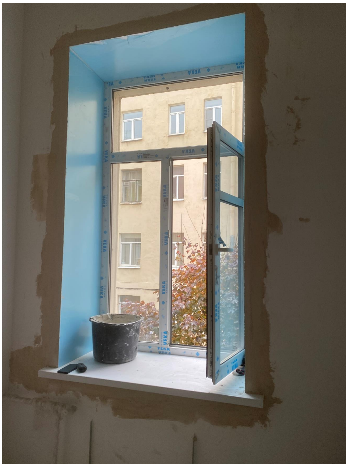
Фото 30. Вид оконный проем в помещении № 6 (западная часть).
