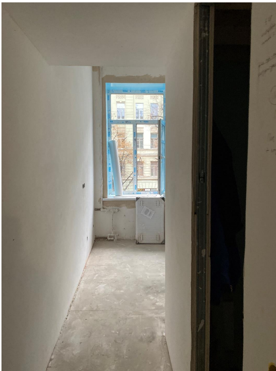
Фото 26. Вид на помещение № 10 (восточная часть).
