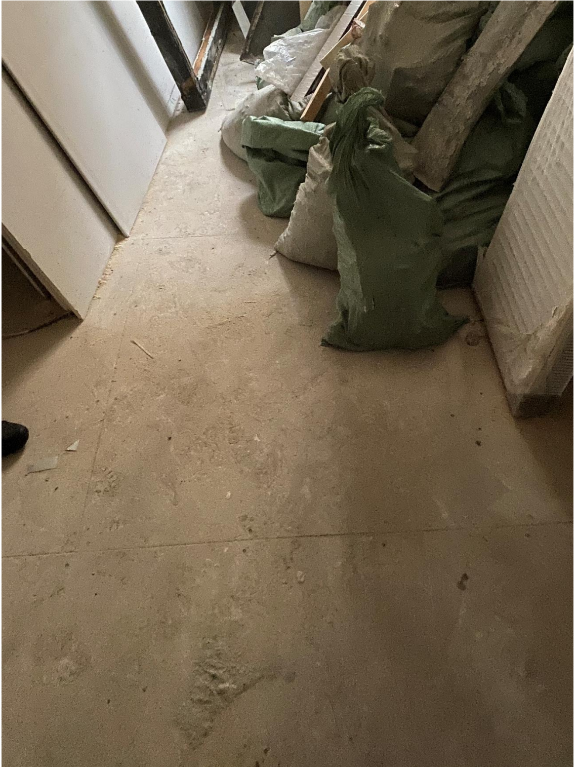
Фото 18. Вид на помещение № 3.
