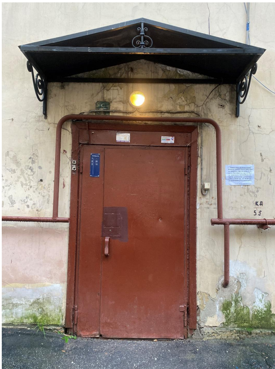
Фото 13. Вход в 10ЛК.
