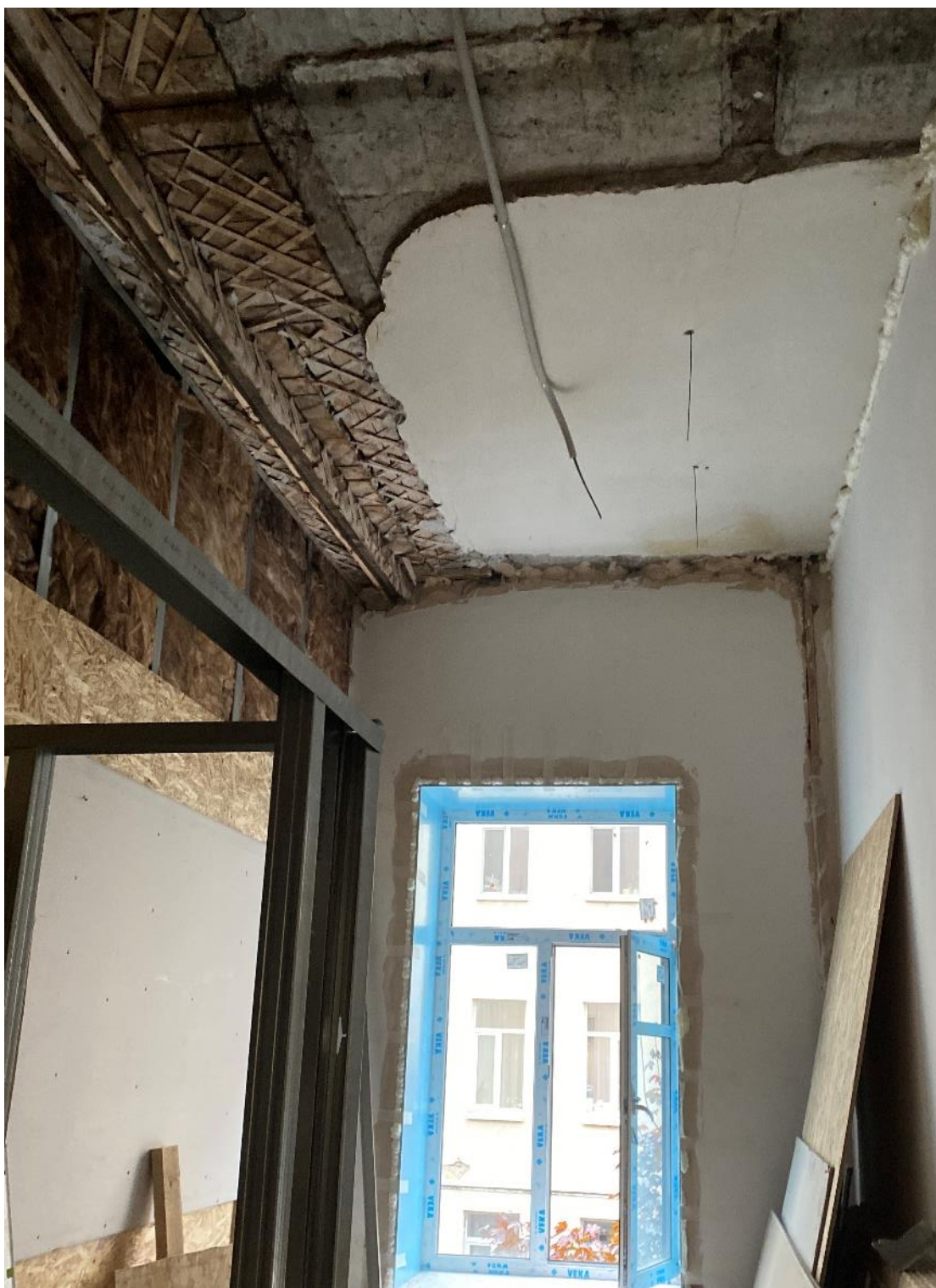
Фото 23. Вид на помещение № 11 (восточная часть).
