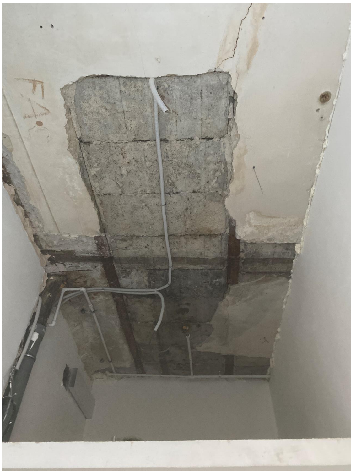
Фото 31. Вид на потолок в помещении № 5.
