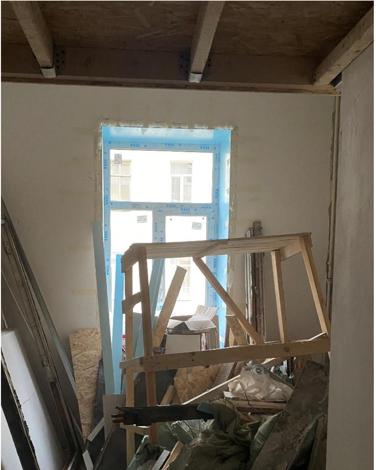
Фото 17. Вид на помещение № 2.
