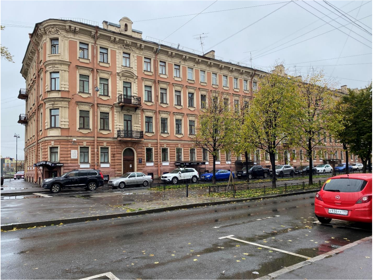
Фото 3. Вид на южный лицевой корпус с юго-запада.
