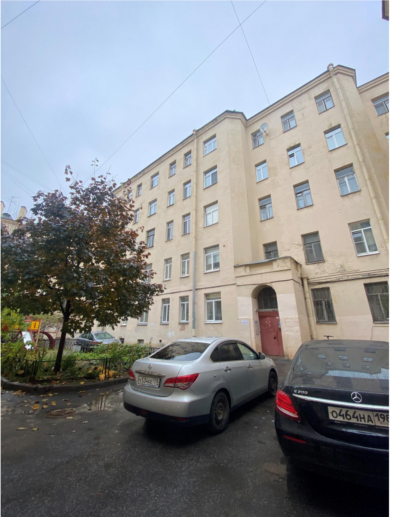
Фото 10. Вид на центральный дворовый корпус.
