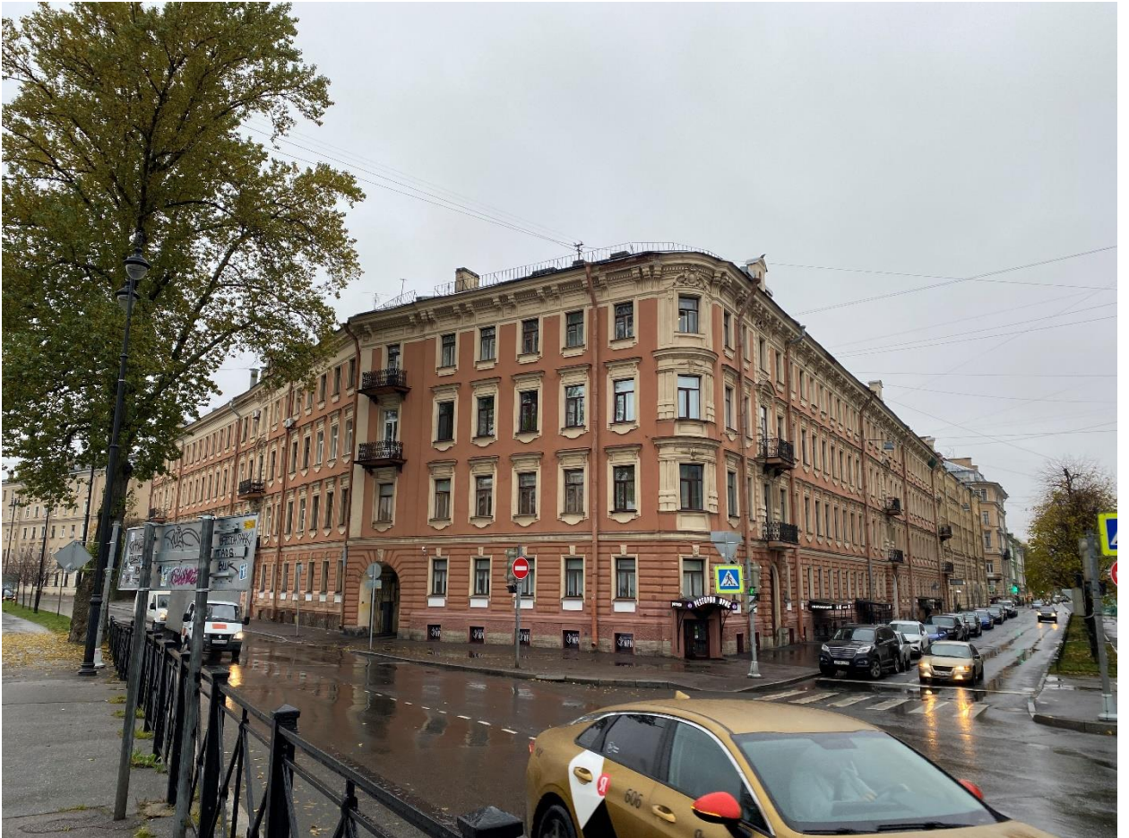
Фото 4. Вид на юго-западный угол здания.
