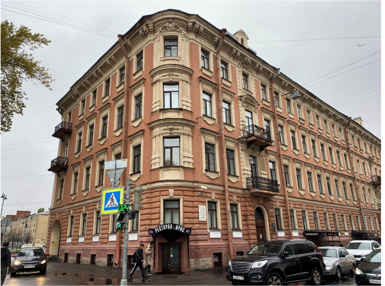
Фото 5. Вид на юго-западный угол здания.
