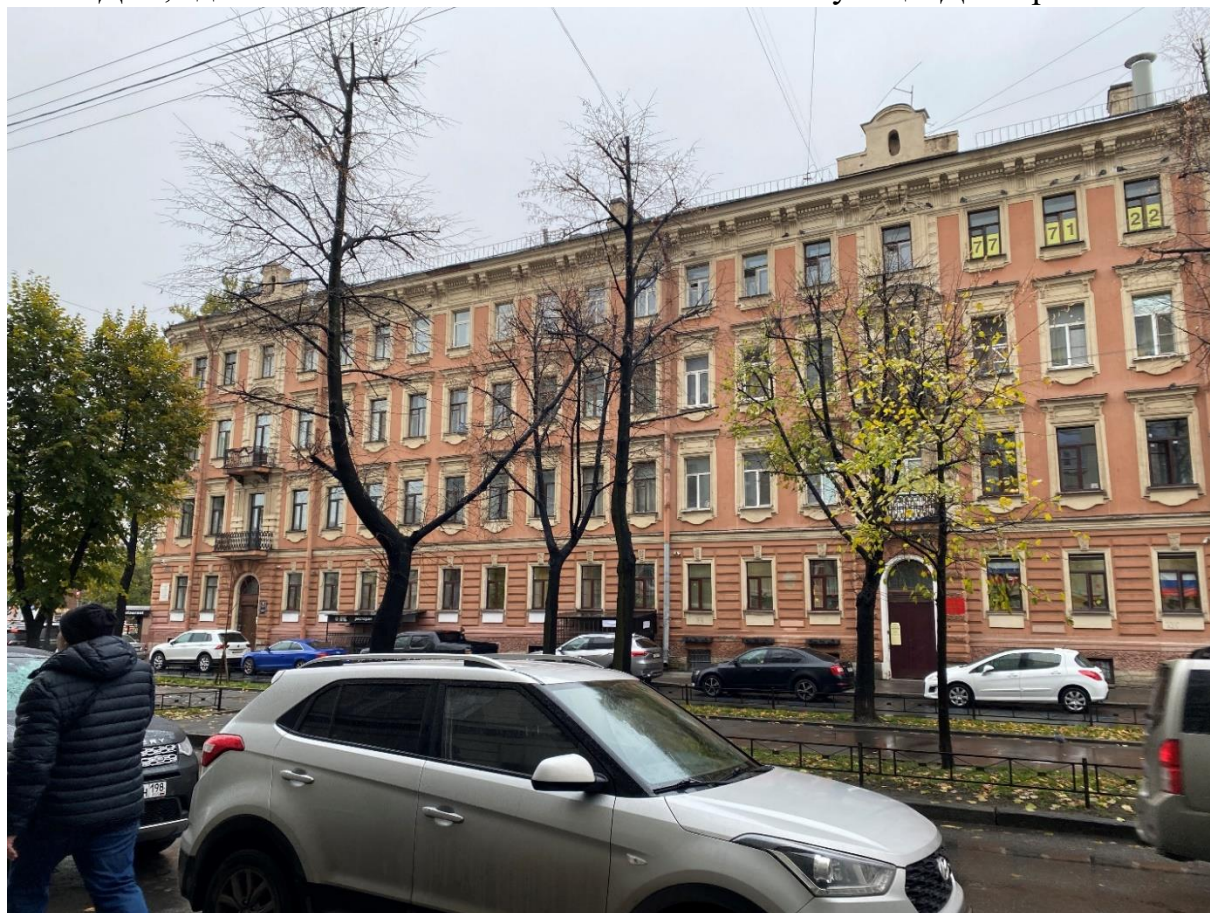
Фото 2. Вид на южный фасад южного лицевого корпуса.
