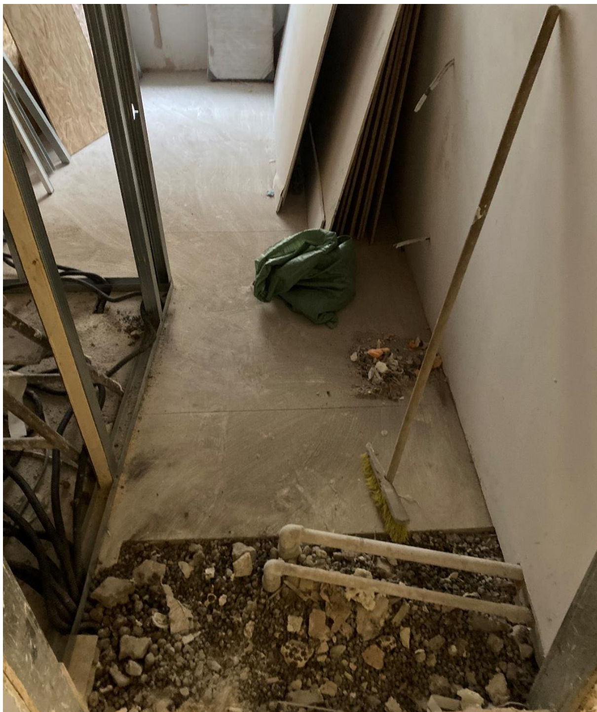
Фото 22. Вид на помещение № 11 (западная часть).
