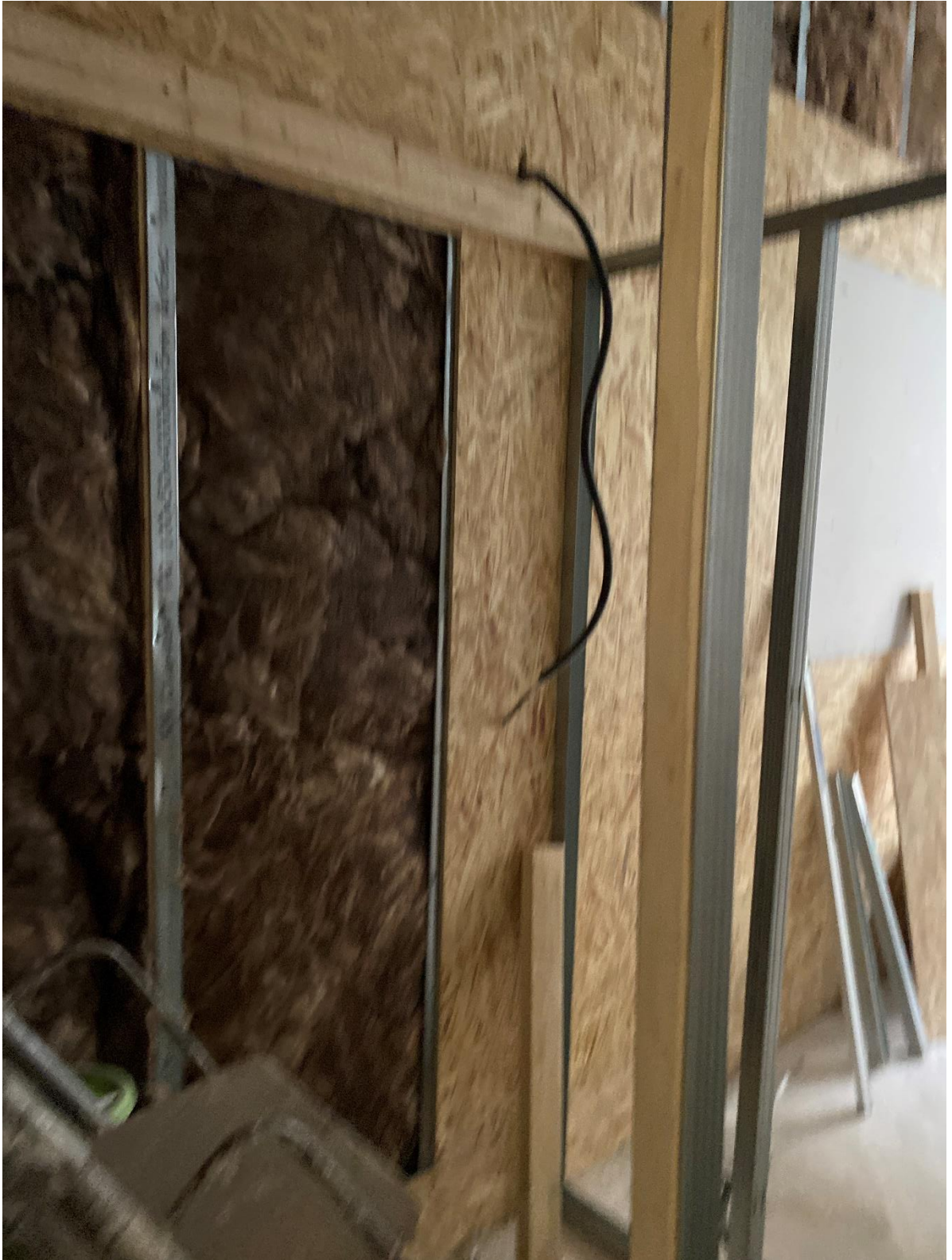
Фото 29. Вид на помещение № 10 (западная часть).
