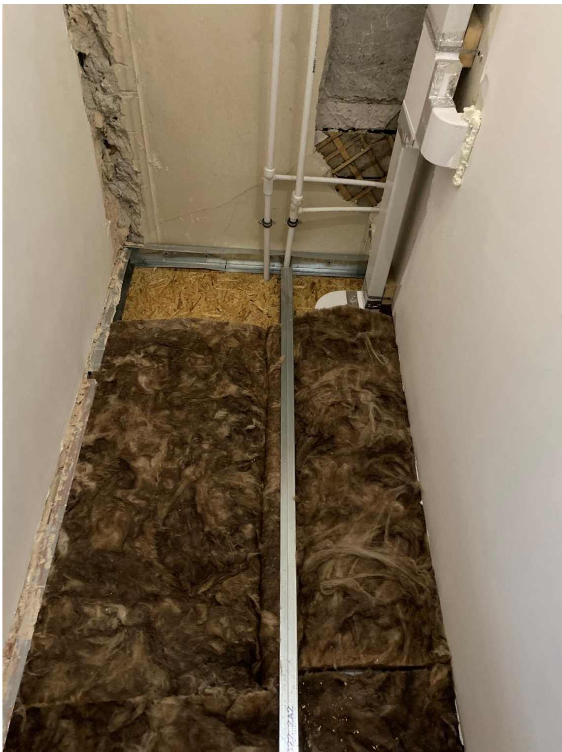
Фото 28. Вид на зашитый дверной проем между помещениями № 9 и № 1.
