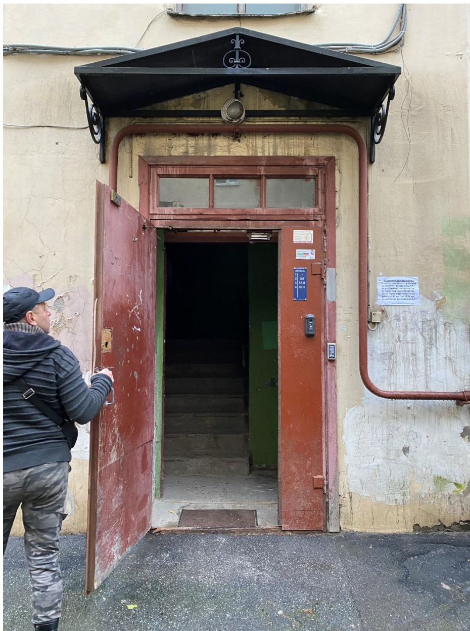
Фото 12. Вход в 11ЛК.
