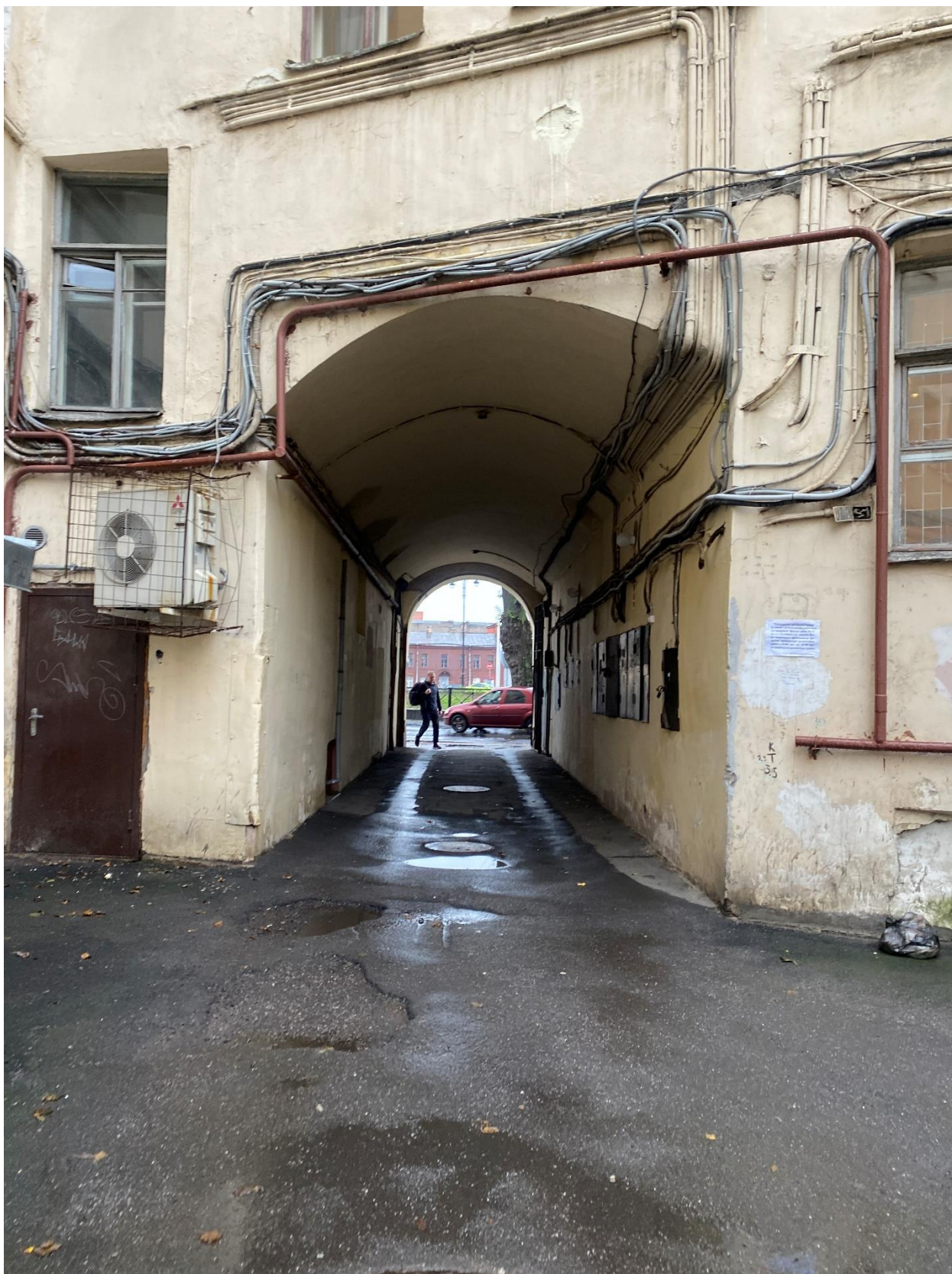
Фото 8. Вид на арку воротного проезда в западном лицевом корпусе.
