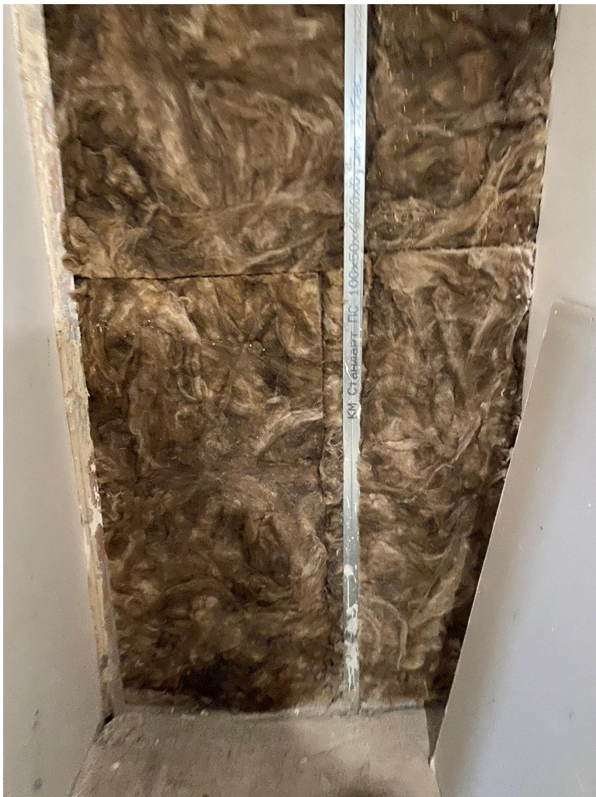
Фото 27. Вид на зашитый дверной проем между помещениями № 9 и № 1.
