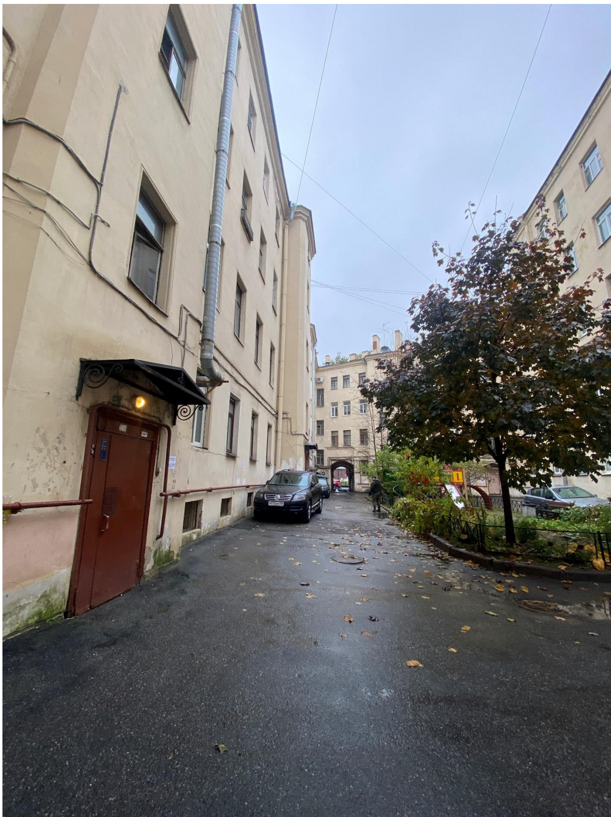
Фото 11. Вид на восточный фасад южного лицевого корпуса и восточный фасад западного лицевого корпуса.
