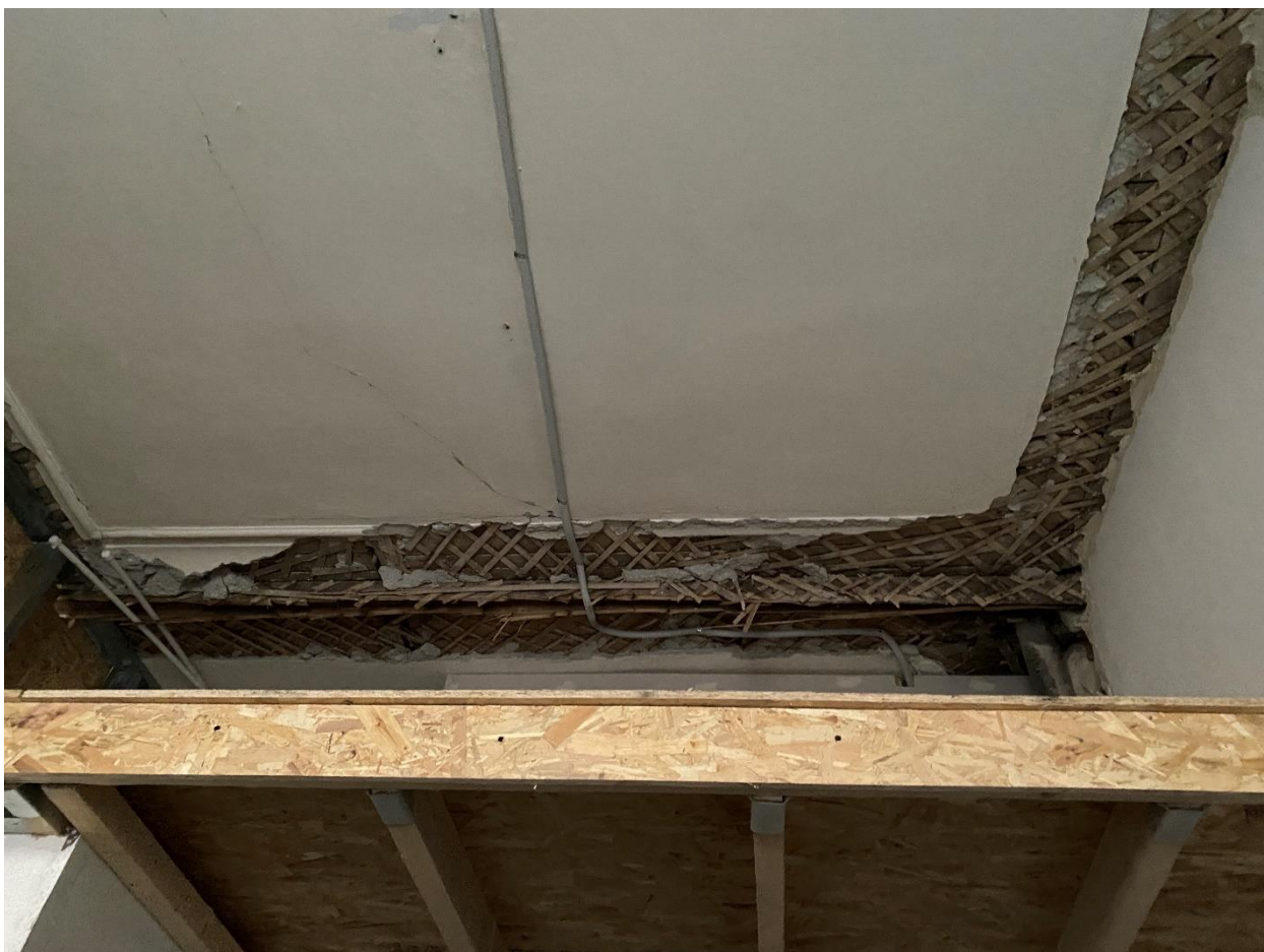
Фото 19. Вид на помещение № 3.
