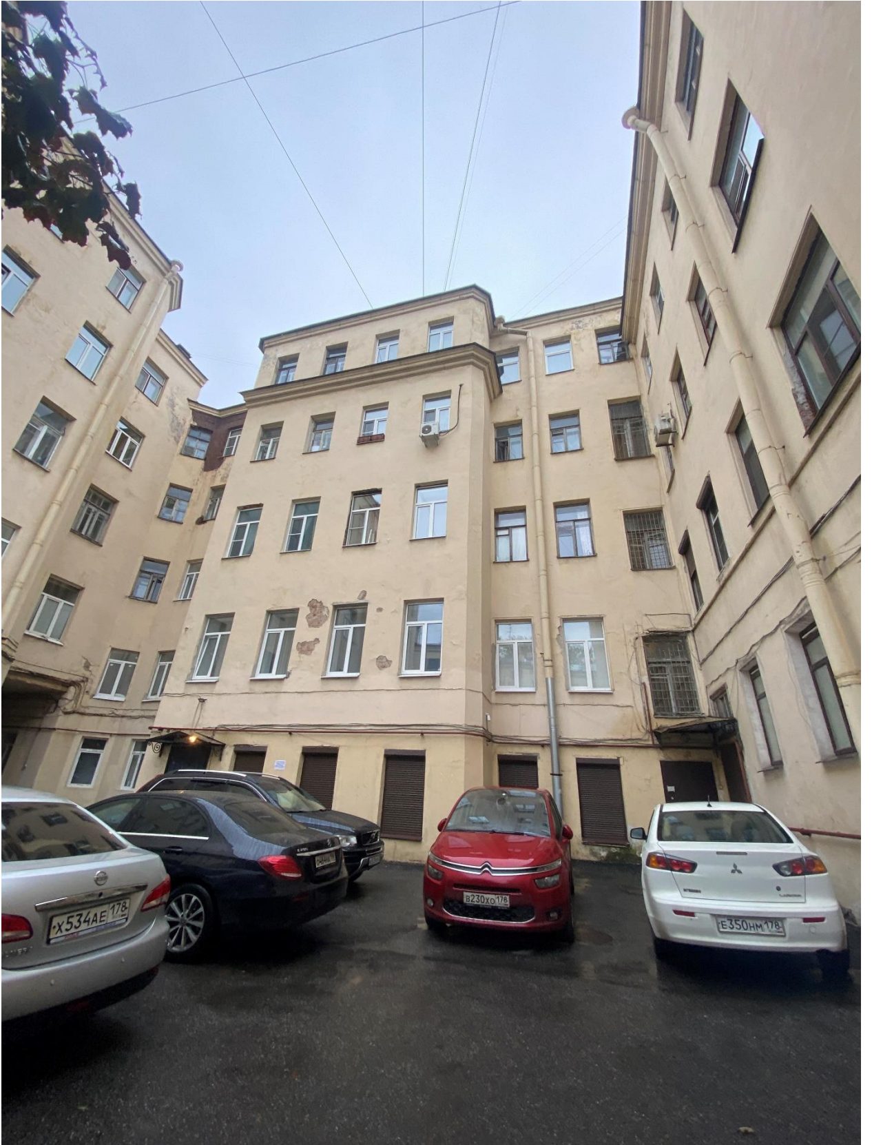
Фото 9. Вид на восточный дворный корпус.
