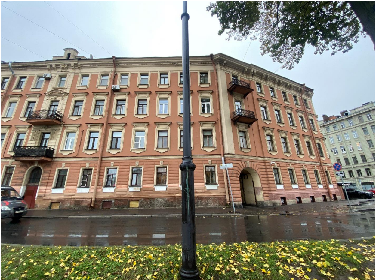
Фото 6. Вид на восточную часть западного фасада западного лицевого корпуса.
