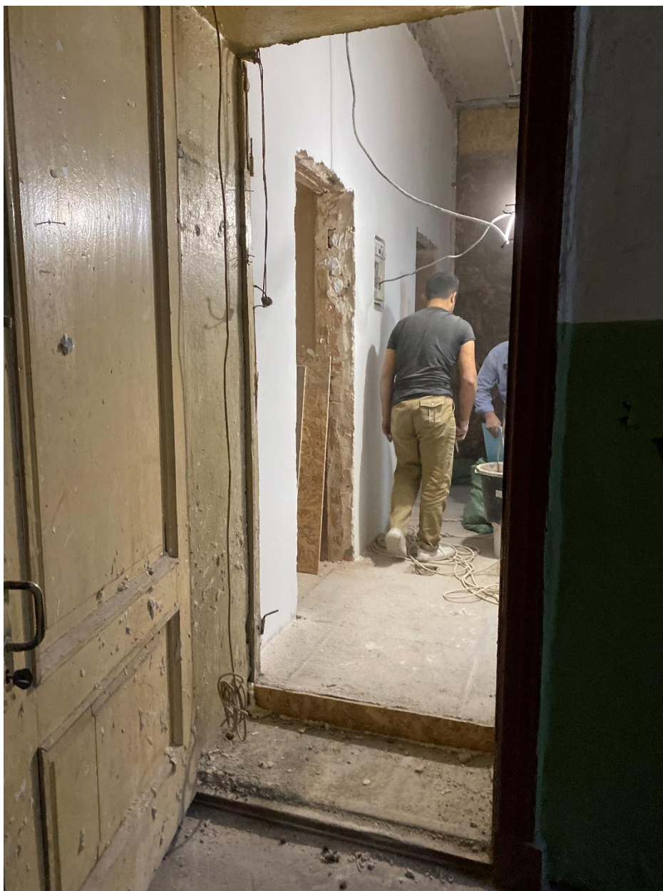
Фото 24. Вид на входной дверной проем квартиры № 9 в 10ЛК.
