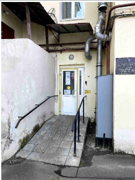
11. Общий вид дверного проема по 1-й световой оси восточного дворового фасада объекта культурного наследия регионального значения «Жилой дом», по адресу: г. Ломоносов, Дворцовый пр., д. 55/8, литера А.
