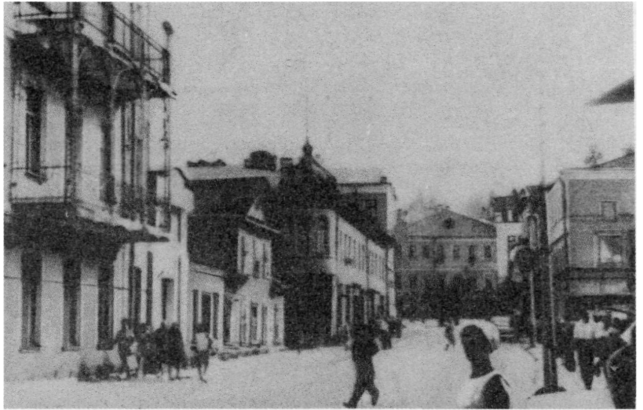
11. Застройка XIX в. Петербургской улицы. Слева — дома Савельева, Чулковой (деревянный, разрушен), Туркина (надстроен). Фото К. В. Овчинникова 1972 г. Горбатенко С.Б. Петергофская дорога. Ораниенбаумский историко-ландшафтный комплекс. СПб.: Дмитрий Буланин, 1998.
