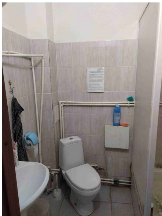
25. Фрагмент пом. № 1-Н (23) в уровне 1-го этажа объекта культурного наследия регионального значения «Жилой дом», расположенного по адресу: Санкт-Петербург, г. Ломоносов, Дворцовый проспект, дом 55/8, литера А.
