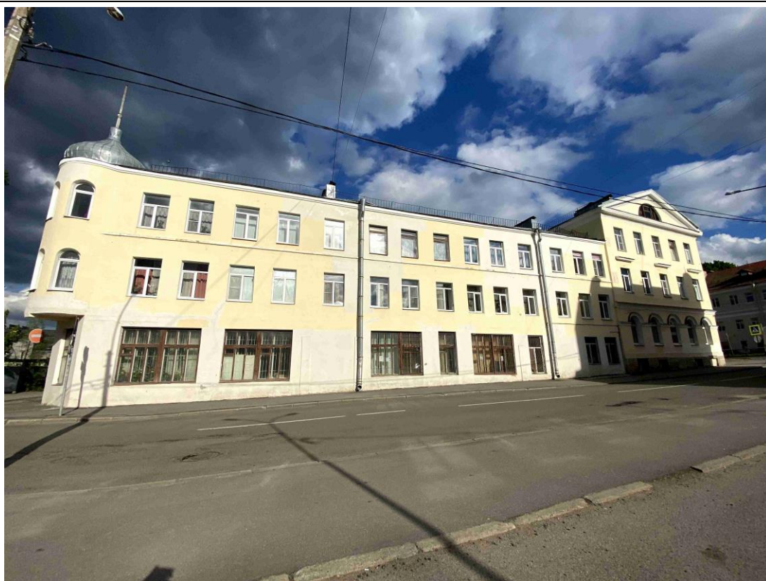
3. Общий вид западного лицевого фасада по Петербургской улице объекта культурного наследия регионального значения «Жилой дом», по адресу: г. Ломоносов, Дворцовый пр., д. 55/8, литера А.
