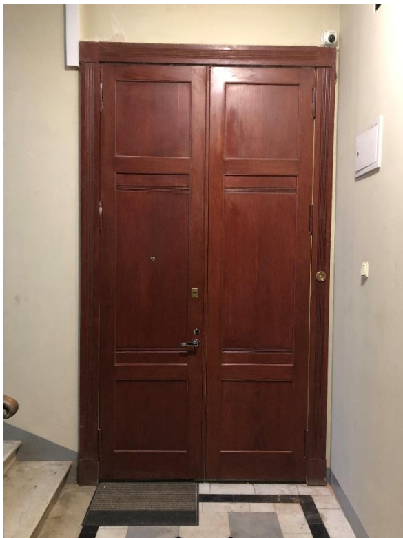
Фото 1. Входная дверь со стороны парадной лестницы.
