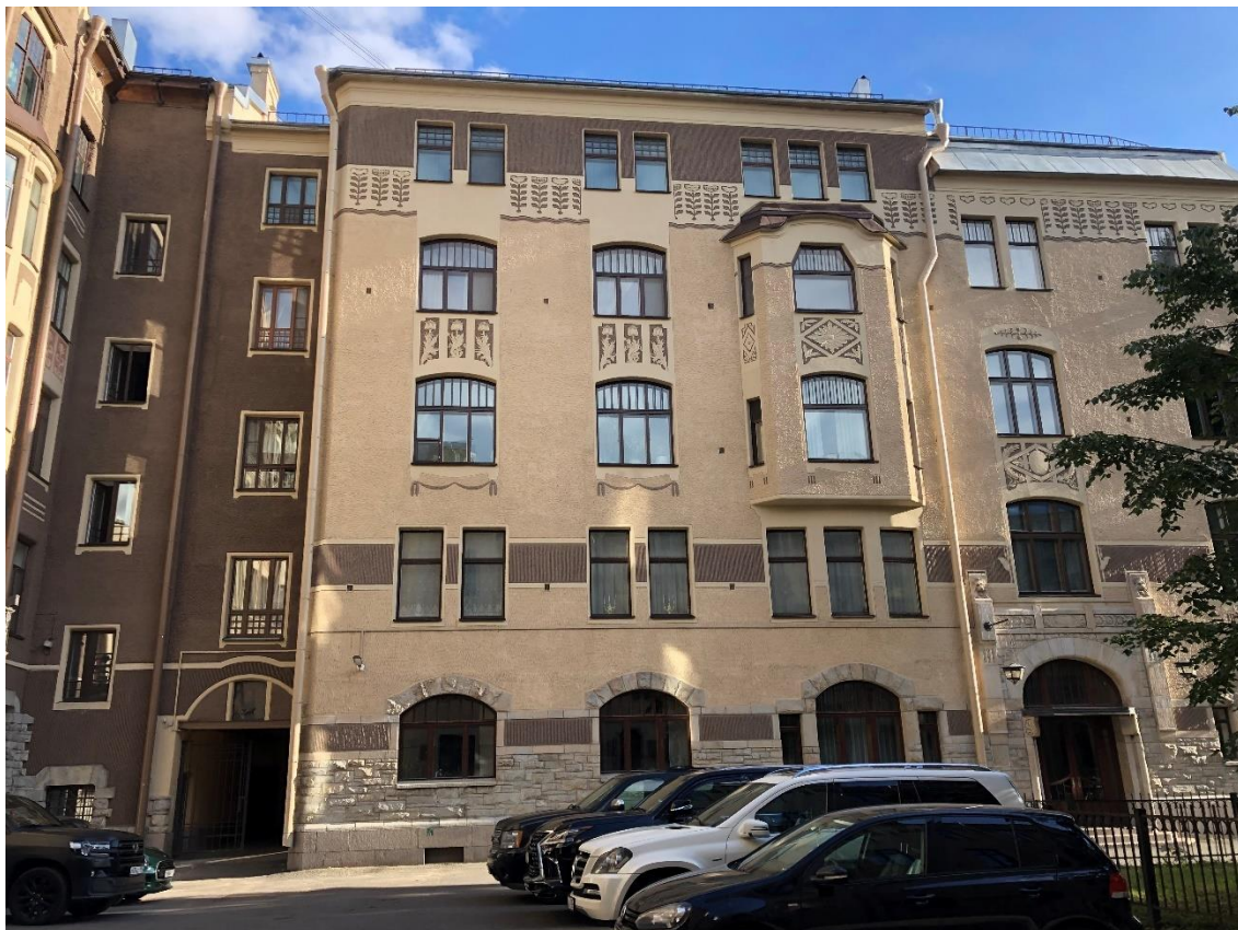
Фото 5. Вид на боковой фасад юго-восточного корпуса.
