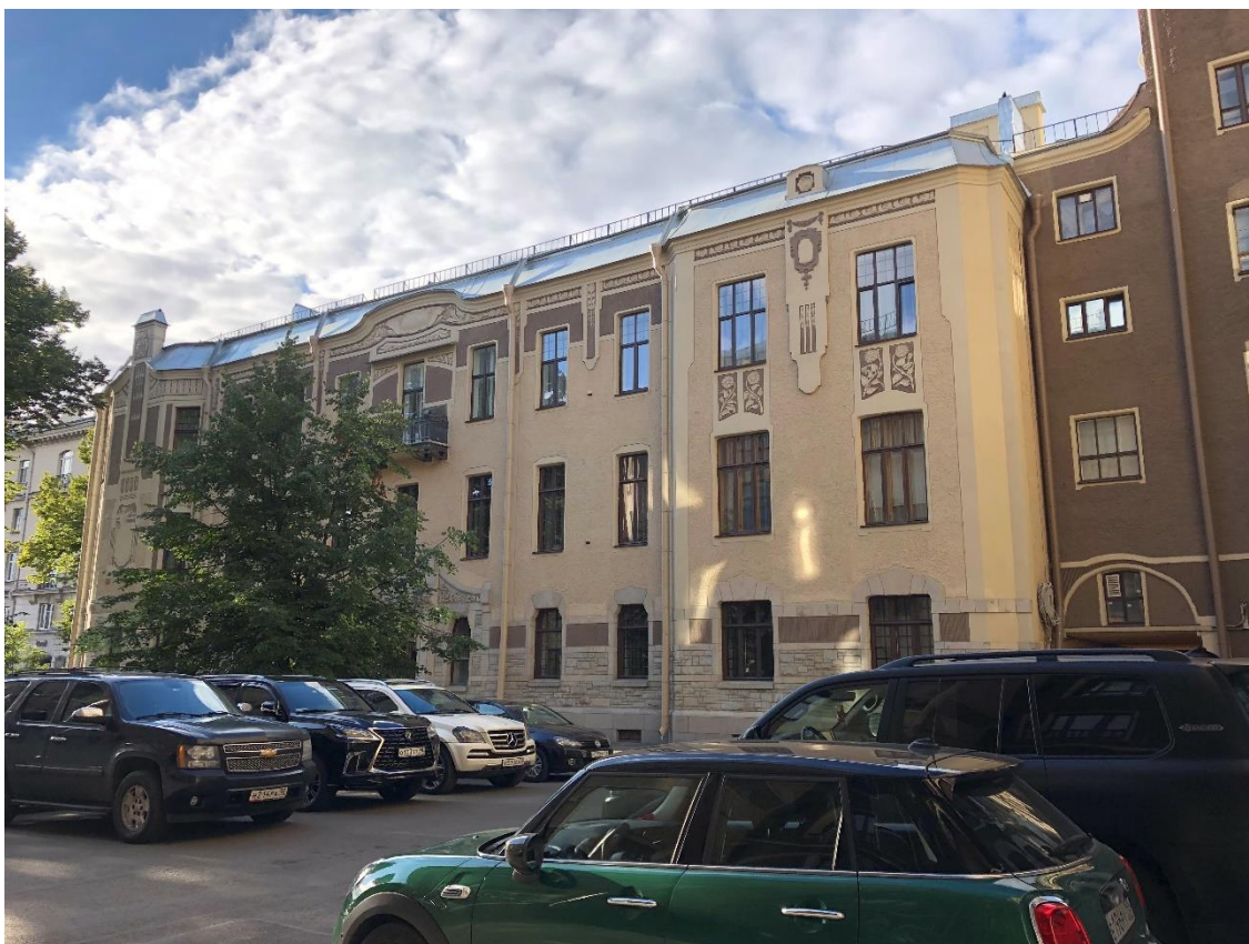
Фото 3. Вид на боковой фасад северо-западного корпуса.
