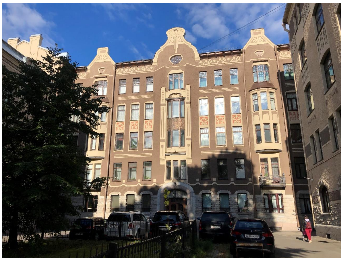
Фото 4. Вид на лицевой фасад центрального корпуса.
