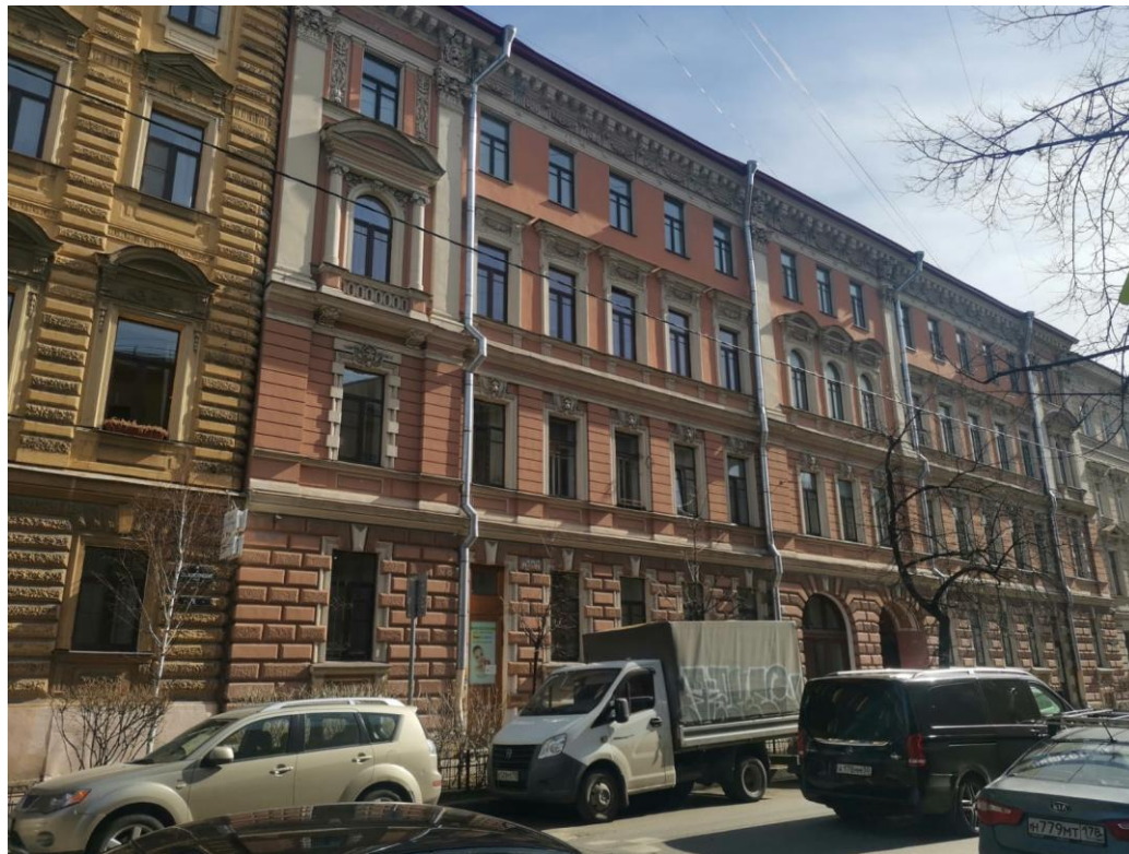
Фото № 1. Общий вид лицевого фасада здания
