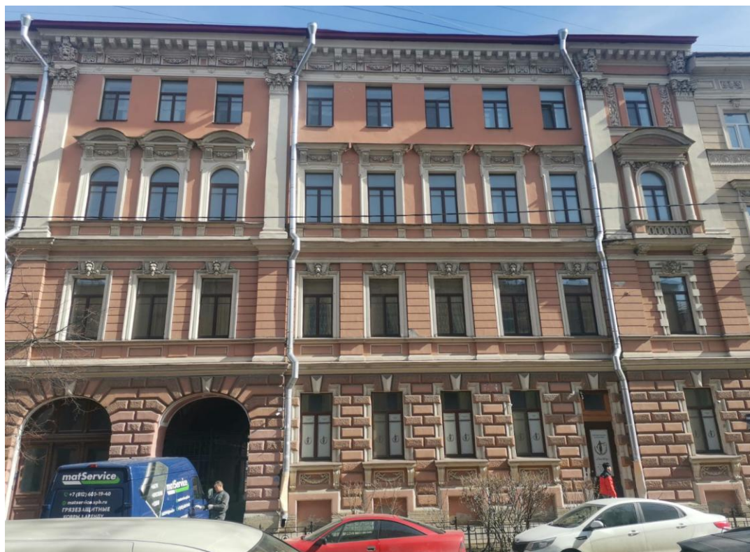
Фото № 2. Фрагмент фасада здания
