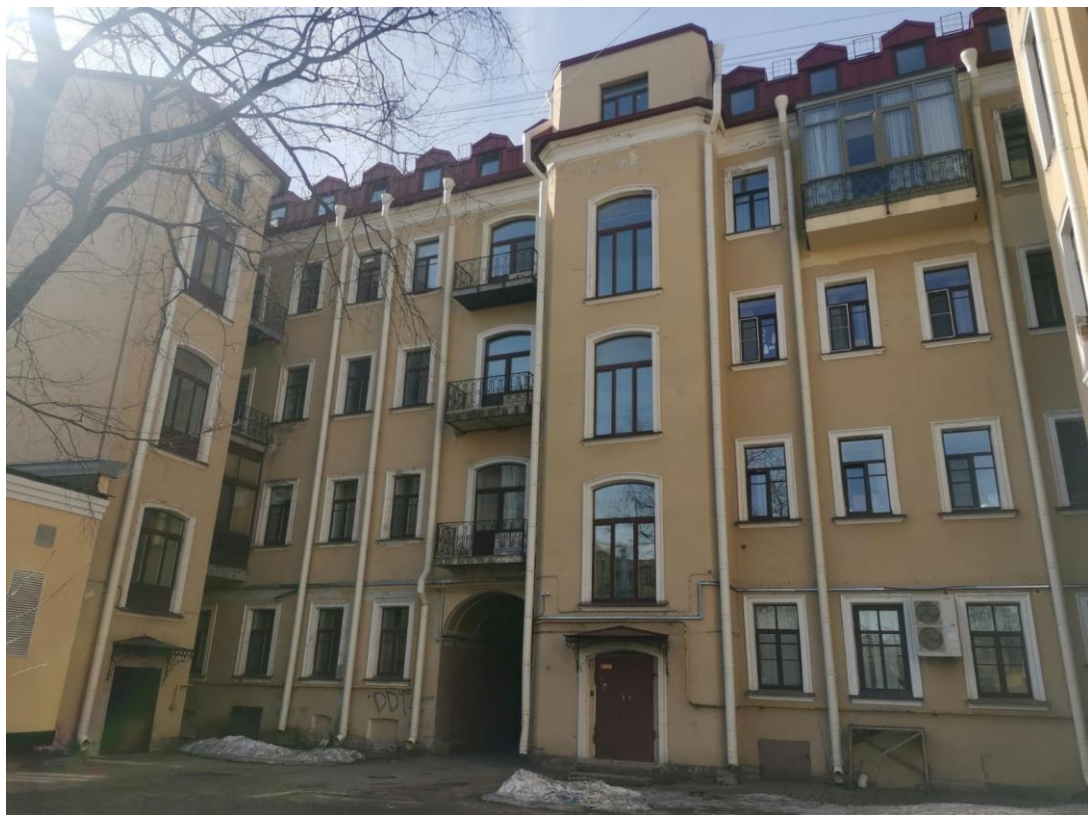
Фото № 3. Общий вид дворового фасада здания
