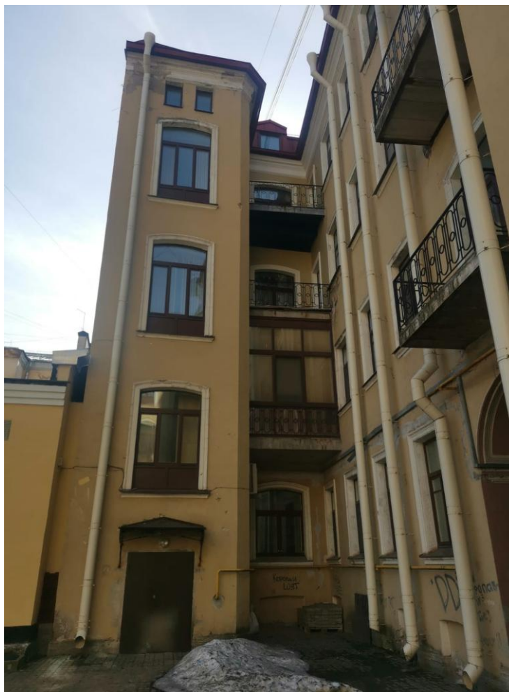
Фото № 4. Фрагмент дворового фасада здания
