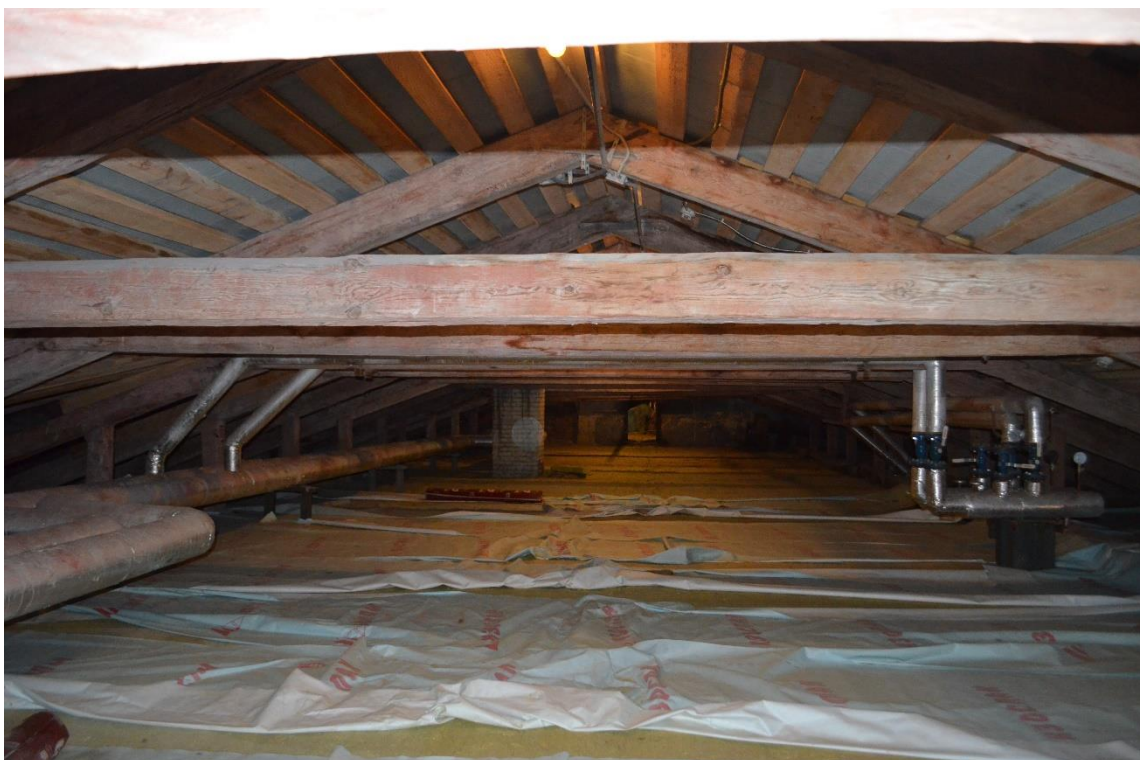
Фото 12. ОКН федерального значения «Монетный двор». Корпус № 5. Чердак. Стропильная система. Общий вид. Съёмка 24.11.2022 г.
