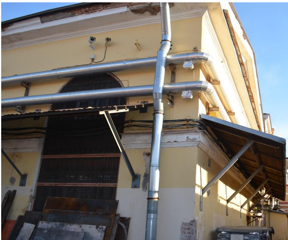
Фото 6. ОКН федерального значения «Монетный двор». Корпус № 5. Фасады. Фрагмент. Съёмка 24.11.2022 г.
