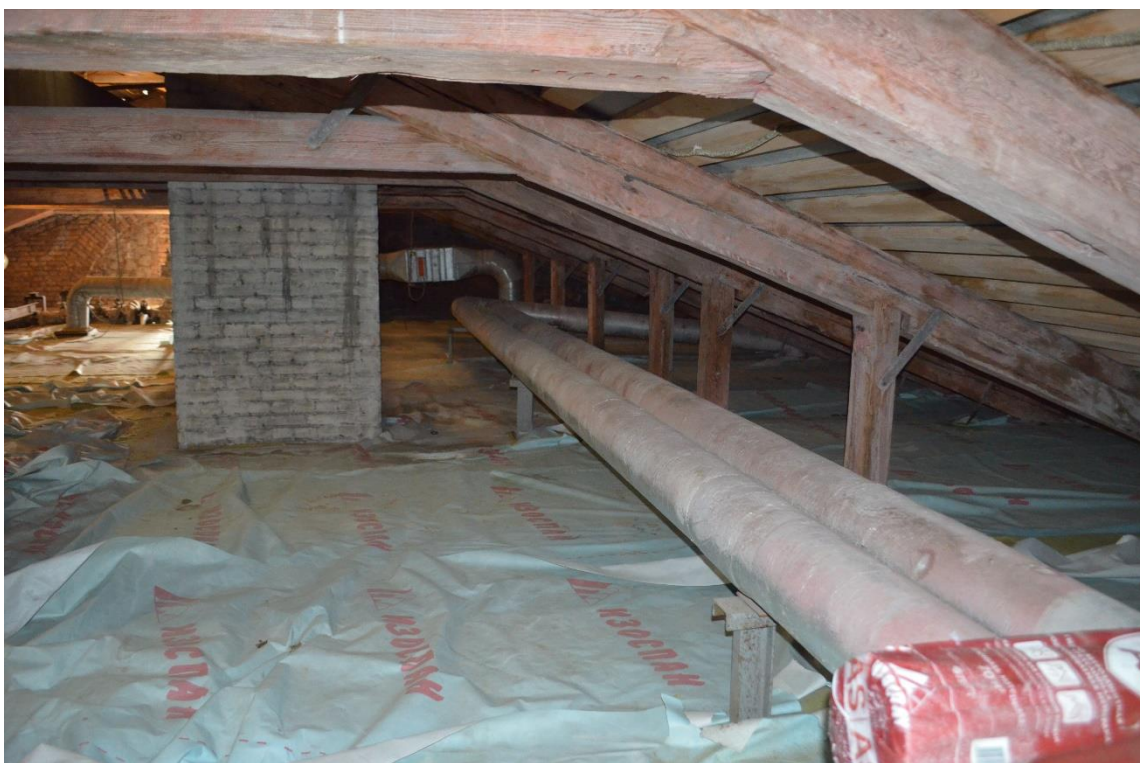
Фото 13. ОКН федерального значения «Монетный двор». Корпус № 5. Чердак. Стропильная система. Фрагмент. Съёмка 24.11.2022 г.
