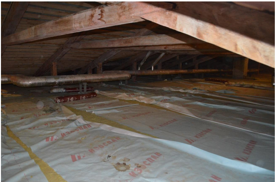
Фото 11. ОКН федерального значения «Монетный двор». Корпус № 5. Чердак. Стропильная система. Общий вид. Съёмка 24.11.2022 г.
