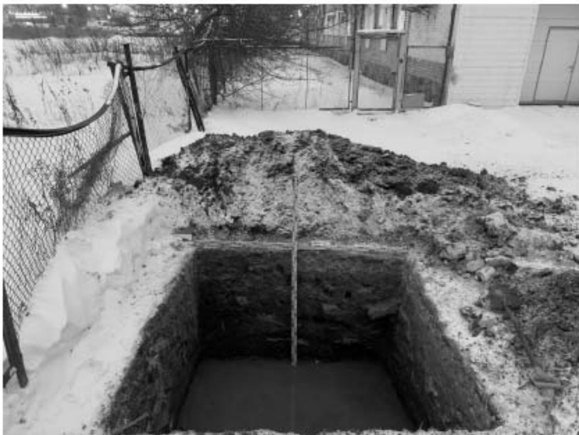
Илл. 48. Санкт-Петербург, Красногвардейский район, Салтыковская дорога, д. 15, лит. А. Шурф 1. Общий вид восточной стенки с запада. 27.11.2022 г.
