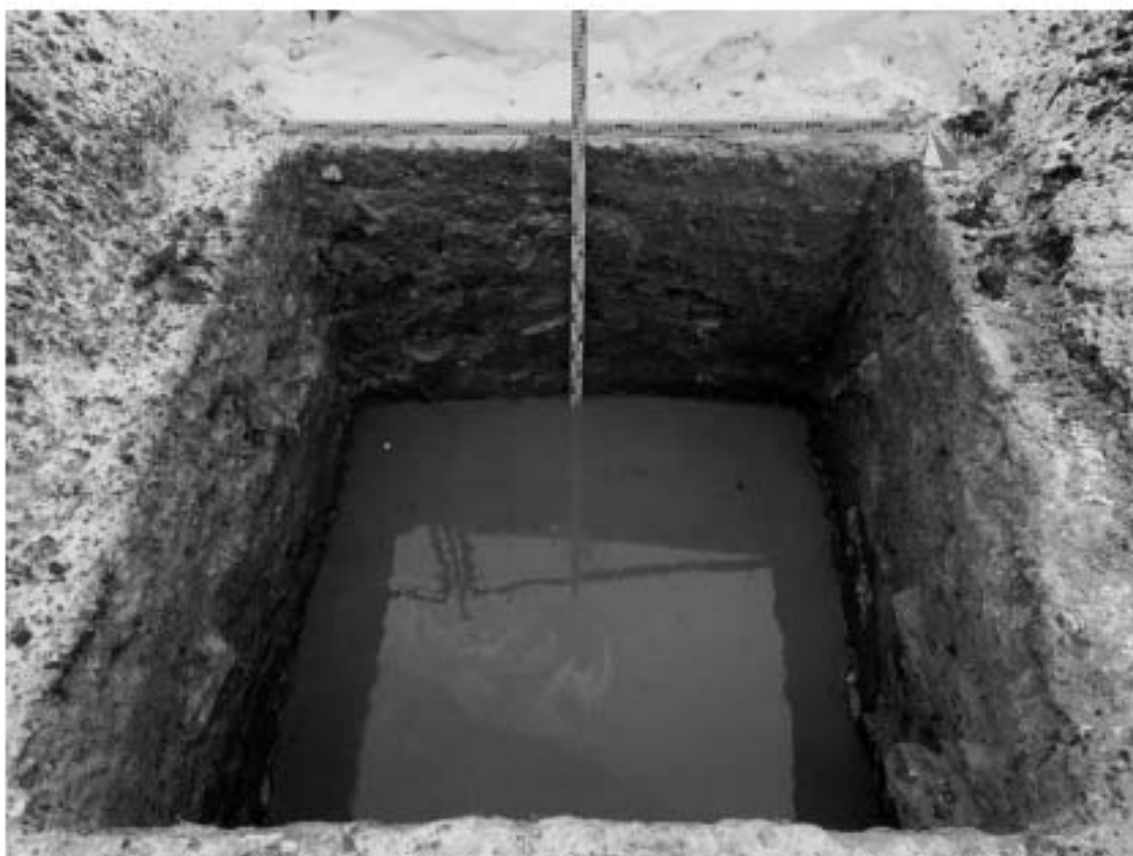
Илл. 45. Санкт-Петербург, Красногвардейский район, Салтыковская дорога, д. 15, лит. А. Общий вид Шурфа 1. Финальная зачистка. Вид с юга. 27.11.2022 г.
