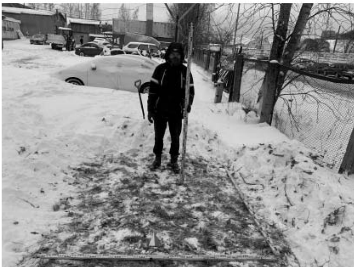
Илл. 55. Санкт-Петербург, Красногвардейский район, Салтыковская дорога, д. 15, лит. А. Месторасположение Шурфа 2. До начала работ. Вид с юга. 27.11.2022 г.
