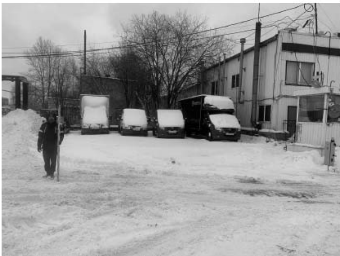
Илл. 19. Санкт-Петербург, Красногвардейский район, Салтыковская дорога, д. 15, лит. А. Общий вид участка обследования. Точка съемки 2. Вид с севера. 27.11.2022 г.
