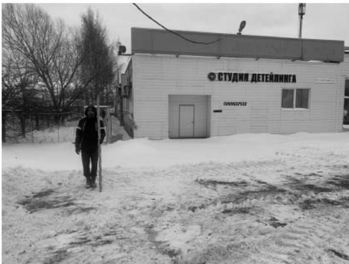
Илл. 17. Санкт-Петербург, Красногвардейский район, Салтыковская дорога, д. 15, лит. А. Общий вид участка обследования. Точка съемки 1. Вид с запада. 27.11.2022 г.
