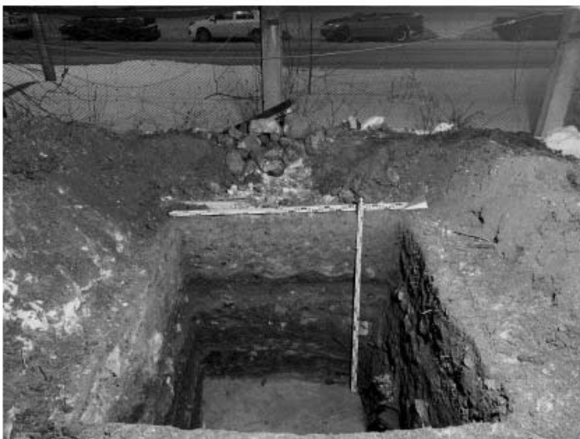
Илл. 60. Санкт-Петербург, Красногвардейский район, Салтыковская дорога, д. 15, лит. А. Шурф 2. Общий вид восточной стенки с запада. 27.11.2022 г.
