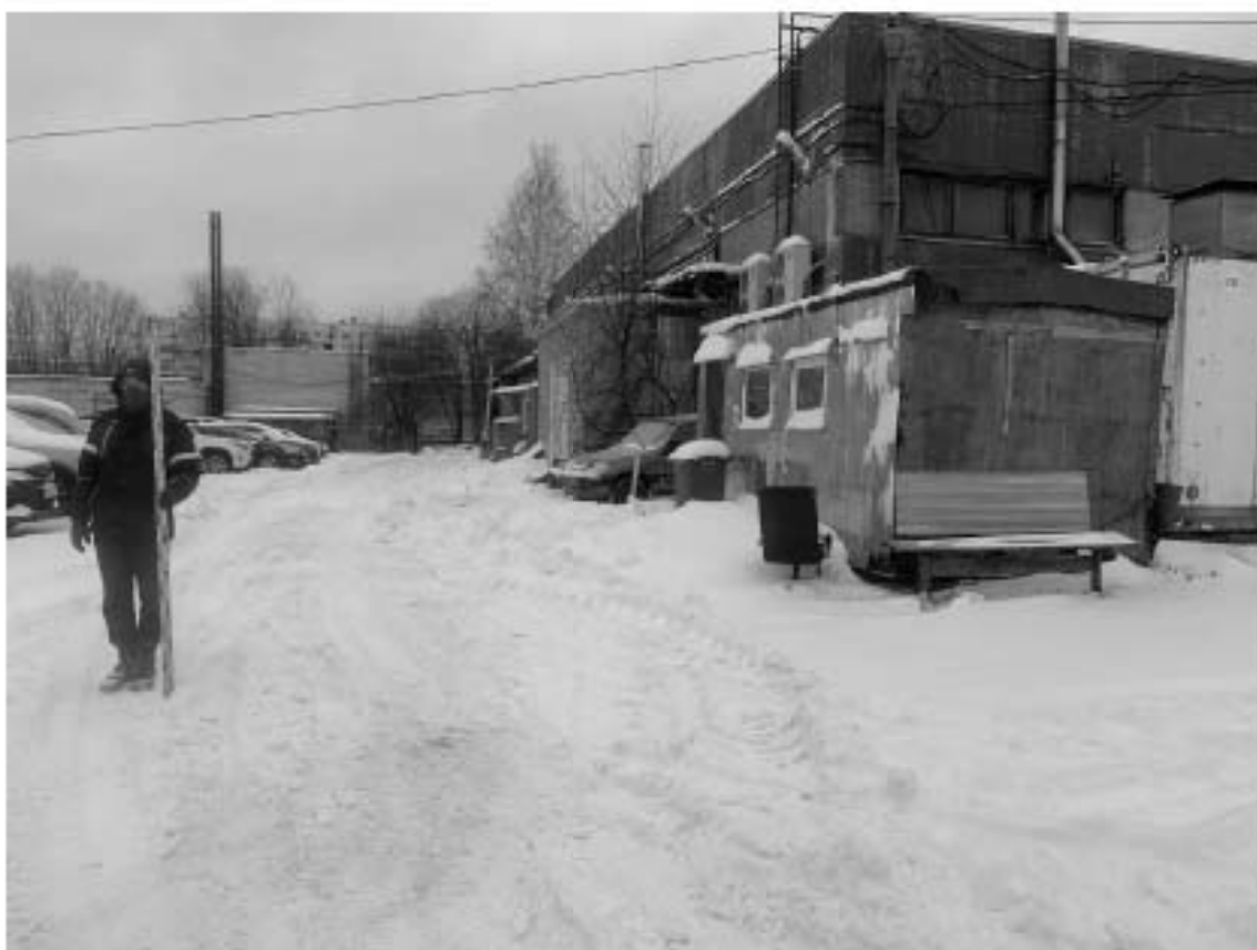
Илл. 42. Санкт-Петербург, Красногвардейский район, Салтыковская дорога, д. 15, лит. А. Общий вид участка обследования. Точка съемки 7. Вид с востока. 27.11.2022 г.
