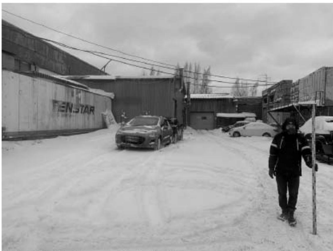
Илл. 41. Санкт-Петербург, Красногвардейский район, Салтыковская дорога, д. 15, лит. А. Общий вид участка обследования. Точка съемки 7. Вид с юга. 27.11.2022 г.
