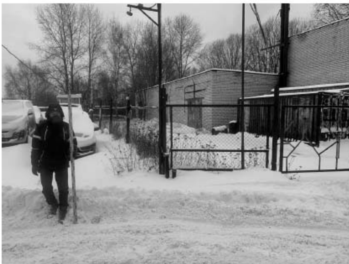
Илл. 24. Санкт-Петербург, Красногвардейский район, Салтыковская дорога, д. 15, лит. А. Общий вид участка обследования. Точка съемки 3. Вид с севера. 27.11.2022 г.
