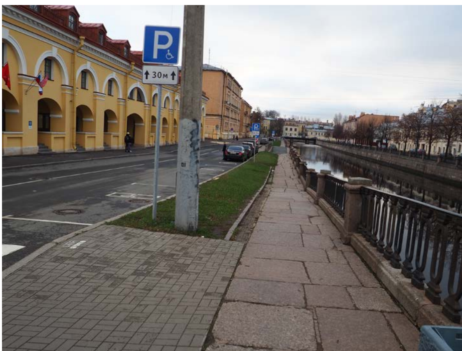
34. Крюков канал. Набережная восточного берега между Старо-Никольским и Смежным мостами. Вид с северо-запада.
