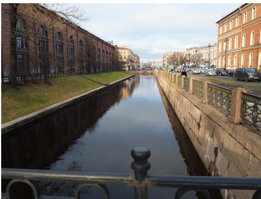
6. Крюков канал. Вид с северного временного моста на русло Крюкова канала, на север.
