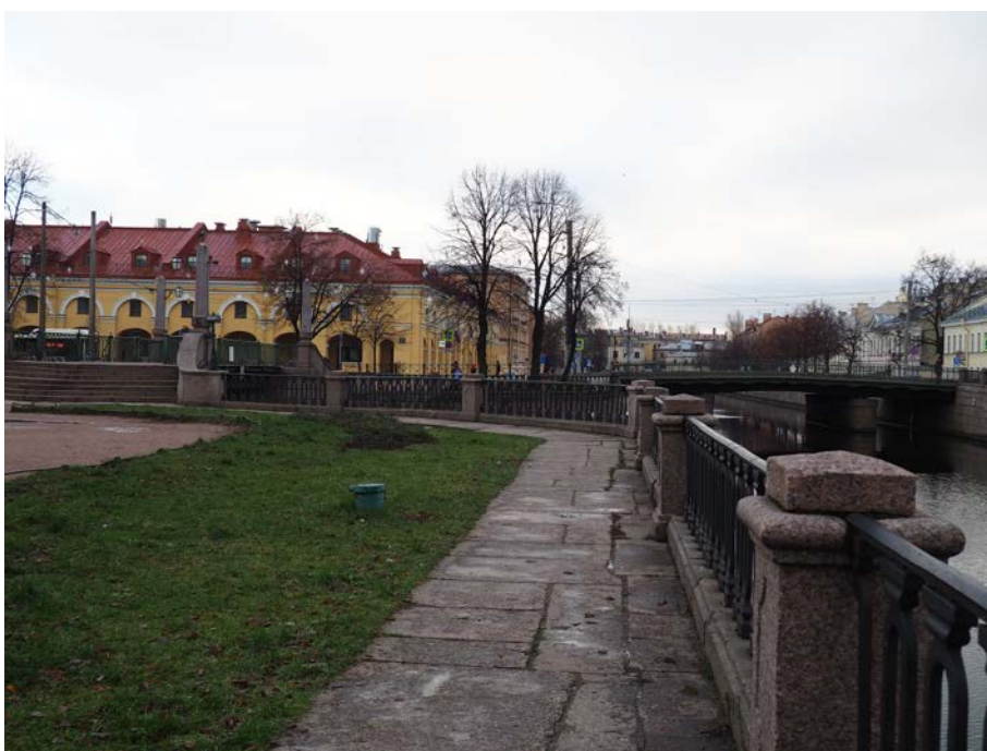
30. Крюков канал. Вид с севера на Старо-Никольский мост (справа), Красногвардейский мост и Никольский рынок.
