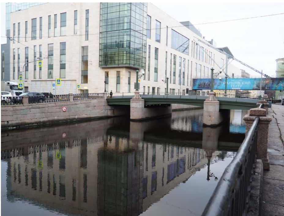
21. Крюков канал. Вид на Торговый мост с юго-востока.
