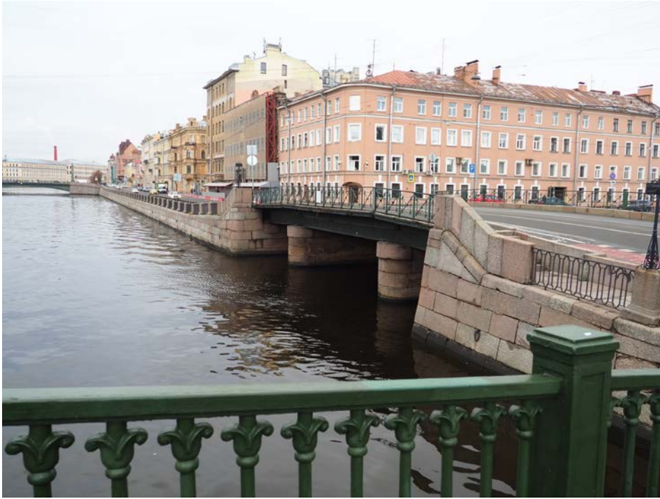
39. Устье Крюкова канала и Смежный мост. Вид с Красноармейского моста (с востока-юго-востока).
