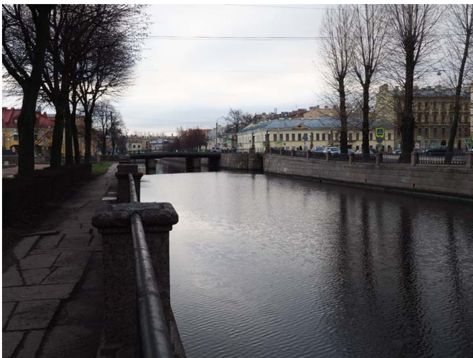
29. Крюков канал. Вид на Старо-Никольский (прямо) и Пикалов мосты с севера.
