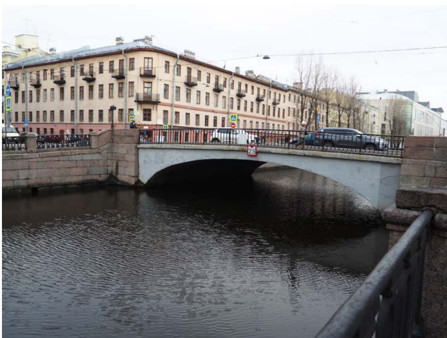
26. Крюков канал. Кашин мост. Вид с юго-востока.
