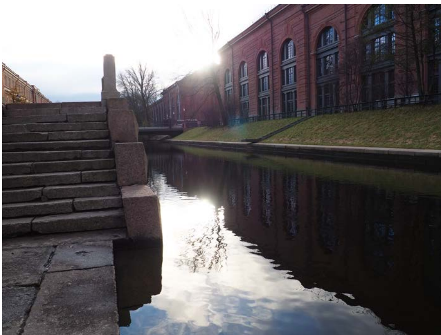
5. Крюков канал. Вид со спуска на восточном берегу (с севера) на откосную с банкетом набережную Новой Голландии и северный временный мост.
