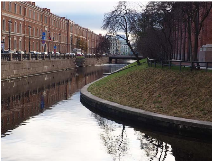
4. Крюков канал. Вид с набережной Адмиралтейского канала (с северо-запада) на подпорную стенку восточного берега Крюкова канала, откосную набережную с банкетом Новой Голландии и северный временный мост.
