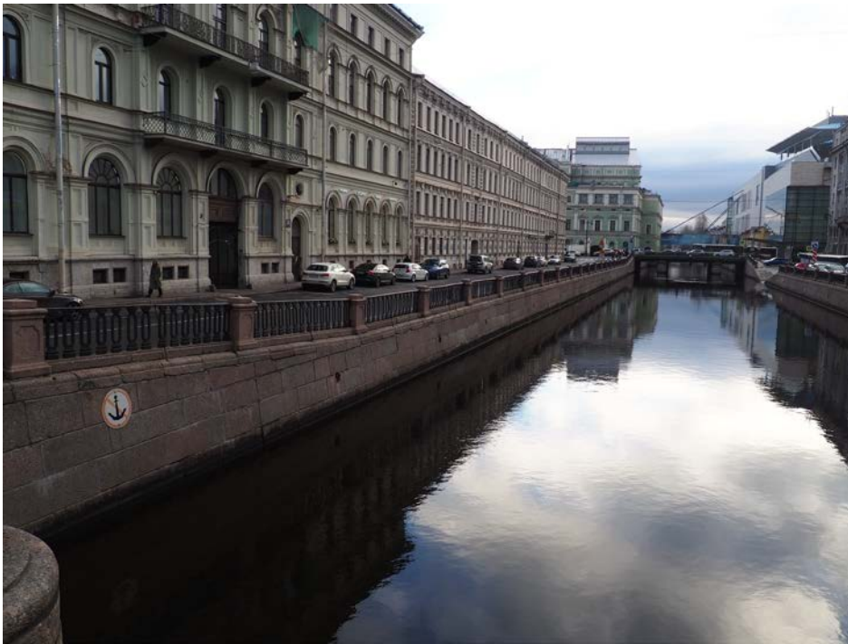
13. Крюков канал. Вид с Матвеева моста на юг, на мост Декабристов и восточный берег Крюкова канала.
