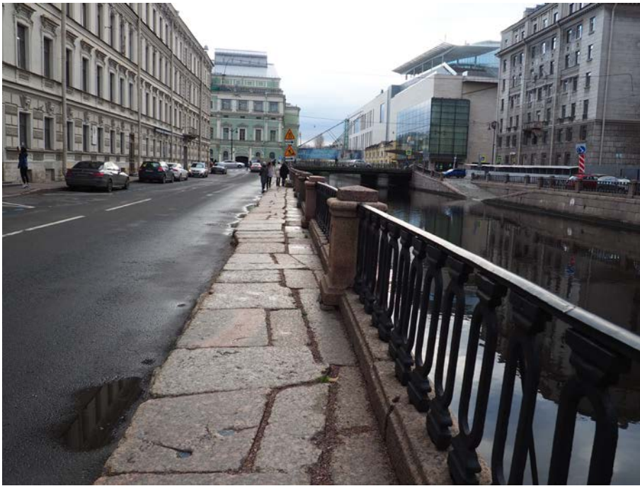
15. Крюков канал. Набережная восточного берега на участке от моста Декабристов до Торгового моста. Вид с севера.
