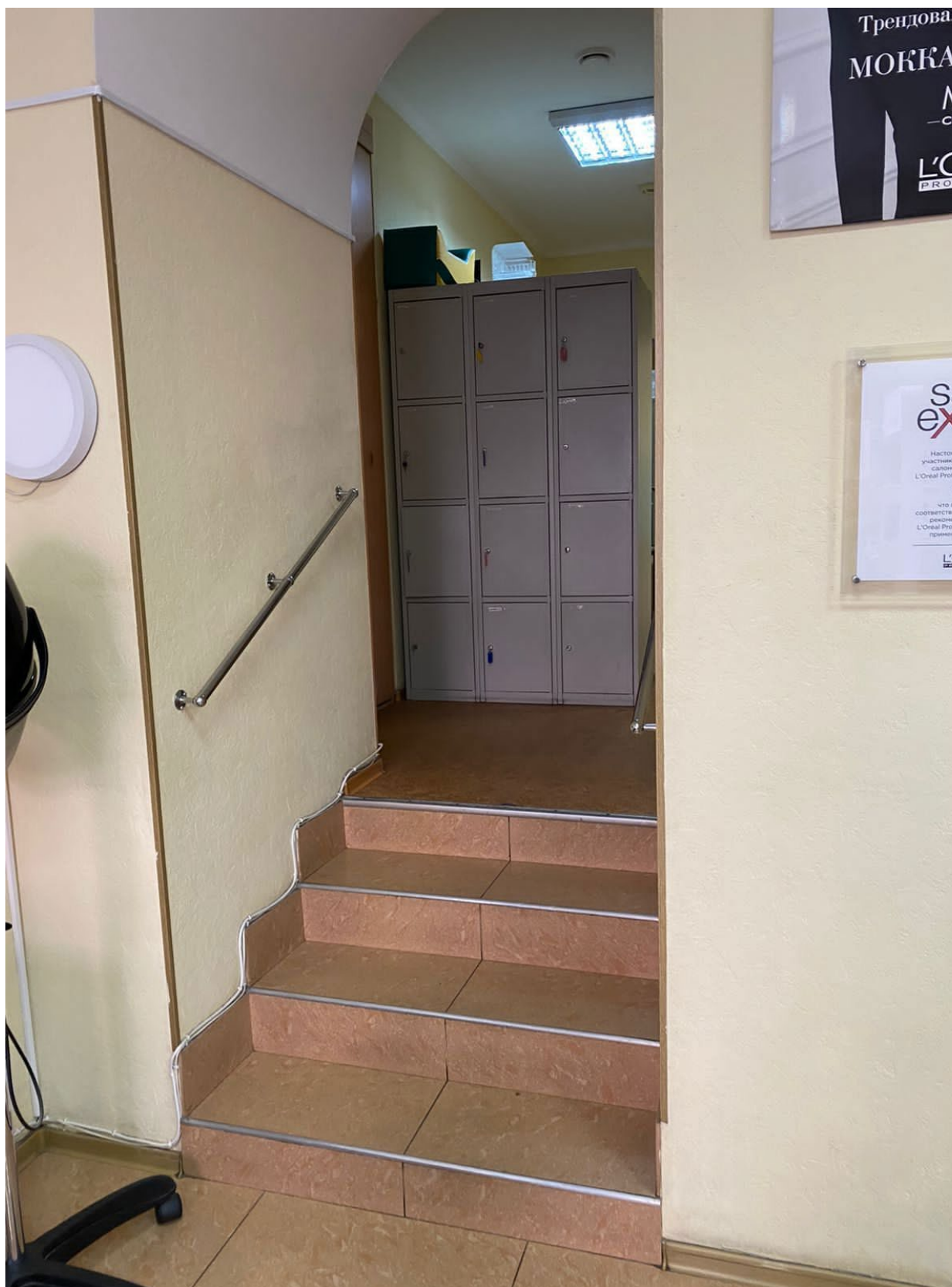
5. Вид на лестницу (между пом. 1/41.7 и пом.2/9.4);
