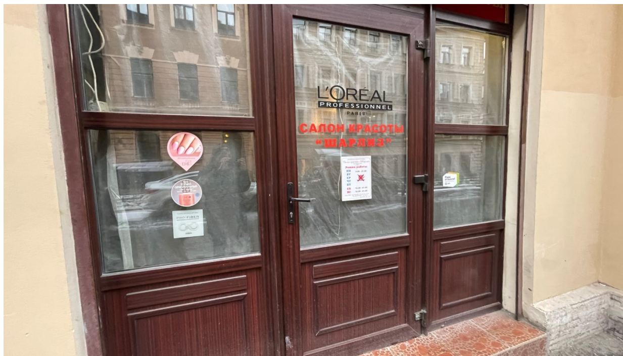
1. Вид на входную дверь в помещение 19-Н;
