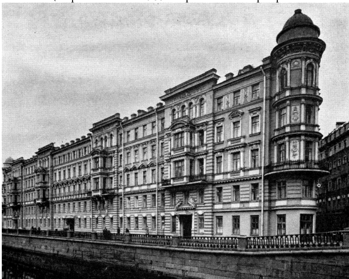
43. Жилой дом на набережной канала Грибоедова, 71. 1985 г. // pastvu URL: https://pastvu.com/
