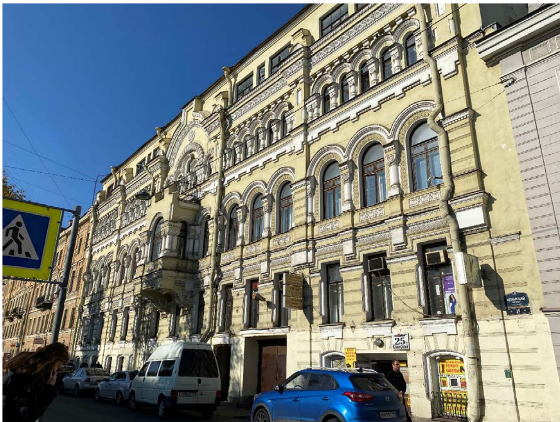
2. Лицевой фасад объекта культурного наследия регионального значения «Здание заводоуправления Товарищества табачной фабрики «А.Н.Шапошников и Ко»», расположенного по адресу: г. Санкт-Петербург, Клинский пр., д. 25, литера А. 26.08.2021
