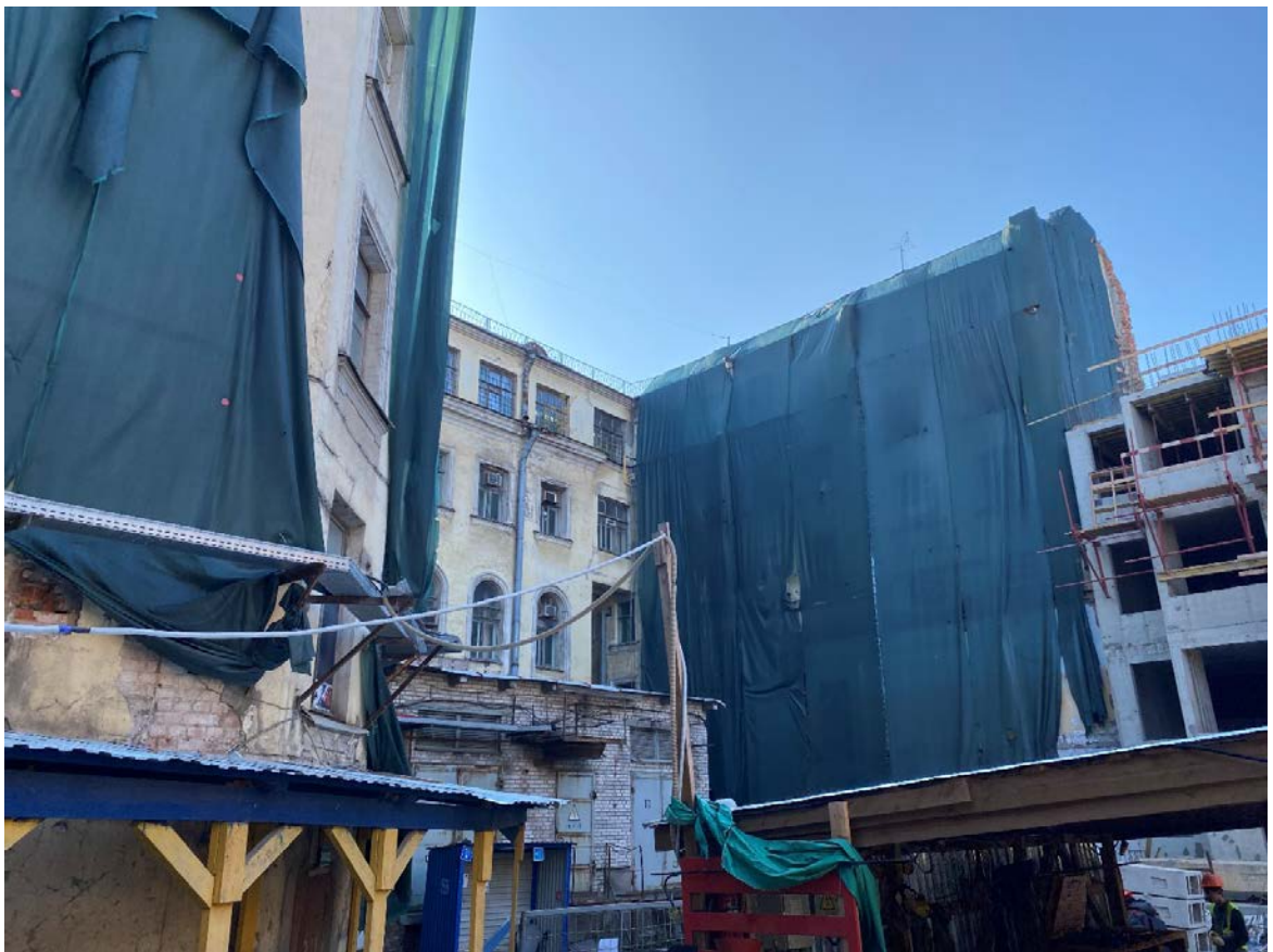
6. Флигели дома 25 по Клинскому проспекту. Зона производства работ. 26.08.2021
