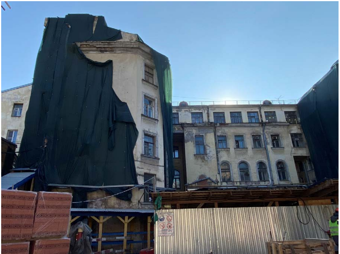
7. Правый флигель дома 25 по Клинскому проспекту. Зона производства работ. 26.08.2021
