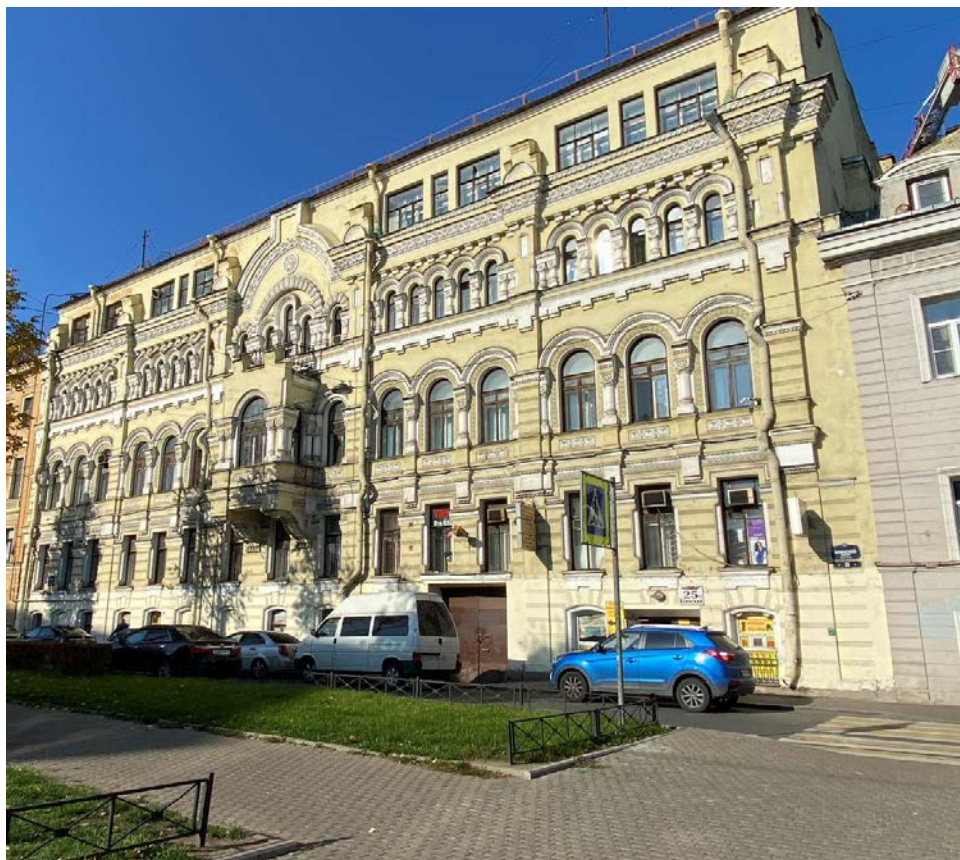
1. Лицевой фасад объекта культурного наследия регионального значения «Здание заводоуправления Товарищества табачной фабрики «А.Н.Шапошников и Ко»», расположенного по адресу: г. Санкт-Петербург, Клинский пр., д. 25, литера А. 26.08.2021
