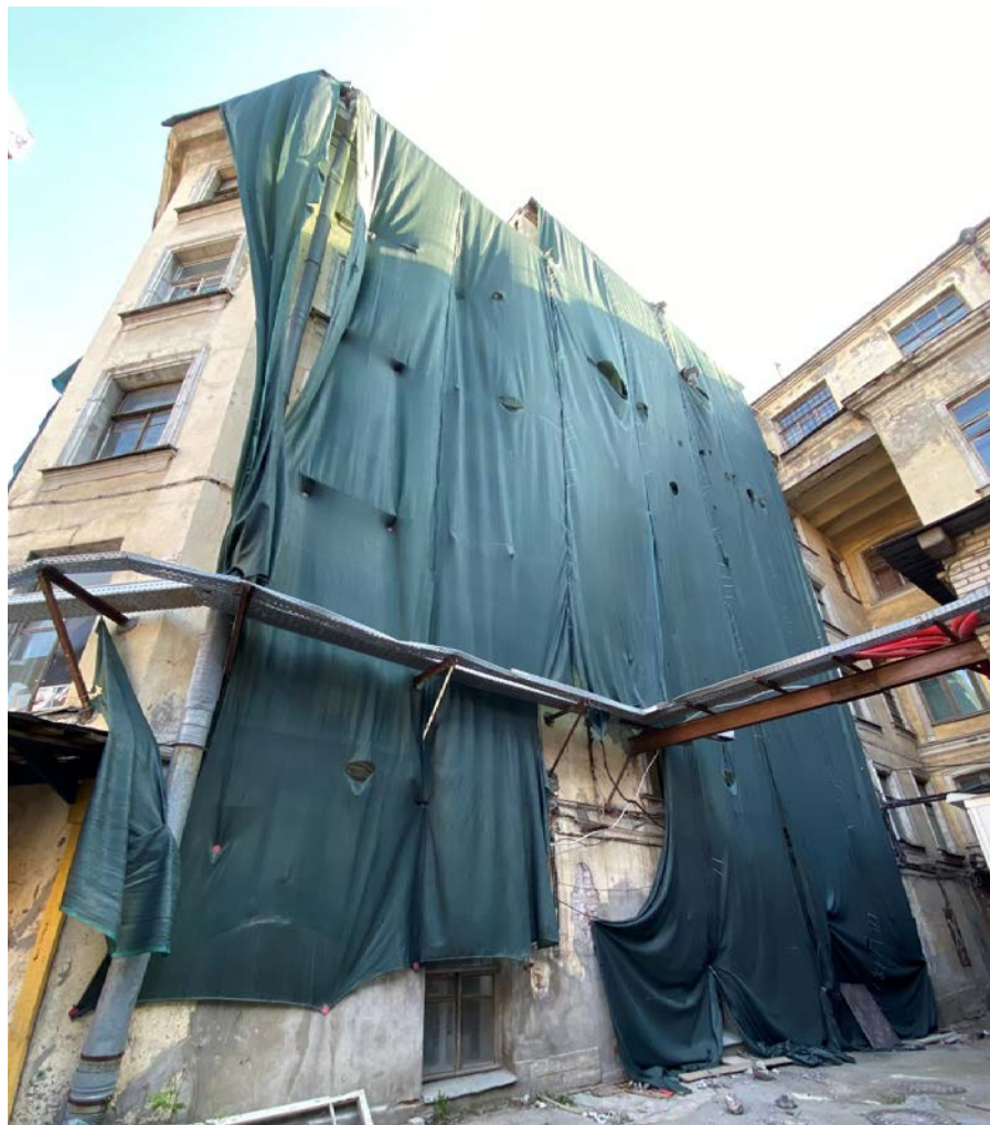
4. Западный фасад правого флигеля дома 25 по Клиньскому проспекту. Зона производства работ. 26.08.2021
