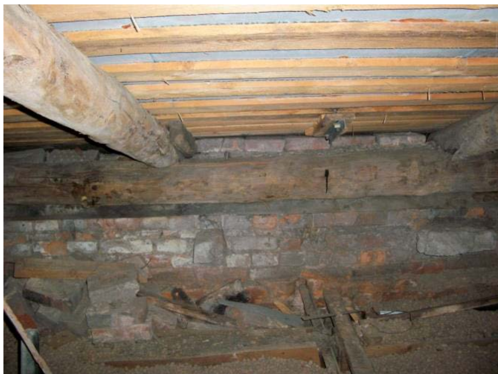
16. Объект культурного наследия регионального значения «Городской дом начальных училищ им. М.Г. Петрова», по адресу: Санкт-Петербург, Малоохтинский проспект, дом 51, литера А. Чердачное помещение. Дата съемки: 19.09.2022г.
