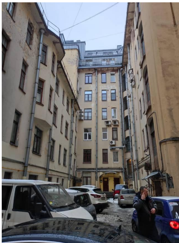
Фото 5. Фрагмент дворового фасада объекта культурного наследия регионального значения «Доходный дом Обольяниновых»
