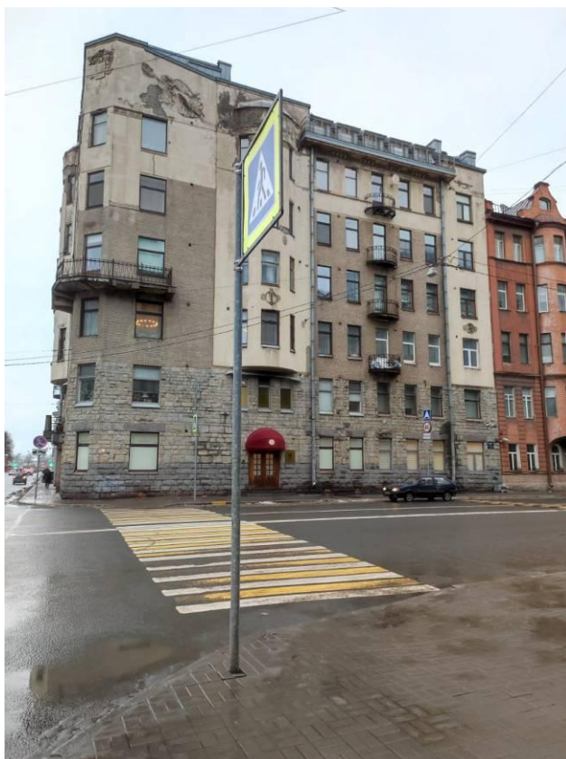
Фото 3. Лицевой фасад объекта культурного наследия регионального значения «Доходный дом Оболяниновых» по Тверской ул.
