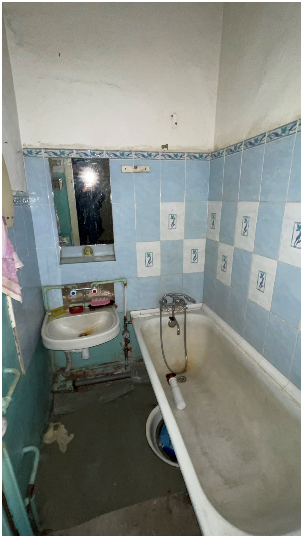
20.Фрагмент интерьера ванной (помещение 8/2.3)
