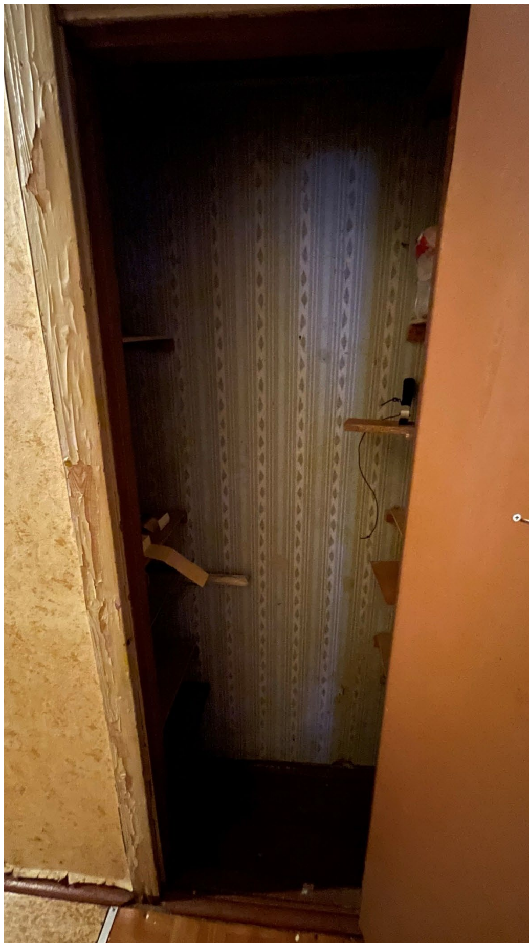
9. Вид на встроенный шкаф (помещение 2/0.6);
