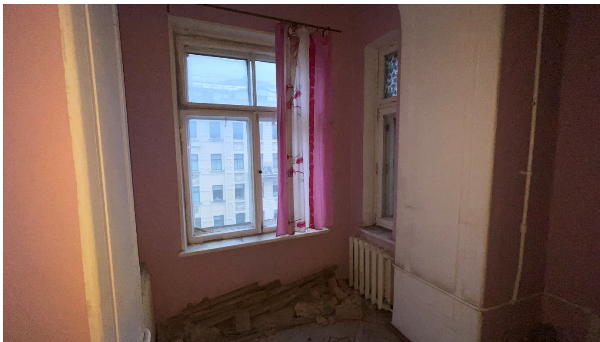
17.Фрагмент интерьера комнаты (помещение 9/28.0);
