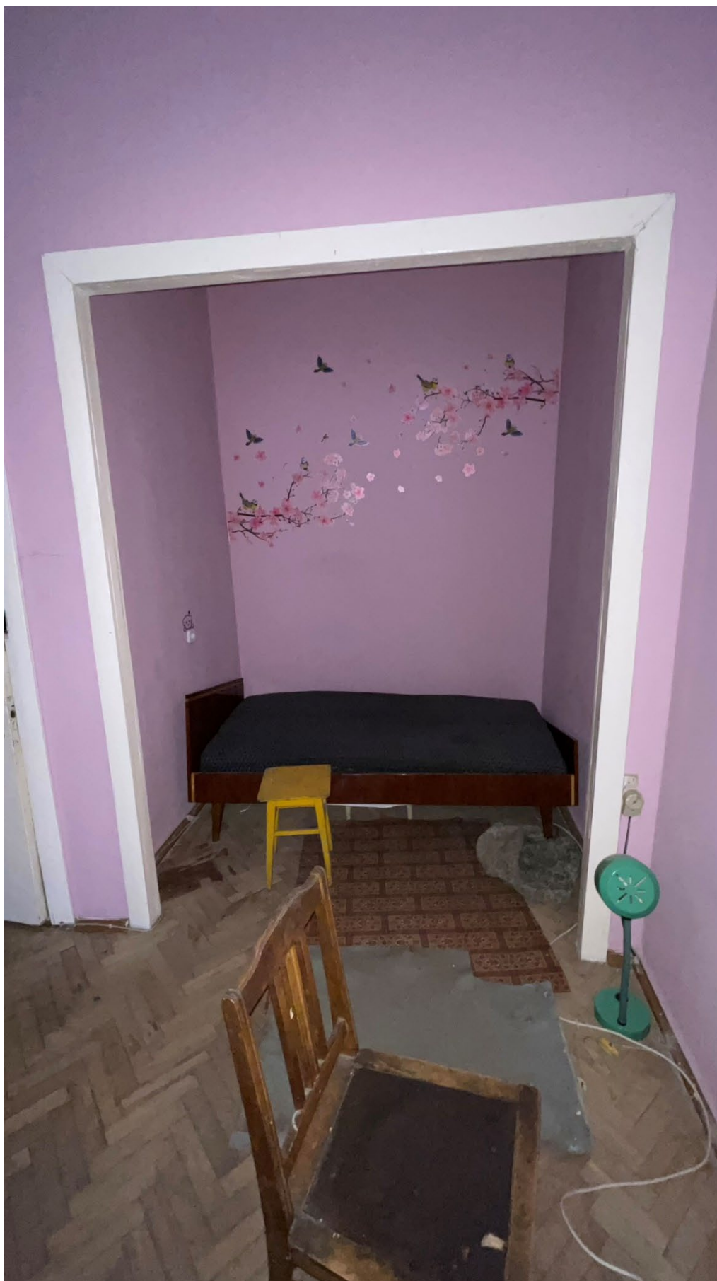
18. Фрагмент интерьера комнаты (помещение 9/28.0);
