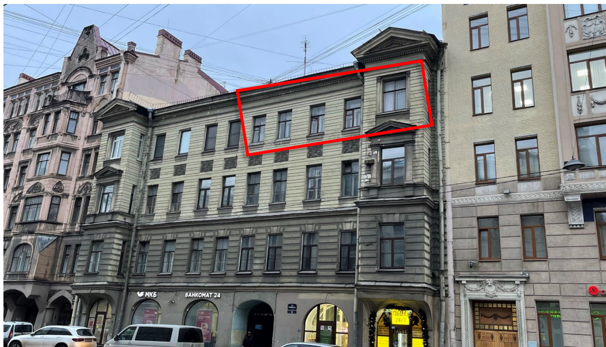
1. Вид на главный фасад здания и окна квартиры №8;
