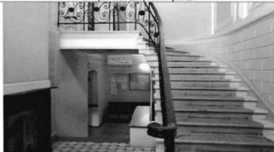
3. Вестибюль парадной лестницы
