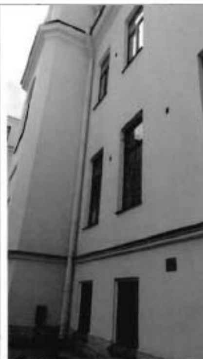
4. Фрагмент дворового фасада
