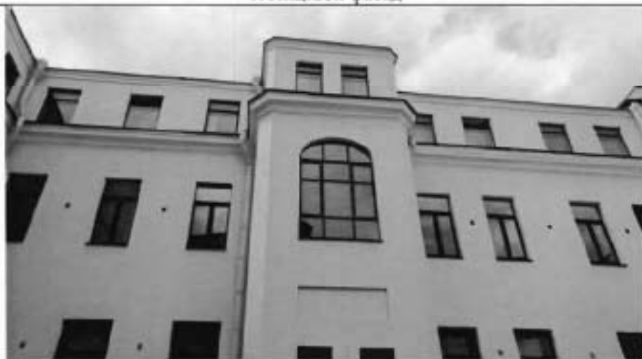
2. Фрагмент дворового фасада
