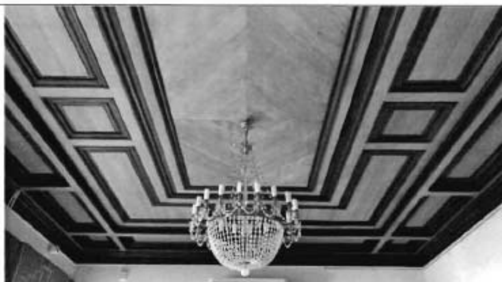
4. Фрагмент оформления интерьера (деревянная подшивка потолка Аванзала)
