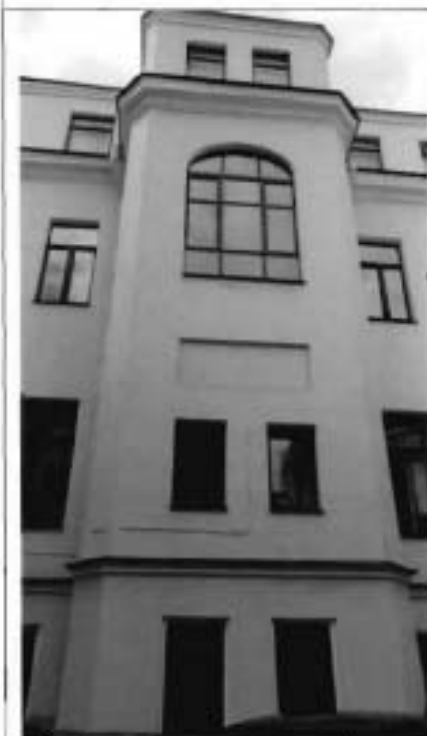
2. Фрагмент дворового фасада
