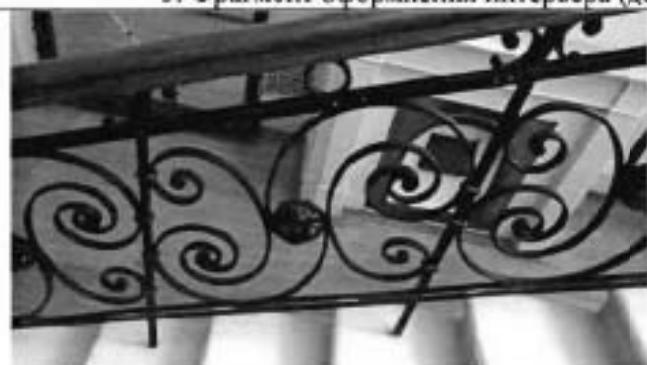
6. Фрагмент ограждения парадной лестницы
