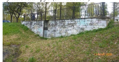
Водосливная плотина на пруду
