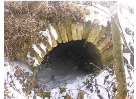
переход кирпичной галереи в канал
