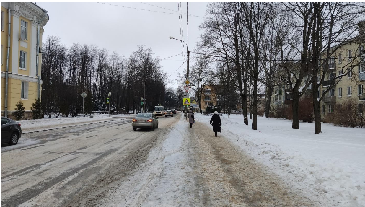
Фото 1. Вид на Берёзовую ул. в сторону объекта проектирования с запада.
