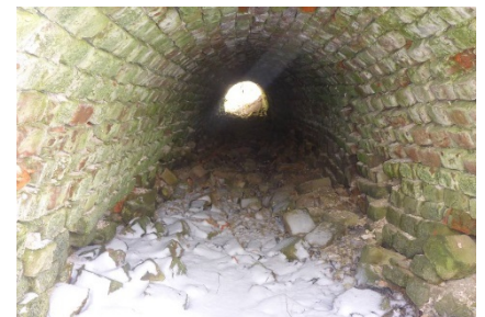
вид кирпичной галереи
