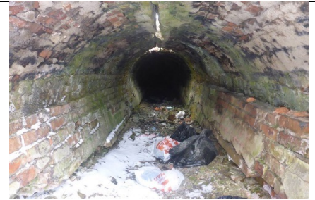
вид кирпичной галереи
