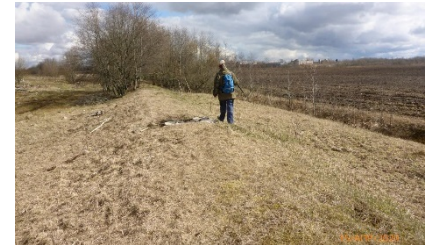
Трасса подземной кирпичной галереи мелкого заложения
