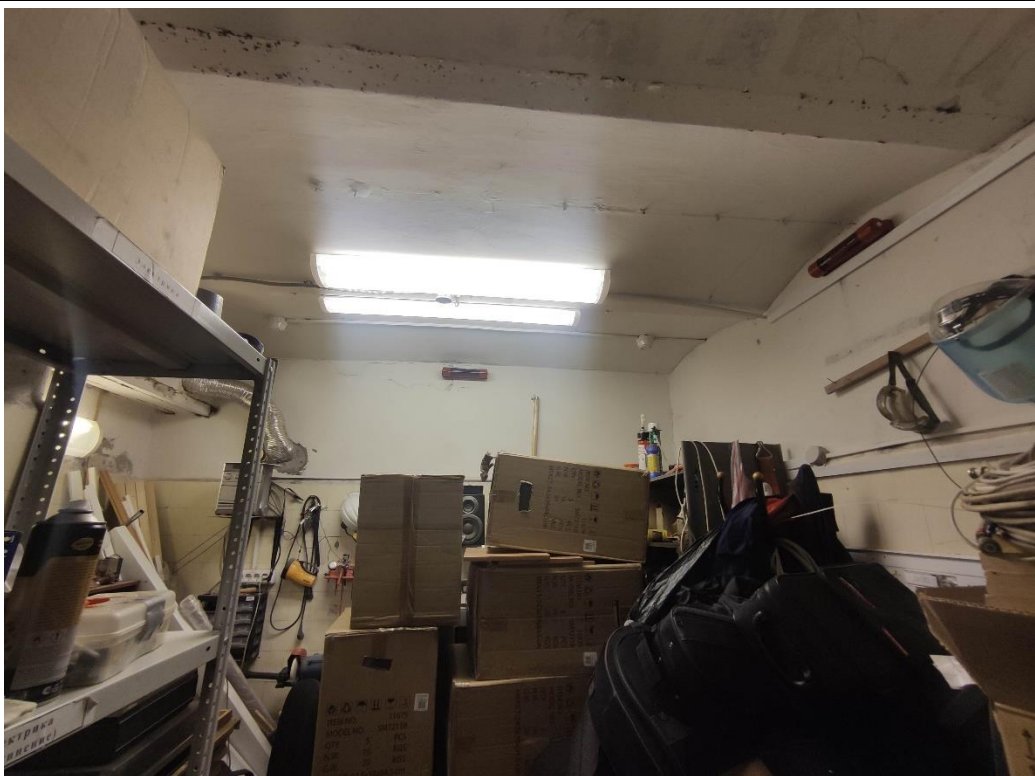
23. Объект культурного наследия регионального значения «Главный дом», расположенный по адресу: г. Санкт-Петербург, набережная Лейтенанта Шмидта, дом 31, литера А, входящий в состав объекта культурного наследия регионального значения «Дом Утеман Ф.Ф.». Фрагмент пом. № 1-Н(13) первого этажа.
