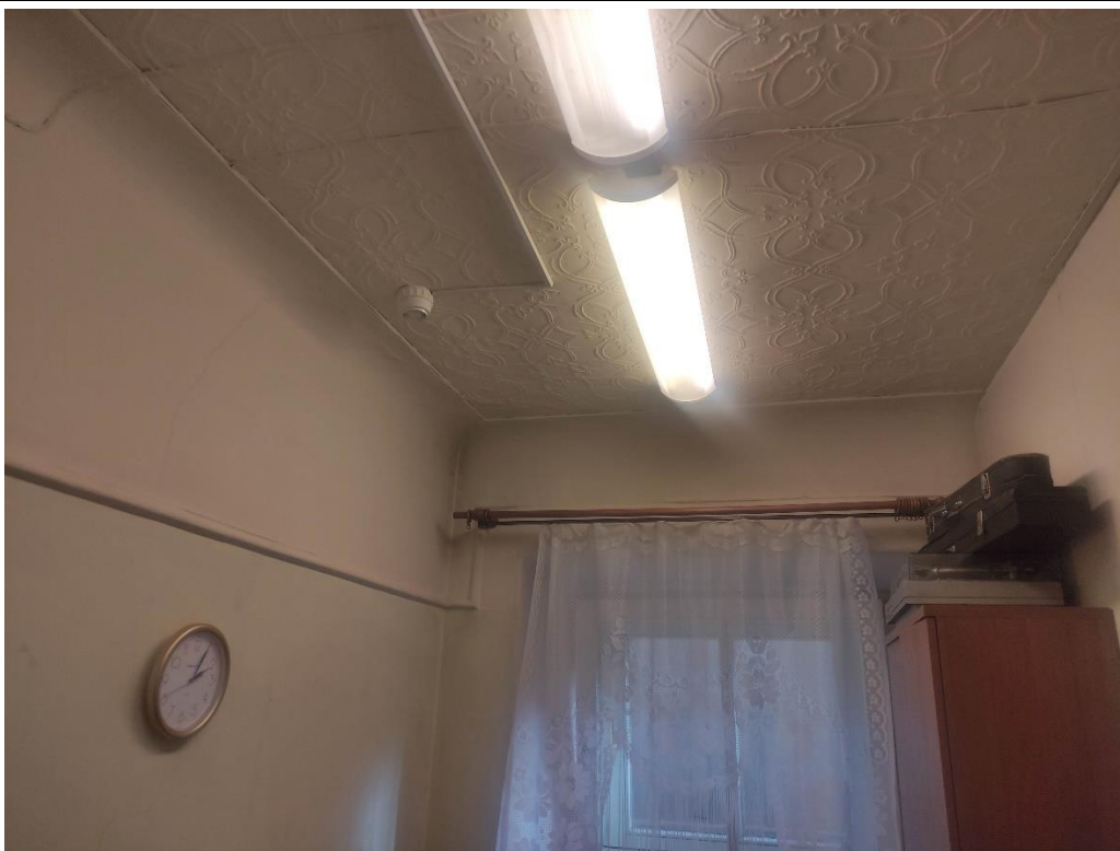
15. Объект культурного наследия регионального значения «Главный дом», расположенный по адресу: г. Санкт-Петербург, набережная Лейтенанта Шмидта, дом 31, литера А, входящий в состав объекта культурного наследия регионального значения «Дом Утеман Ф.Ф.». Фрагмент пом. № 1-Н(6) первого этажа.
