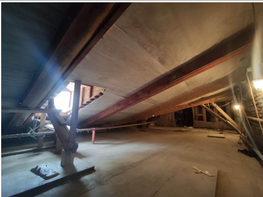
91. Объект культурного наследия регионального значения «Главный дом», расположенный по адресу: г. Санкт-Петербург, набережная Лейтенанта Шмидта, дом 31, литера А, входящий в состав объекта культурного наследия регионального значения «Дом Утеман Ф.Ф.». Фрагмент чердачного этажа.
