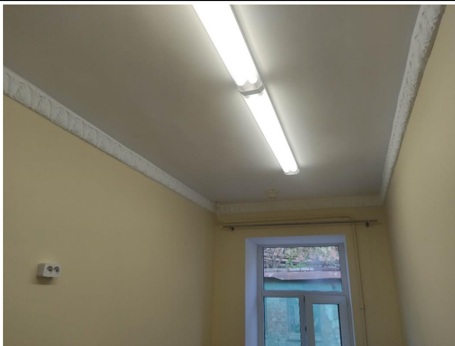
56. Объект культурного наследия регионального значения «Главный дом», расположенный по адресу: г. Санкт-Петербург, набережная Лейтенанта Шмидта, дом 31, литера А, входящий в состав объекта культурного наследия регионального значения «Дом Утеман Ф.Ф.». Фрагмент пом. № 1-Н(44) второго этажа.
