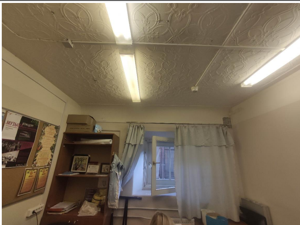
16. Объект культурного наследия регионального значения «Главный дом», расположенный по адресу: г. Санкт-Петербург, набережная Лейтенанта Шмидта, дом 31, литера А, входящий в состав объекта культурного наследия регионального значения «Дом Утеман Ф.Ф.». Фрагмент пом. № 1-Н(6) первого этажа.
