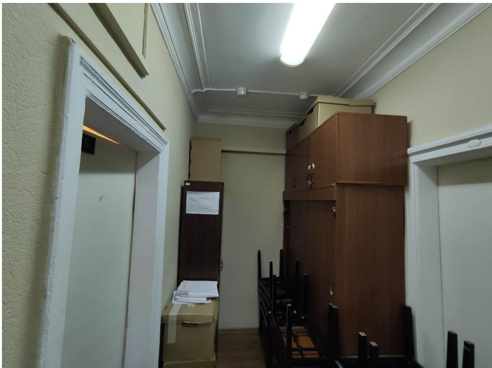
34. Объект культурного наследия регионального значения «Главный дом», расположенный по адресу: г. Санкт-Петербург, набережная Лейтенанта Шмидта, дом 31, литера А, входящий в состав объекта культурного наследия регионального значения «Дом Утеман Ф.Ф.». Фрагмент пом. № 1-Н(55) второго этажа.
