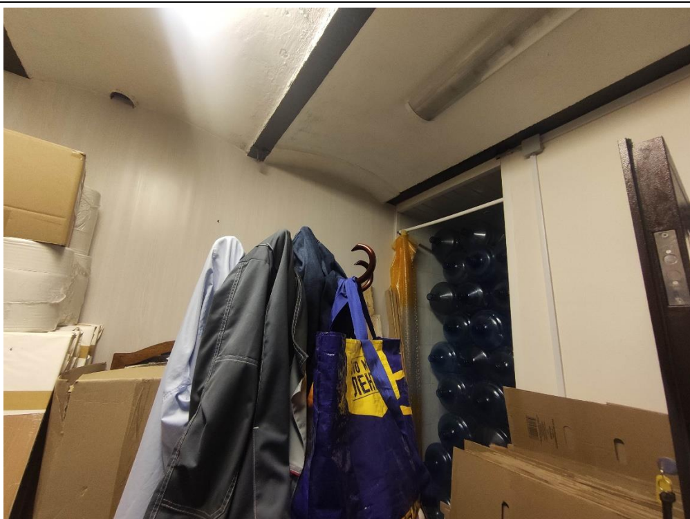
22. Объект культурного наследия регионального значения «Главный дом», расположенный по адресу: г. Санкт-Петербург, набережная Лейтенанта Шмидта, дом 31, литера А, входящий в состав объекта культурного наследия регионального значения «Дом Утеман Ф.Ф.». Фрагмент пом. № 1-Н(12) первого этажа.
