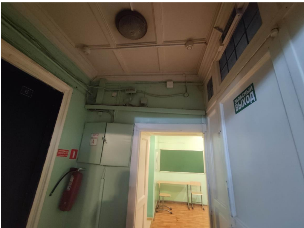
39. Объект культурного наследия регионального значения «Главный дом», расположенный по адресу: г. Санкт-Петербург, набережная Лейтенанта Шмидта, дом 31, литера А, входящий в состав объекта культурного наследия регионального значения «Дом Утеман Ф.Ф.». Фрагмент пом. № 1-Н(78) второго этажа.
