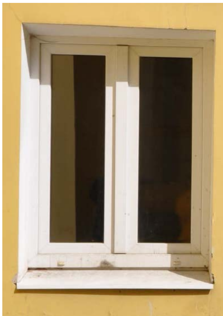
16. Оконное заполнение в уровне 1-ого этажа на дворовом фасаде объекта культурного наследия федерального значения «Дворец Таврический. Дворец», расположенного по адресу: г. Санкт-Петербург, ул. Шпалерная, д. 47, лит. А. 15.12.2022
