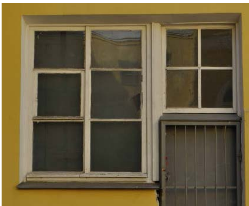
18. Оконное заполнение в уровне 1-ого этажа на дворовом фасаде объекта культурного наследия федерального значения «Дворец Таврический. Дворец», расположенного по адресу: г. Санкт-Петербург, ул. Шпалерная, д. 47, лит. А. 15.12.2022
