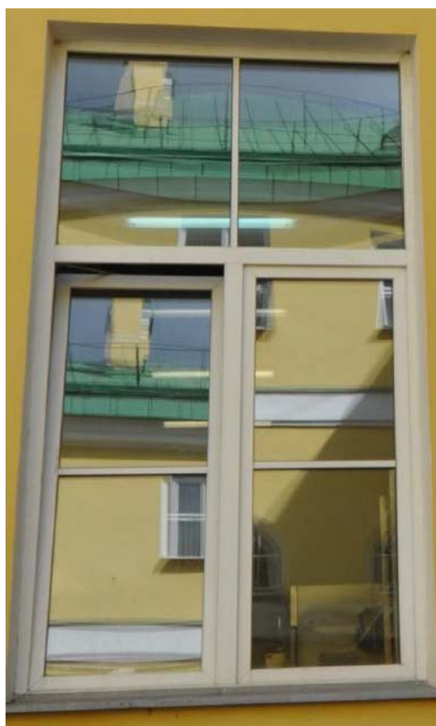
17. Оконное заполнение в уровне 1-ого этажа на дворовом фасаде объекта культурного наследия федерального значения «Дворец Таврический. Дворец», расположенного по адресу: г. Санкт-Петербург, ул. Шпалерная, д. 47, лит. А. 15.12.2022
