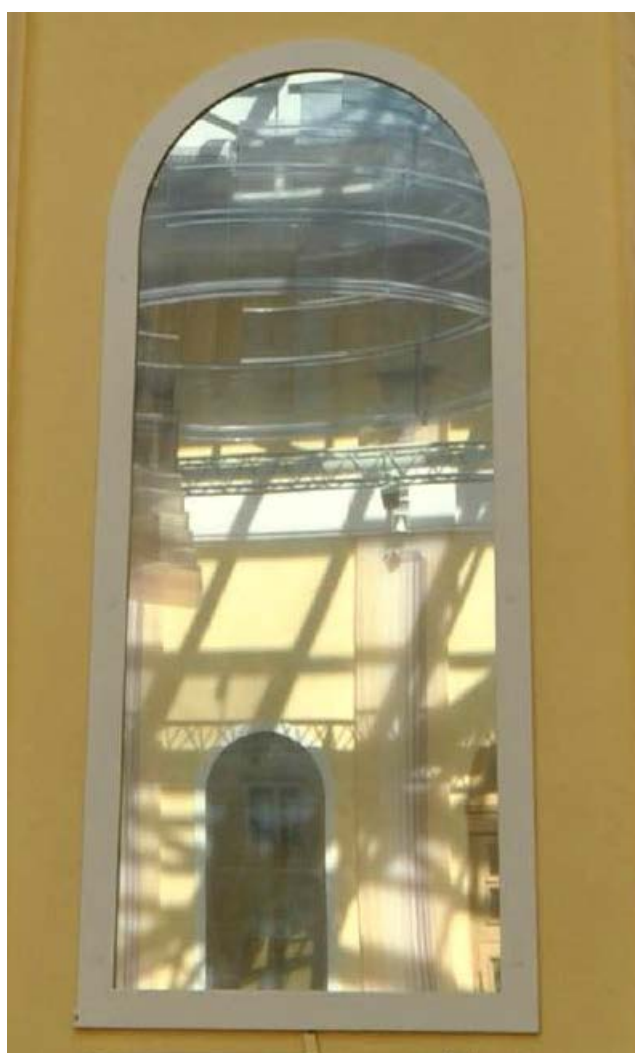
15. Оконное заполнение в уровне 1-ого этажа на дворовом фасаде объекта культурного наследия федерального значения «Дворец Таврический. Дворец», расположенного по адресу: г. Санкт-Петербург, ул. Шпалерная, д. 47, лит. А. 15.12.2022
