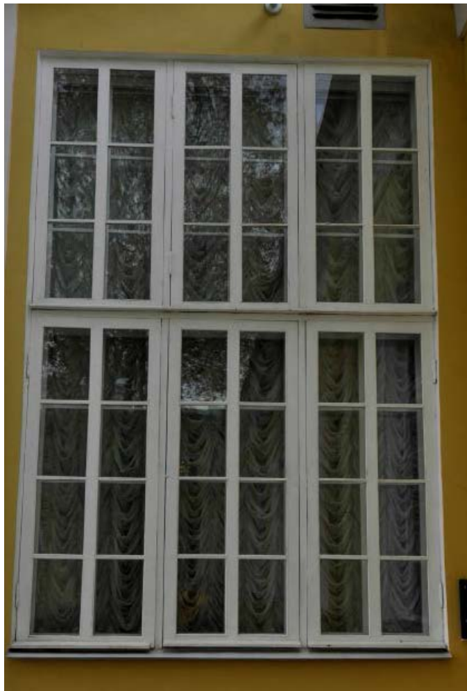
12. Оконное заполнение в уровне 1-ого этажа на дворовом фасаде объекта культурного наследия федерального значения «Дворец Таврический. Дворец», расположенного по адресу: г. Санкт-Петербург, ул. Шпалерная, д. 47, лит. А. 15.12.2022
