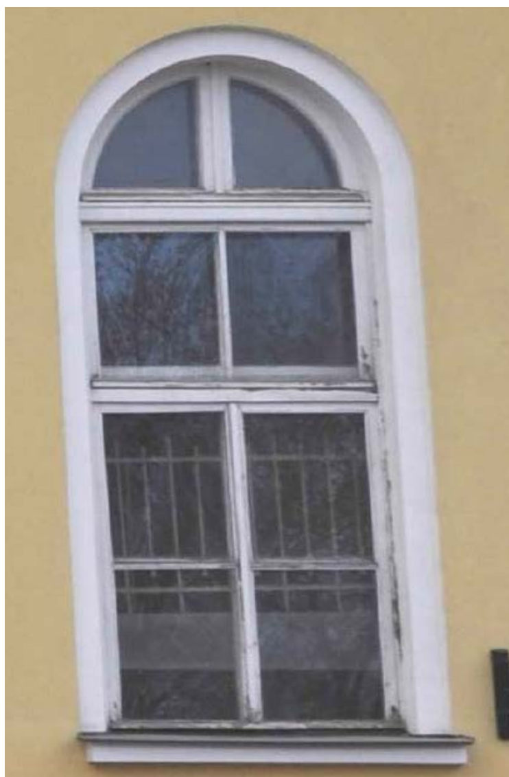
б. Оконное заполнение в уровне 1-ого этажа объекта культурного наследия федерального значения «Дворец Таврический. Дворец», расположенного по адресу: г. Санкт-Петербург, ул. Шпалерная, д. 47, лит. А. 15.12.2022
