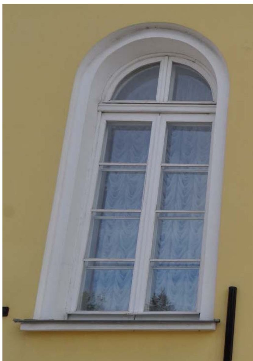
2. Оконное заполнение в уровне 1-ого этажа объекта культурного наследия федерального значения «Дворец Таврический. Дворец», расположенного по адресу: г. Санкт-Петербург, ул. Шпалерная, д. 47, лит. А. 15.12.2022
