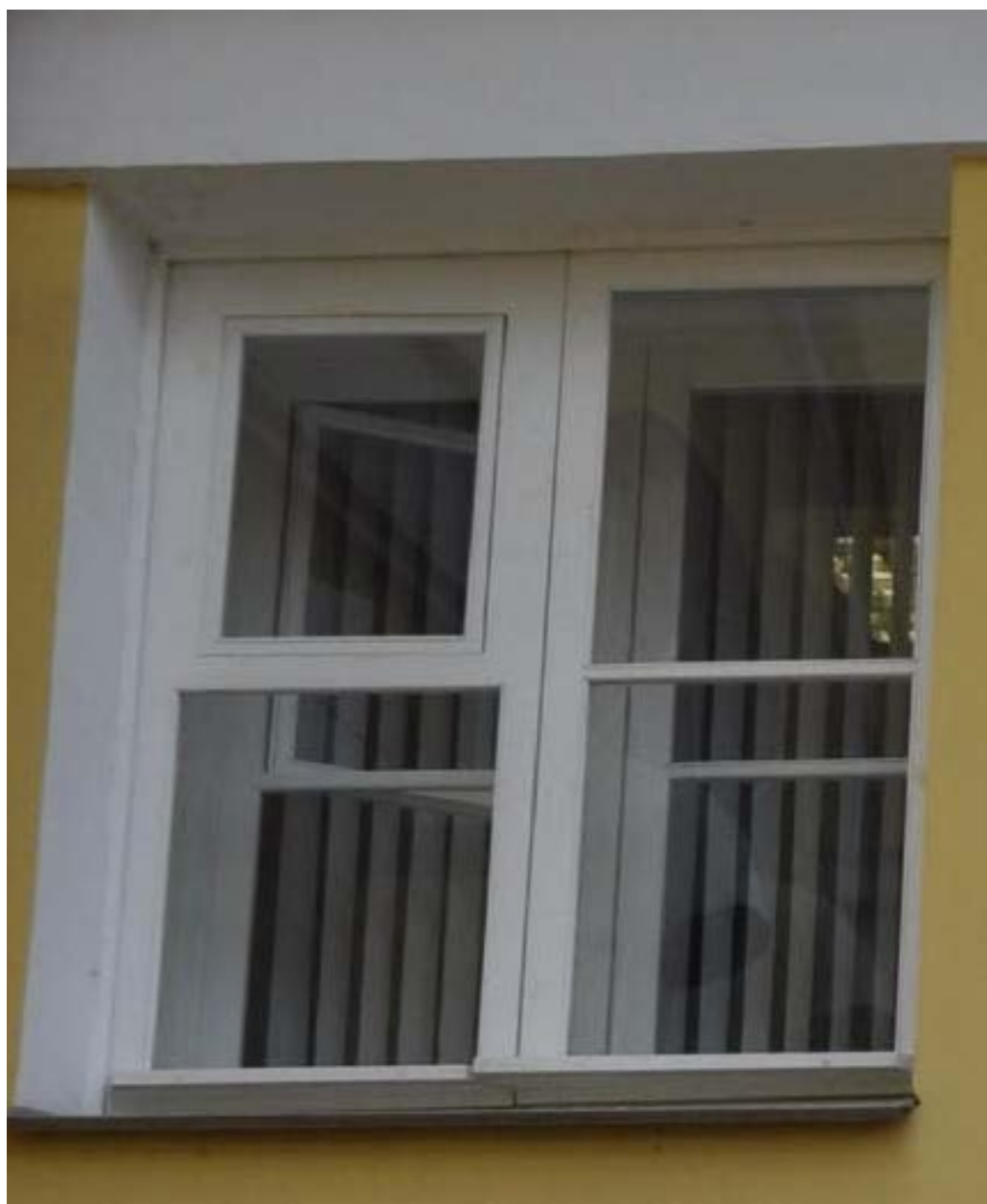
19. Оконное заполнение в уровне антресольного этажа объекта культурного наследия федерального значения «Дворец Таврический. Дворец», расположенного по адресу: г. Санкт-Петербург, ул. Шпалерная, д. 47, лит. А. 15.12.2022
