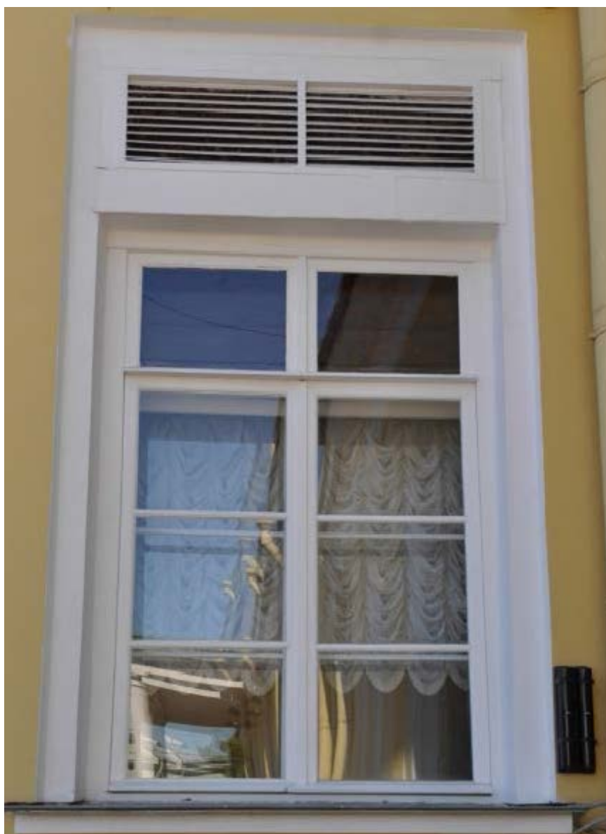
8. Оконное заполнение в уровне 1-ого этажа на дворовом фасаде объекта культурного наследия федерального значения «Дворец Таврический. Дворец», расположенного по адресу: г. Санкт-Петербург, ул. Шпалерная, д. 47, лит. А. 15.12.2022
