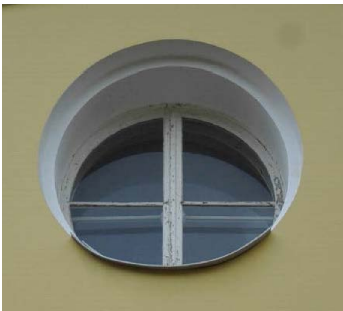
25. Оконное заполнение в уровне 2-ого этажа объекта культурного наследия федерального значения «Дворец Таврический. Дворец», расположенного по адресу: г. Санкт-Петербург, ул. Шпалерная, д. 47, лит. А. 15.12.2022
