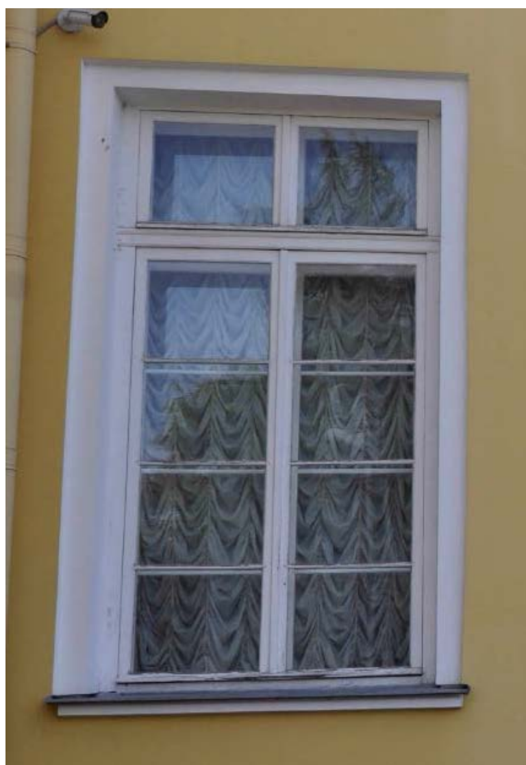
7. Оконное заполнение в уровне 1-ого этажа объекта культурного наследия федерального значения «Дворец Таврический. Дворец», расположенного по адресу: г. Санкт-Петербург, ул. Шпалерная, д. 47, лит. А. 15.12.2022
