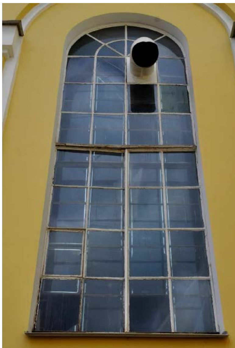
10. Оконное заполнение в уровне 1-ого этажа на дворовом фасаде объекта культурного наследия федерального значения «Дворец Таврический. Дворец», расположенного по адресу: г. Санкт-Петербург, ул. Шпалерная, д. 47, лит. А. 15.12.2022
