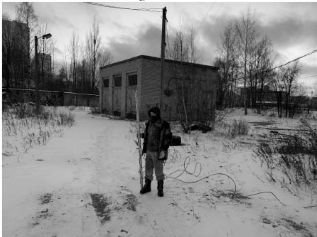
Рис. 21. Пр. Энергетиков, д. 15А, КН:78:11:0604602:1-2022. Точка фотофиксации 5, вид на юго-запад.
