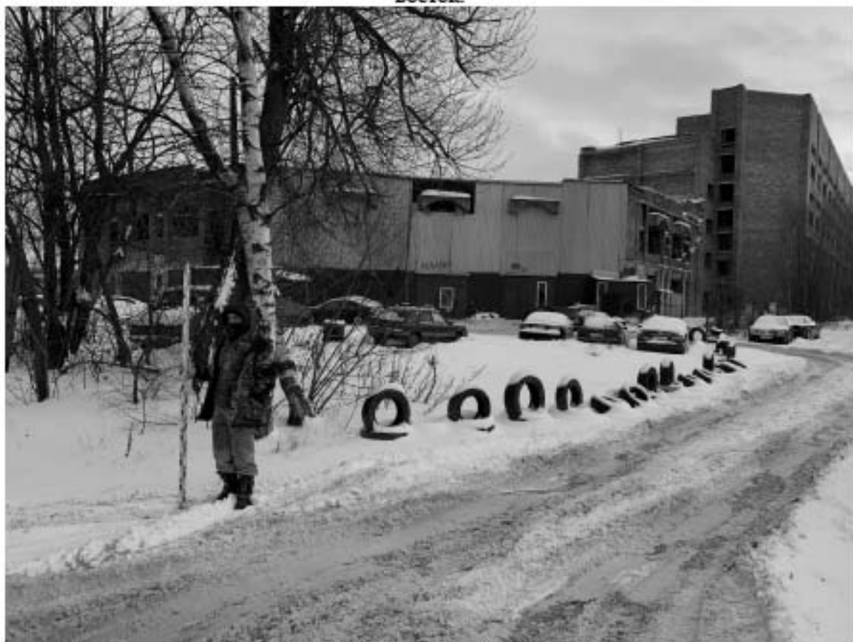
Рис. 16. Пр. Энергетиков, д. 15А, КН:78:11:0604602:1-2022. Точка фотофиксации 3, вид на юго-восток.
