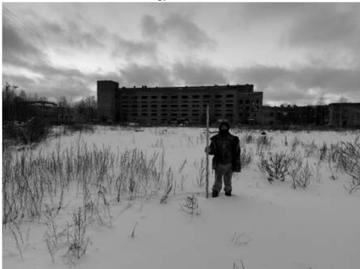
Рис. 30. Пр. Энергетиков, д. 15А, КН:78:11:0604602:1-2022. Точка фотофиксации 7, вид на юго-запад.
