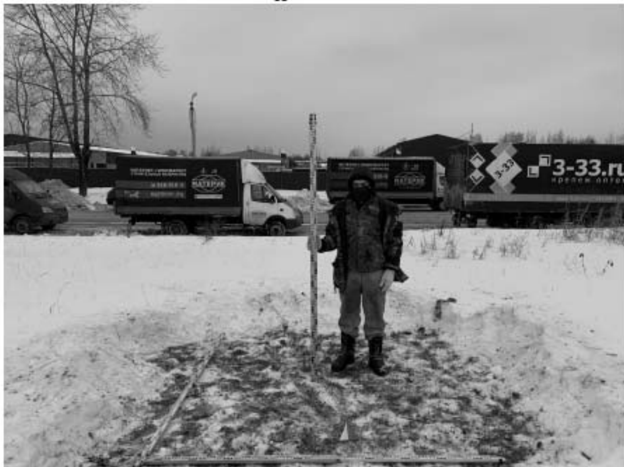
Рис. 33. Пр. Энергетиков, д. 15А, КН:78:11:0604602:1-2022. Местоположение шурфа 1, вид на север.
