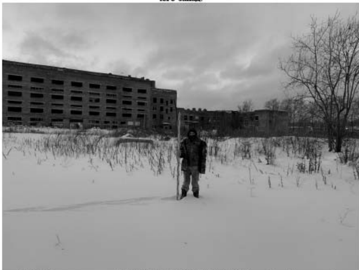
Рис. 27. Пр. Энергетиков, д. 15А, КН:78:11:0604602:1-2022. Точка фотофиксации 6, вид на северо-запад.
