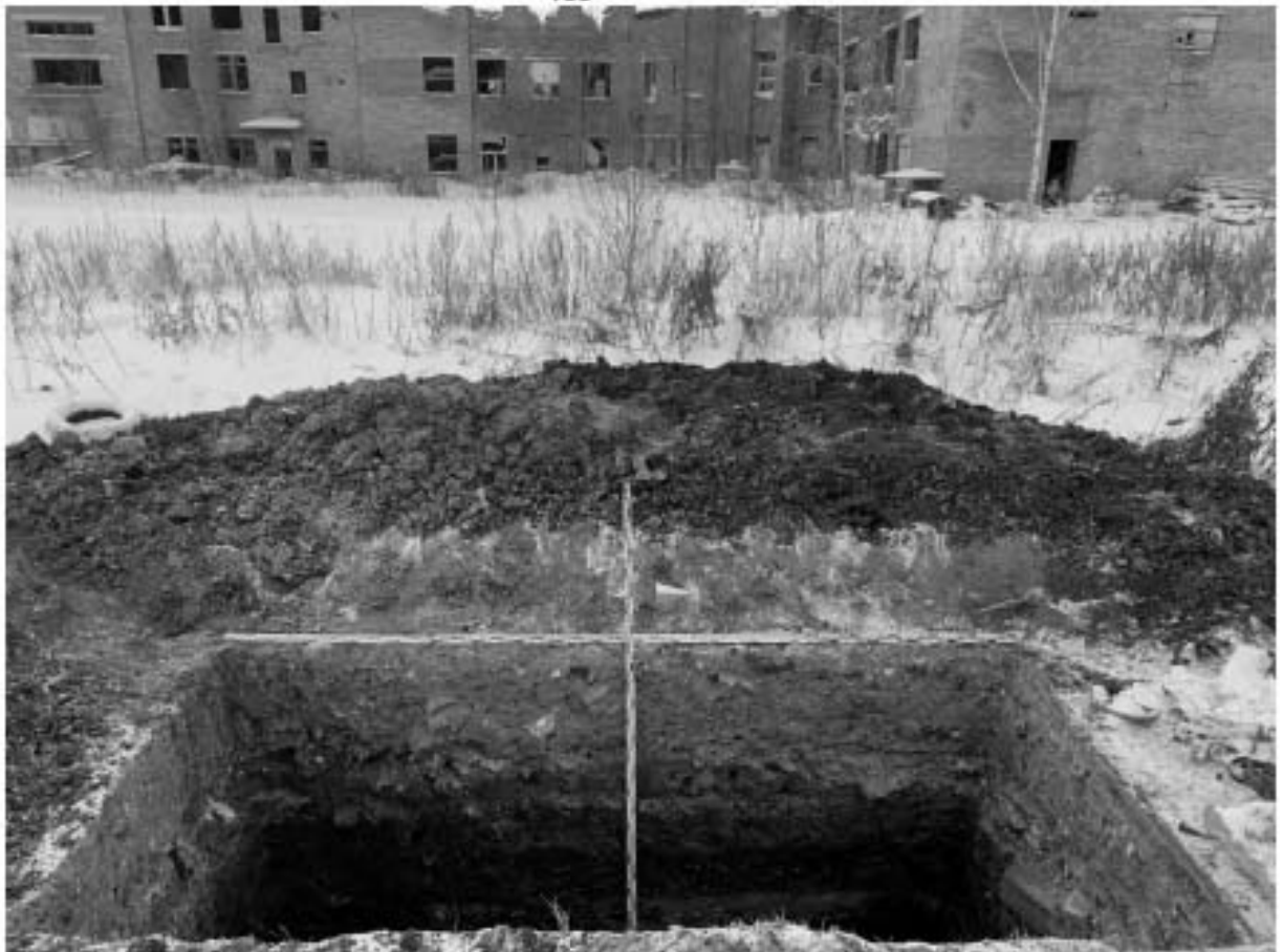
Рис. 57. Пр. Энергетиков, д. 15А, КН:78:11:0604602:1-2022. Шурф 2, западная стенка.
