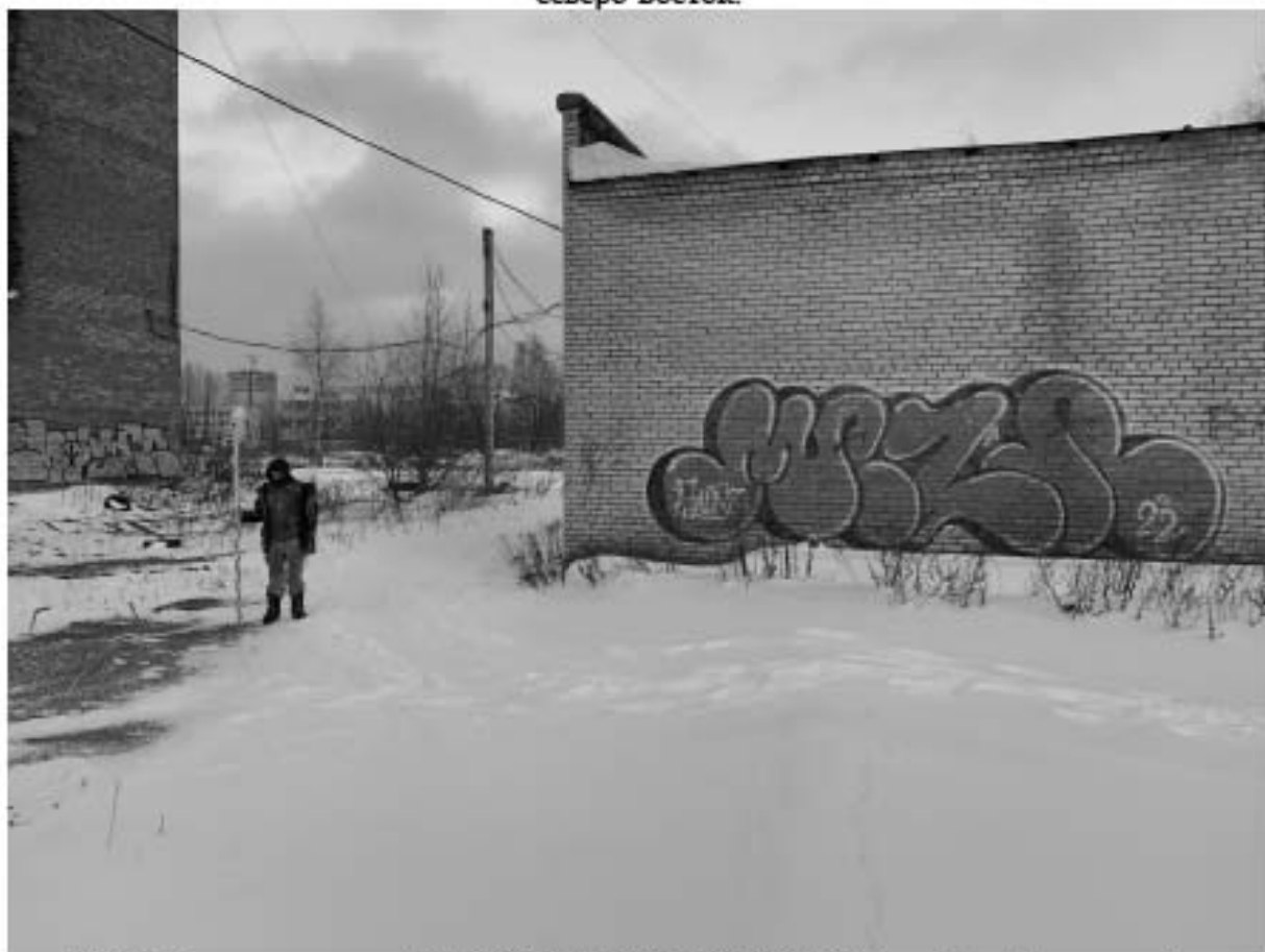
Рис. 20. Пр. Энергетиков, д. 15А, КН:78:11:0604602:1-2022. Точка фотофиксации 4, вид на восток.
