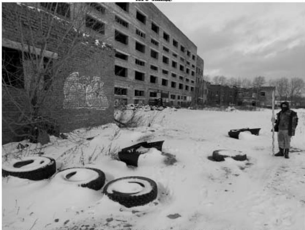
Рис. 22. Пр. Энергетиков, д. 15А, КН:78:11:0604602:1-2022. Точка фотофиксации 5, вид на северо-запад.
