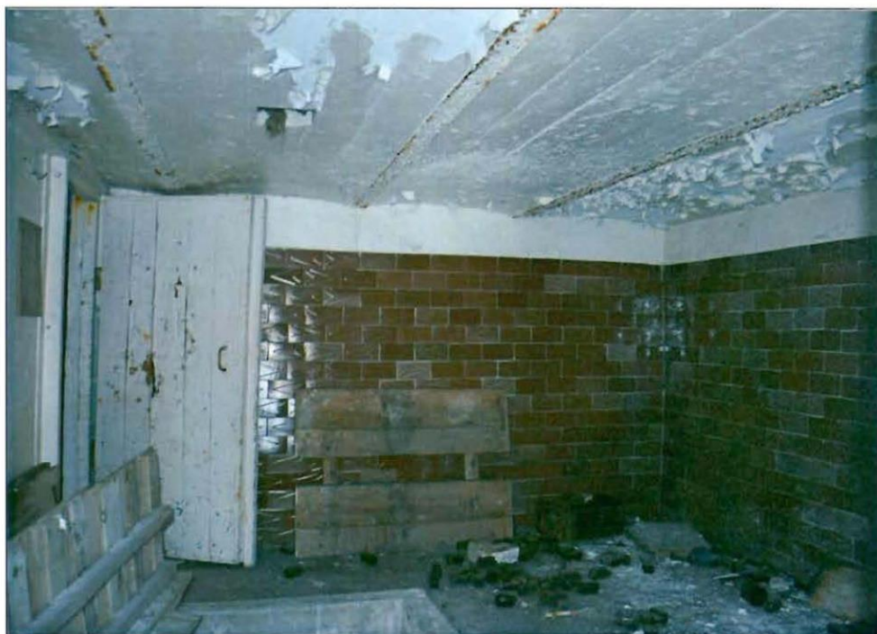
20. Санкт-Петербург, г. Кронштадт, Кронштадтское шоссе, д. 30, лит. К. Перекрытие.
