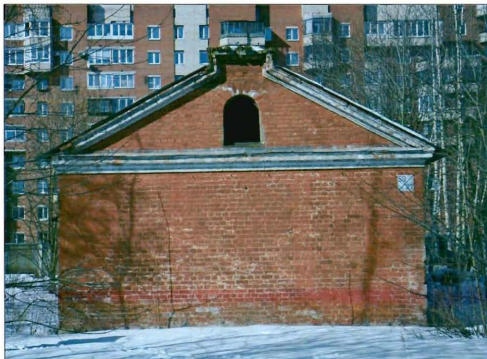
17. Санкт-Петербург, г. Кронштадт, Кронштадтское шоссе, д. 30, лит. И. Восточный фасад.
