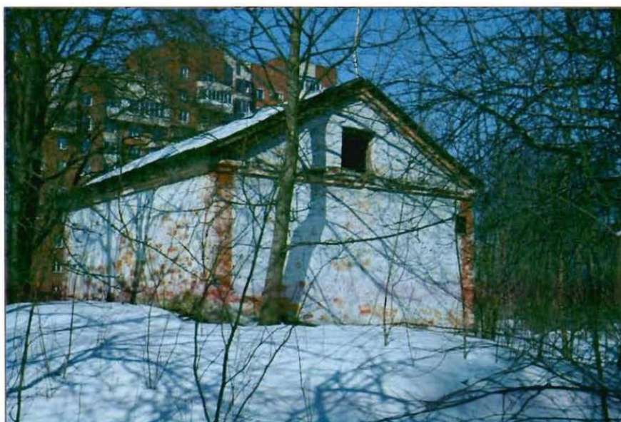
19. Санкт-Петербург, г. Кронштадт, Кронштадтское шоссе, д. 30, лит. К. Общий вид с юга.
