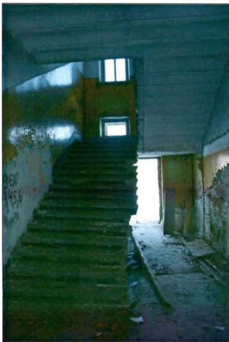
10. Санкт-Петербург, г. Кронштадт, Кронштадтское шоссе, д. 30, лит. Е. Лестница.
