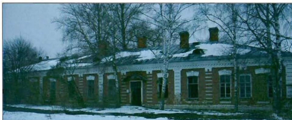
4. Санкт-Петербург, г. Кронштадт, Кронштадтское шоссе, д. 30, лит. Д. Общий вид с востока.
