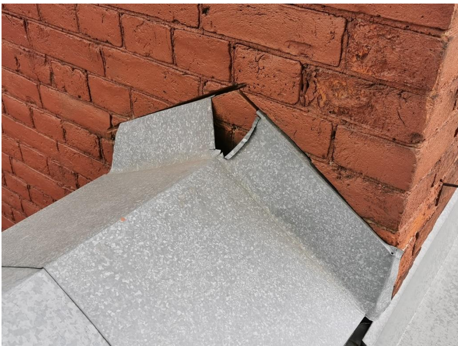
38. «Машинное отделение №2 с конторой главного механика» в составе ансамбля «Комплекс главной станции Санкт-Петербургских городских водопроводов», ул. Шпалерная, д. 56, лит. Е. Крыша. Фрагмент. Фото 08.08.2022г.
