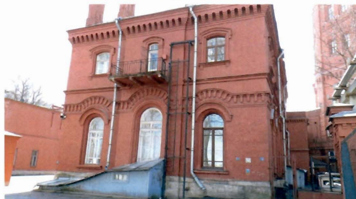
2. Северный фасад здания
