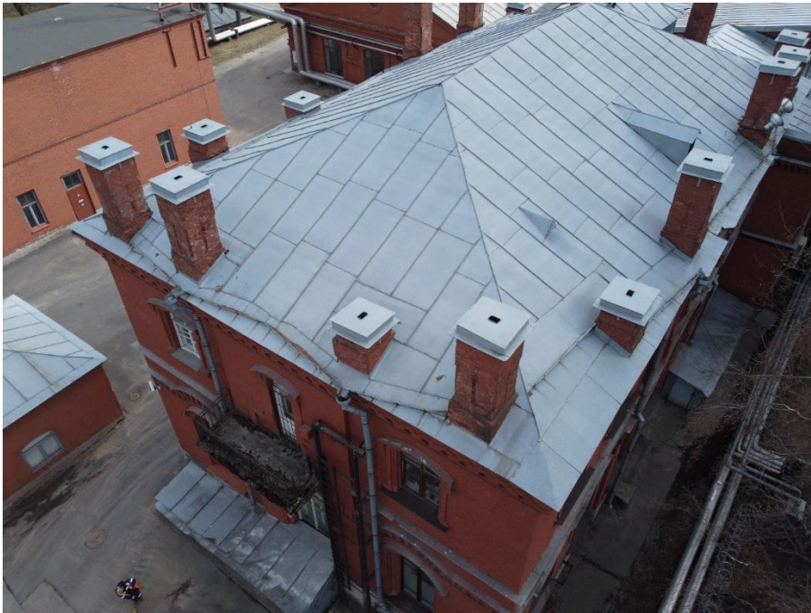
27. «Машинное отделение №2 с конторой главного механика» в составе ансамбля «Комплекс главной станции Санкт-Петербургских городских водопроводов», ул. Шпалерная, д. 56, лит. Е. Крыша. Общий вид. Фото 08.08.2022г.
