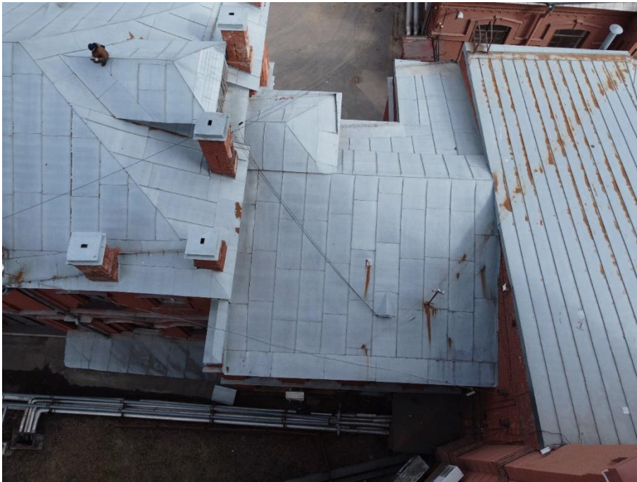
29. «Машинное отделение №2 с конторой главного механика» в составе ансамбля «Комплекс главной станции Санкт-Петербургских городских водопроводов», ул. Шпалерная, д. 56, лит. Е. Крыша. Общий вид. Фото 08.08.2022г.
