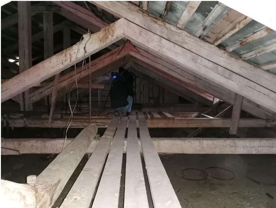
7. «Машинное отделение №2 с конторой главного механика» в составе ансамбля «Комплекс главной станции Санкт-Петербургских городских водопроводов», ул. Шпалерная, д. 56, лит. Е. Чердак. Общий вид. Фото 08.08.2022г.
