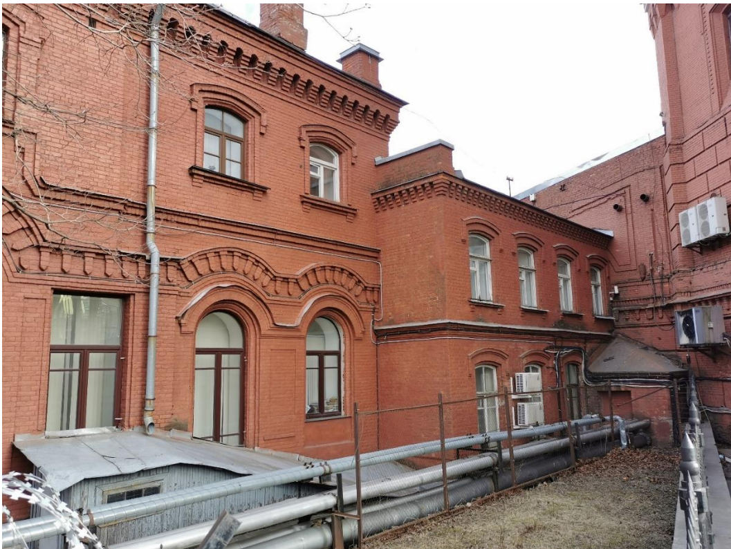
4. «Машинное отделение №2 с конторой главного механика» в составе ансамбля «Комплекс главной станции Санкт-Петербургских городских водопроводов», ул. Шпалерная, д. 56, лит. Е. Западный фасад. Общий вид. Фото 08.08.2022г.
