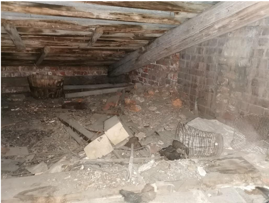
16. «Машинное отделение №2 с конторой главного механика» в составе ансамбля «Комплекс главной станции Санкт-Петербургских городских водопроводов», ул. Шпалерная, д. 56, лит. Е. Чердак. Фрагмент. Фото 08.08.2022г.
