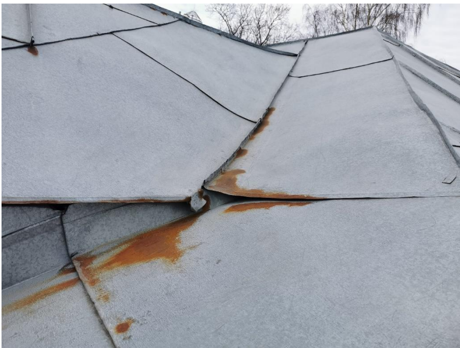
34. «Машинное отделение №2 с конторой главного механика» в составе ансамбля «Комплекс главной станции Санкт-Петербургских городских водопроводов», ул. Шпалерная, д. 56, лит. Е. Крыша. Фрагмент. Фото 08.08.2022г.
