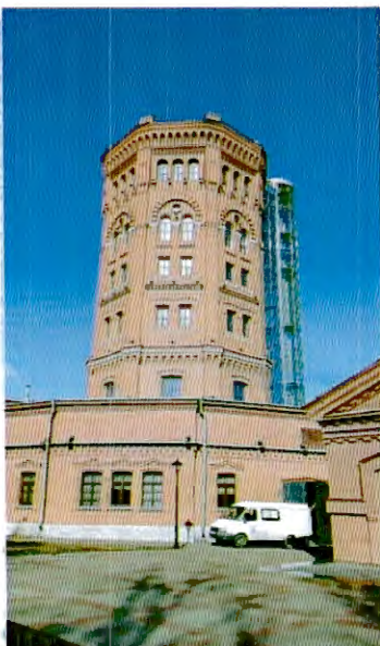
2. Общий вид с восточной стороны фасада
