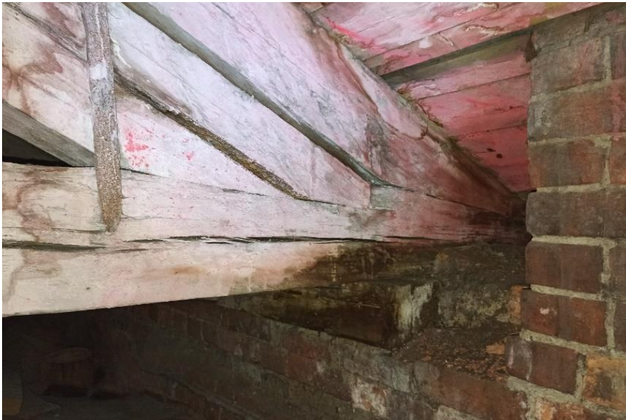
17. «Машинное отделение №2 с конторой главного механика» в составе ансамбля «Комплекс главной станции Санкт-Петербургских городских водопроводов», ул. Шпалерная, д. 56, лит. Е. Чердак. Фрагмент. Фото 08.08.2022г.
