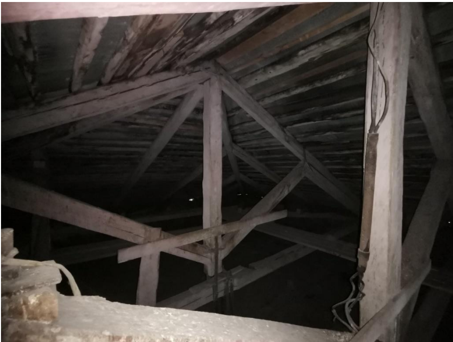
10. «Машинное отделение №2 с конторой главного механика» в составе ансамбля «Комплекс главной станции Санкт-Петербургских городских водопроводов», ул. Шпалерная, д. 56, лит. Е. Чердак. Фрагмент. Фото 08.08.2022г.
