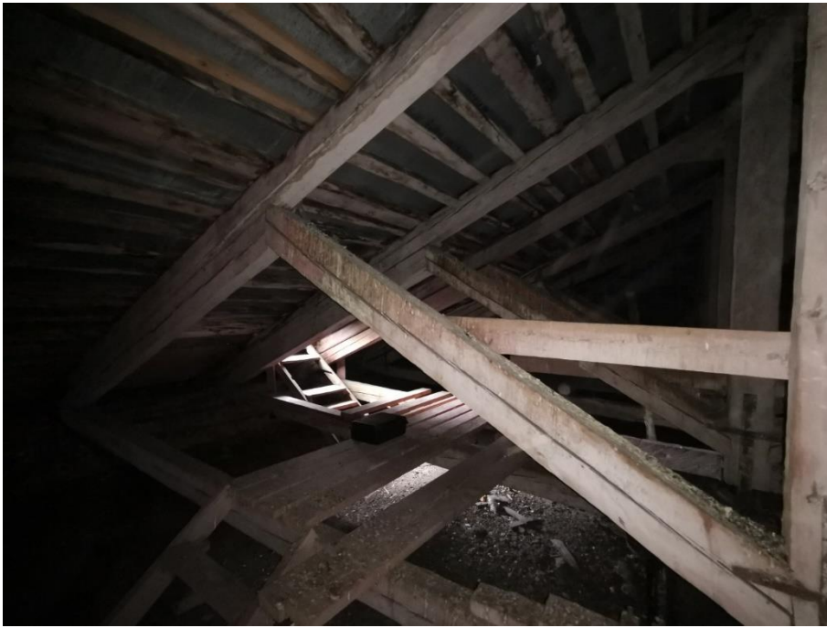
13. «Машинное отделение №2 с конторой главного механика» в составе ансамбля «Комплекс главной станции Санкт-Петербургских городских водопроводов», ул. Шпалерная, д. 56, лит. Е. Чердак. Фрагмент. Фото 08.08.2022г.
