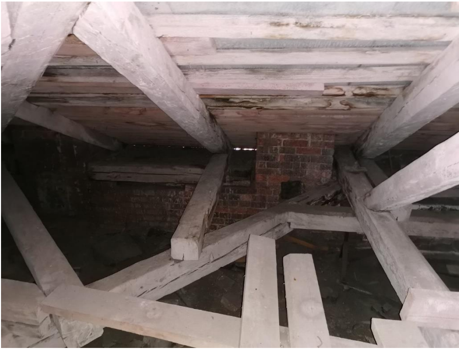
9. «Машинное отделение №2 с конторой главного механика» в составе ансамбля «Комплекс главной станции Санкт-Петербургских городских водопроводов», ул. Шпалерная, д. 56, лит. Е. Чердак. Фрагмент. Фото 08.08.2022г.
