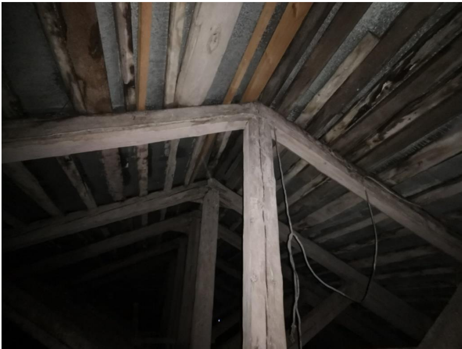
14. «Машинное отделение №2 с конторой главного механика» в составе ансамбля «Комплекс главной станции Санкт-Петербургских городских водопроводов», ул. Шпалерная, д. 56, лит. Е. Чердак. Фрагмент. Фото 08.08.2022г.
