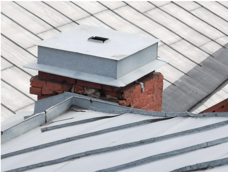
32. «Машинное отделение №2 с конторой главного механика» в составе ансамбля «Комплекс главной станции Санкт-Петербургских городских водопроводов», ул. Шпалерная, д. 56, лит. Е. Крыша. Фрагмент. Фото 08.08.2022г.
