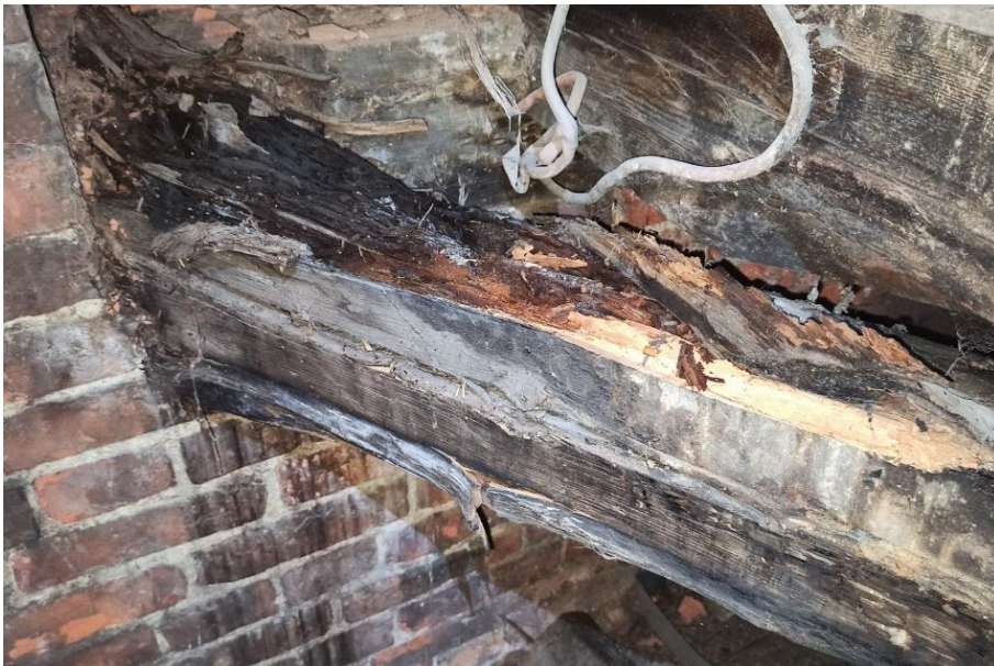
18. «Машинное отделение №2 с конторой главного механика» в составе ансамбля «Комплекс главной станции Санкт-Петербургских городских водопроводов», ул. Шпалерная, д. 56, лит. Е. Чердак. Фрагмент. Фото 08.08.2022г.
