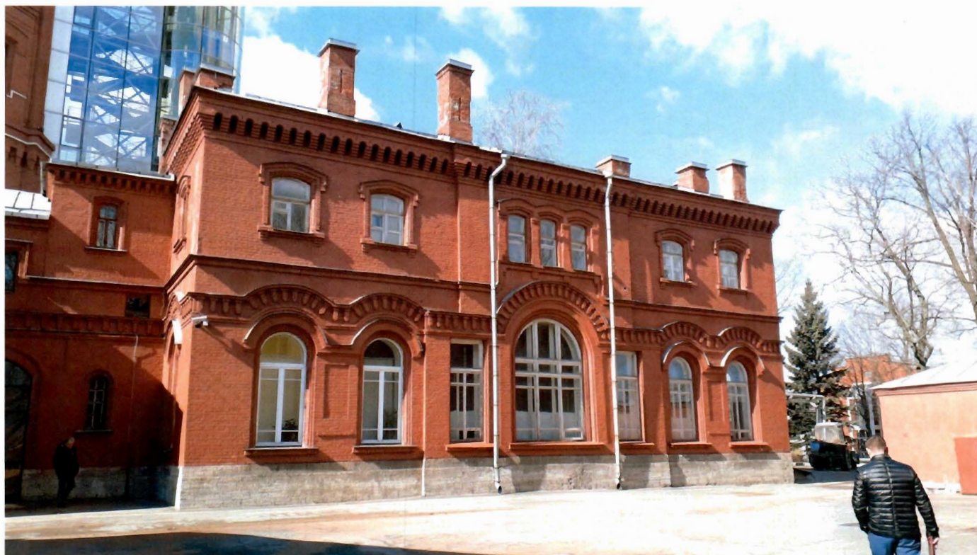
1. Восточный фасад здания
