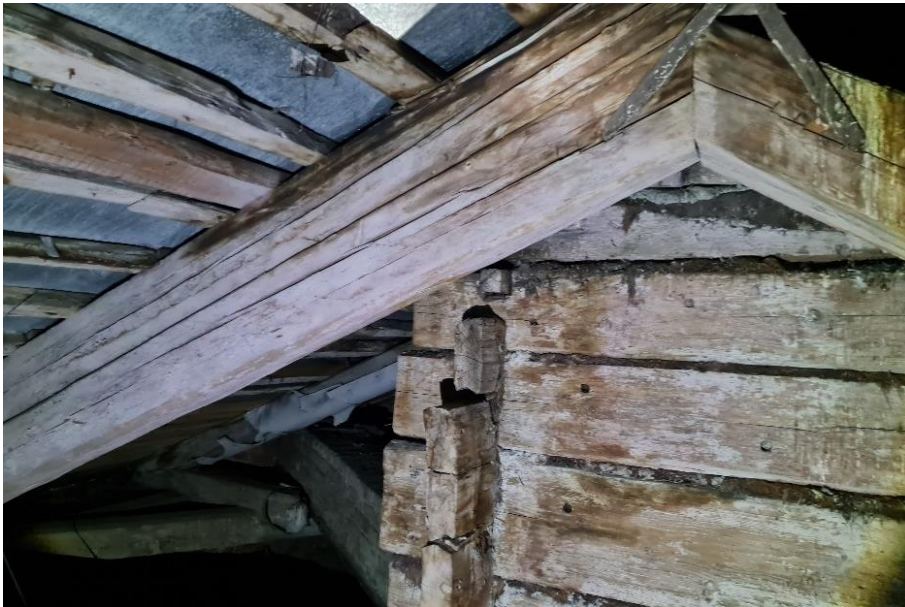
15. «Машинное отделение №2 с конторой главного механика» в составе ансамбля «Комплекс главной станции Санкт-Петербургских городских водопроводов», ул. Шпалерная, д. 56, лит. Е. Чердак. Фрагмент. Фото 08.08.2022г.
