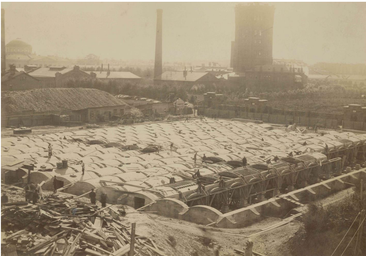
Илл. 14. Строительство фильтров. кон. 1880-х гг.
