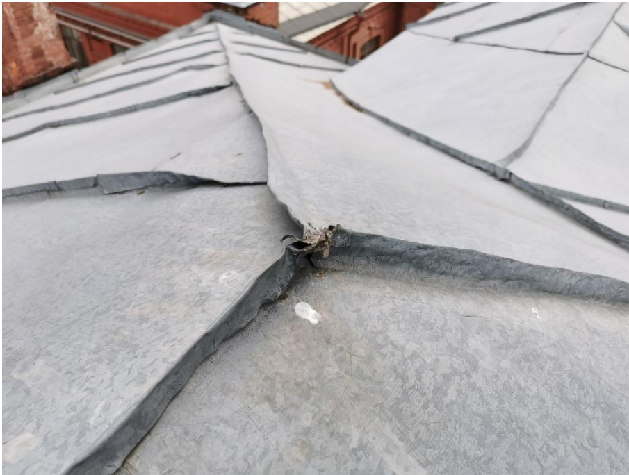
33. «Машинное отделение №2 с конторой главного механика» в составе ансамбля «Комплекс главной станции Санкт-Петербургских городских водопроводов», ул. Шпалерная, д. 56, лит. Е. Крыша. Фрагмент. Фото 08.08.2022г.
