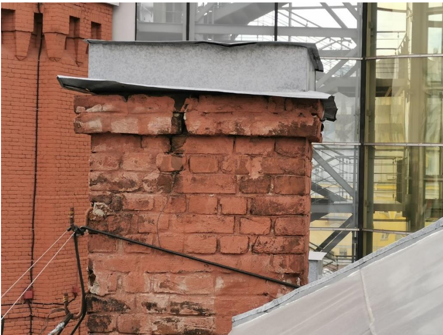
36. «Машинное отделение №2 с конторой главного механика» в составе ансамбля «Комплекс главной станции Санкт-Петербургских городских водопроводов», ул. Шпалерная, д. 56, лит. Е. Крыша. Фрагмент. Фото 08.08.2022г.
