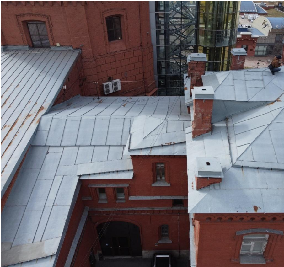
24. «Машинное отделение №2 с конторой главного механика» в составе ансамбля «Комплекс главной станции Санкт-Петербургских городских водопроводов», ул. Шпалерная, д. 56, лит. Е. Крыша. Общий вид. Фото 08.08.2022г.
