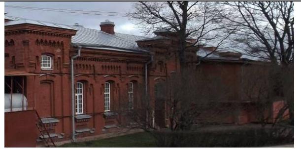
Южный фасад юго-западного корпуса
