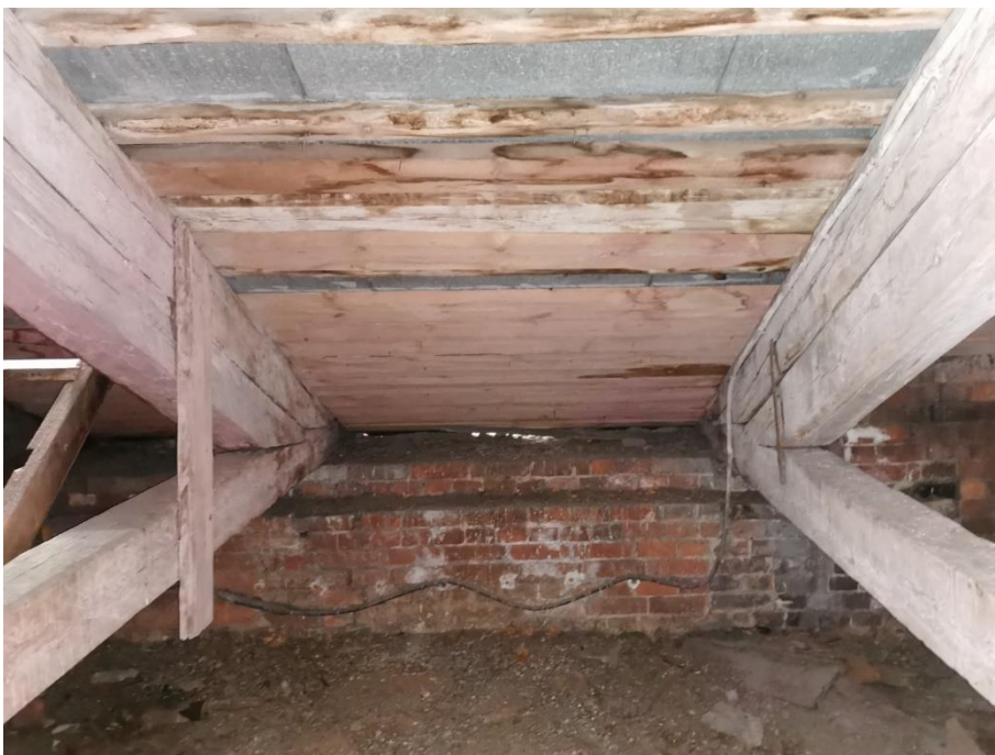
12. «Машинное отделение №2 с конторой главного механика» в составе ансамбля «Комплекс главной станции Санкт-Петербургских городских водопроводов», ул. Шпалерная, д. 56, лит. Е. Чердак. Фрагмент. Фото 08.08.2022г.
