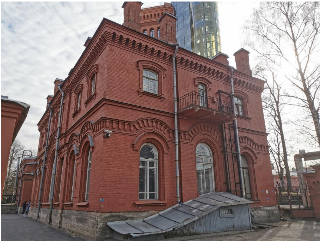
2. «Машинное отделение №2 с конторой главного механика» в составе ансамбля «Комплекс главной станции Санкт-Петербургских городских водопроводов», ул. Шпалерная, д. 56, лит. Е. Северный фасад. Общий вид. Фото 08.08.2022г.
