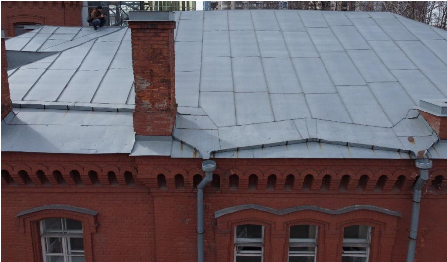
25. «Машинное отделение №2 с конторой главного механика» в составе ансамбля «Комплекс главной станции Санкт-Петербургских городских водопроводов», ул. Шпалерная, д. 56, лит. Е. Крыша. Общий вид. Фото 08.08.2022г.
