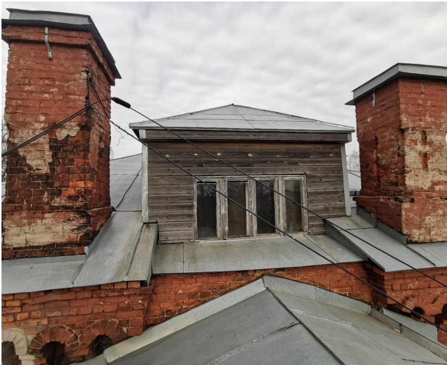
37. «Машинное отделение №2 с конторой главного механика» в составе ансамбля «Комплекс главной станции Санкт-Петербургских городских водопроводов», ул. Шпалерная, д. 56, лит. Е. Крыша. Фрагмент. Фото 08.08.2022г.
