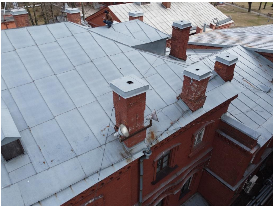
28. «Машинное отделение №2 с конторой главного механика» в составе ансамбля «Комплекс главной станции Санкт-Петербургских городских водопроводов», ул. Шпалерная, д. 56, лит. Е. Крыша. Общий вид. Фото 08.08.2022г.
