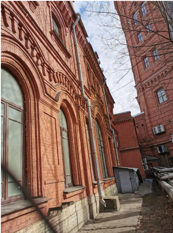
3. «Машинное отделение №2 с конторой главного механика» в составе ансамбля «Комплекс главной станции Санкт-Петербургских городских водопроводов», ул. Шпалерная, д. 56, лит. Е. Западный фасад. Общий вид. Фото 08.08.2022г.
