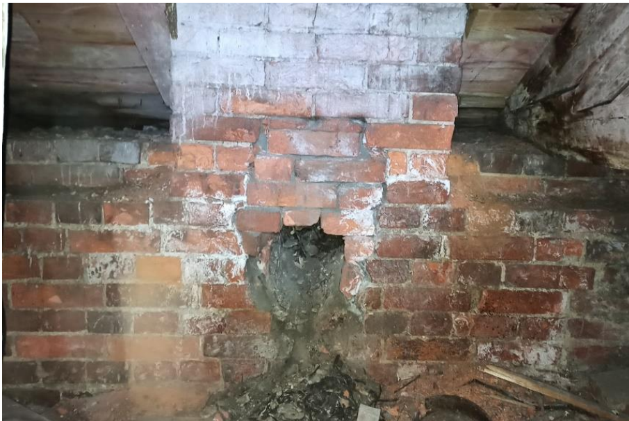
20. «Машинное отделение №2 с конторой главного механика» в составе ансамбля «Комплекс главной станции Санкт-Петербургских городских водопроводов», ул. Шпалерная, д. 56, лит. Е. Чердак. Фрагмент. Фото 08.08.2022г.
