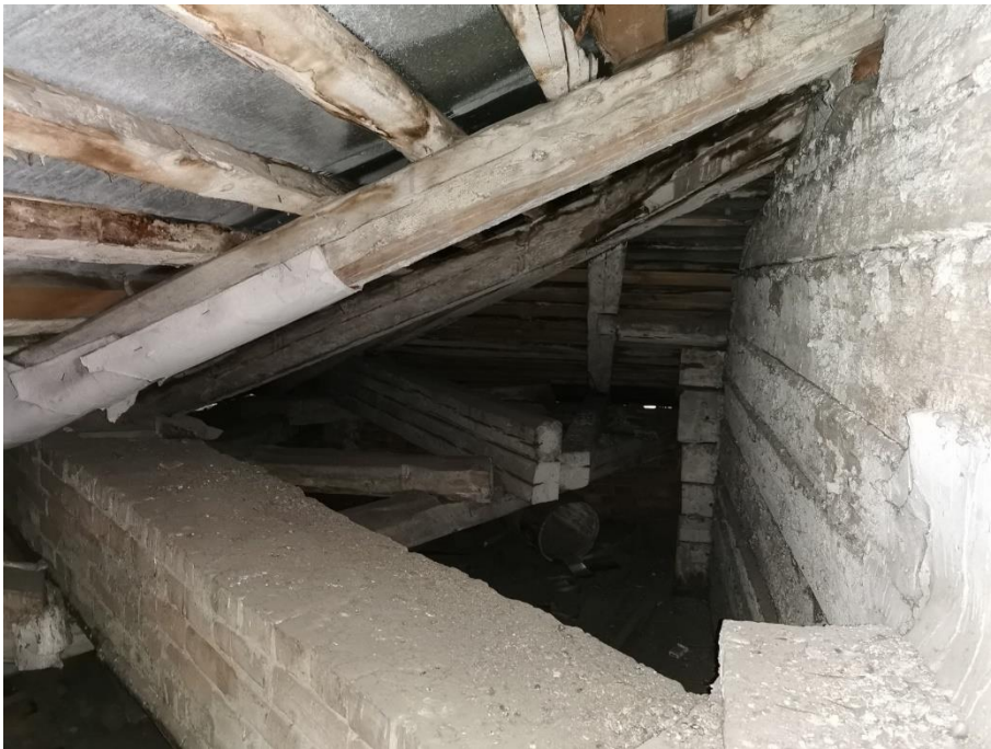
6. «Машинное отделение №2 с конторой главного механика» в составе ансамбля «Комплекс главной станции Санкт-Петербургских городских водопроводов», ул. Шпалерная, д. 56, лит. Е. Чердак. Общий вид. Фото 08.08.2022г.
