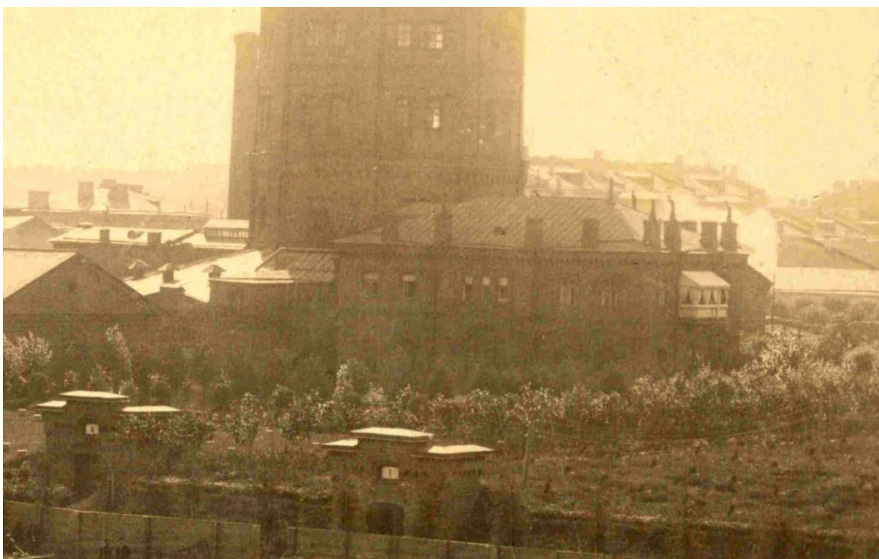
Илл. 15. Строительство фильтров. кон. 1880-х гг. (фрагмент)
