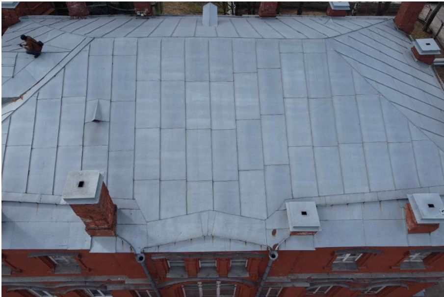
23. «Машинное отделение №2 с конторой главного механика» в составе ансамбля «Комплекс главной станции Санкт-Петербургских городских водопроводов», ул. Шпалерная, д. 56, лит. Е. Крыша. Общий вид. Фото 08.08.2022г.
