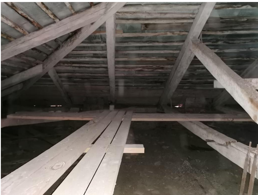
8. «Машинное отделение №2 с конторой главного механика» в составе ансамбля «Комплекс главной станции Санкт-Петербургских городских водопроводов», ул. Шпалерная, д. 56, лит. Е. Чердак. Общий вид. Фото 08.08.2022г.
