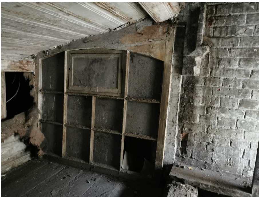
40. «Машинное отделение №2 с конторой главного механика» в составе ансамбля «Комплекс главной станции Санкт-Петербургских городских водопроводов», ул. Шпалерная, д. 56, лит. Е. Крыша. Фрагмент. Фото 08.08.2022г.
