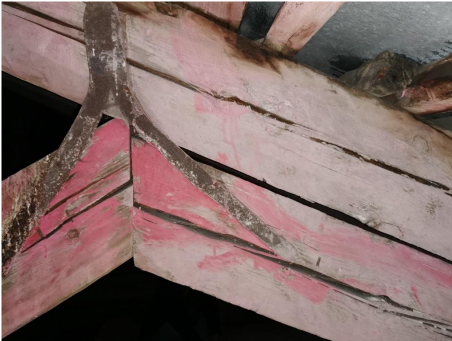
11. «Машинное отделение №2 с конторой главного механика» в составе ансамбля «Комплекс главной станции Санкт-Петербургских городских водопроводов», ул. Шпалерная, д. 56, лит. Е. Чердак. Фрагмент. Фото 08.08.2022г.
