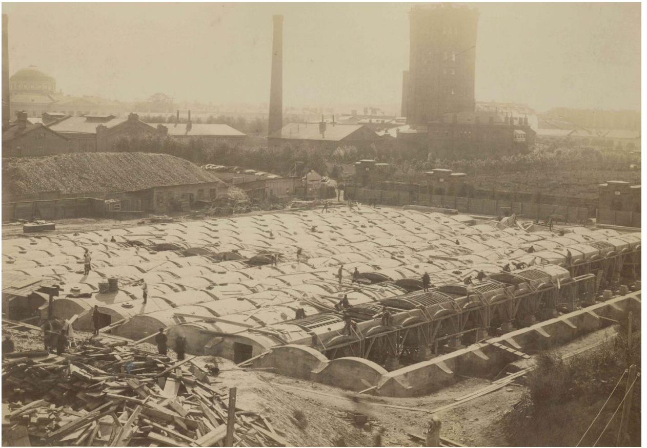
Илл. 5. Строительство фильтров. кон. 1880-х гг.
