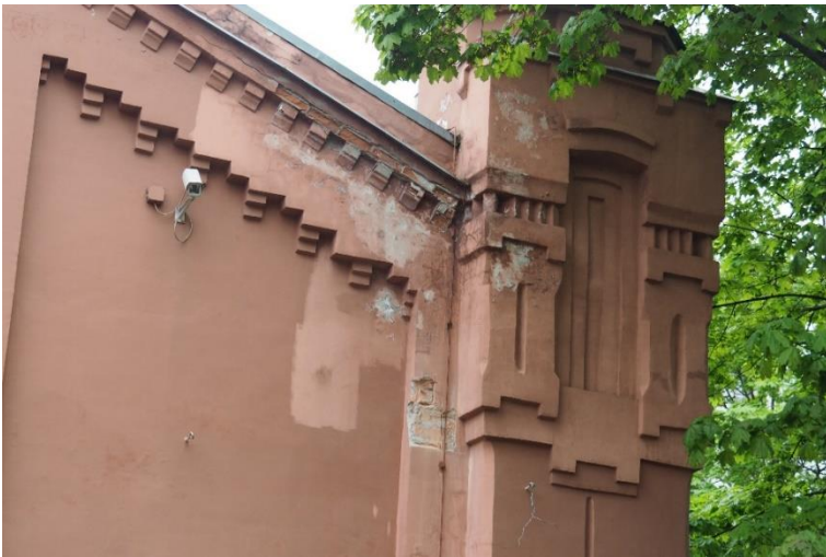
16. «Машинное отделение №6 с котельной» в составе ансамбля «Комплекс главной станции Санкт-Петербургских городских водопроводов», ул. Таврическая, д. 10, лит. А. Западный фасад. Фрагмент. Фото 08.08.2022г.
