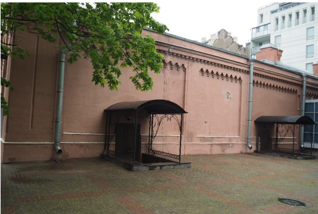
4. «Машинное отделение №6 с котельной» в составе ансамбля «Комплекс главной станции Санкт-Петербургских городских водопроводов», ул. Таврическая, д. 10, лит. А. Южный фасад. Общий вид. Фото 08.08.2022г.
