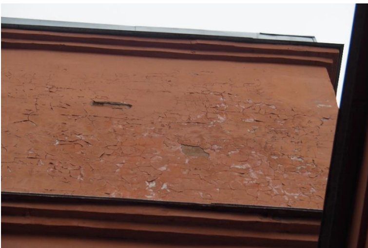
25. «Машинное отделение №6 с котельной» в составе ансамбля «Комплекс главной станции Санкт-Петербургских городских водопроводов», ул. Таврическая, д. 10, лит. А. Западный фасад. Фрагмент. Фото 08.08.2022г.
