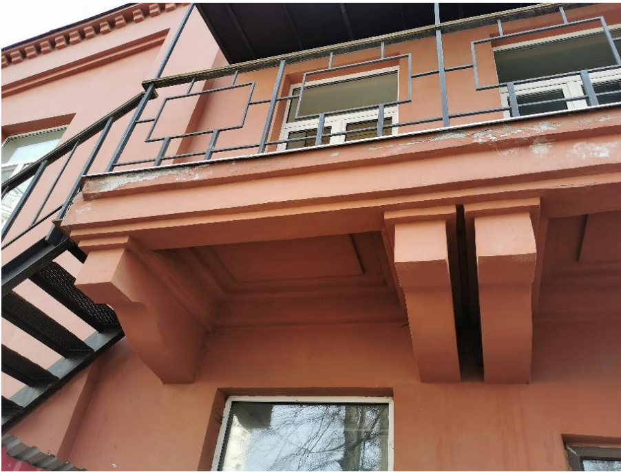
32. «Машинное отделение №6 с котельной» в составе ансамбля «Комплекс главной станции Санкт-Петербургских городских водопроводов», ул. Таврическая, д. 10, лит. А. Северный фасад. Фрагмент. Фото 08.08.2022г.
