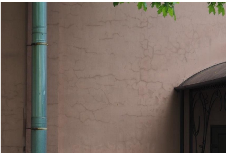
29. «Машинное отделение №6 с котельной» в составе ансамбля «Комплекс главной станции Санкт-Петербургских городских водопроводов», ул. Таврическая, д. 10, лит. А. Южный фасад. Фрагмент. Фото 08.08.2022г.
