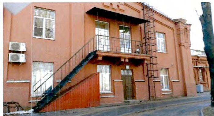
4. Северный фасад здания
