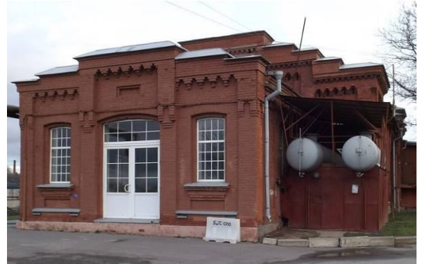
Ризалит западного фасада юго-западного корпуса
