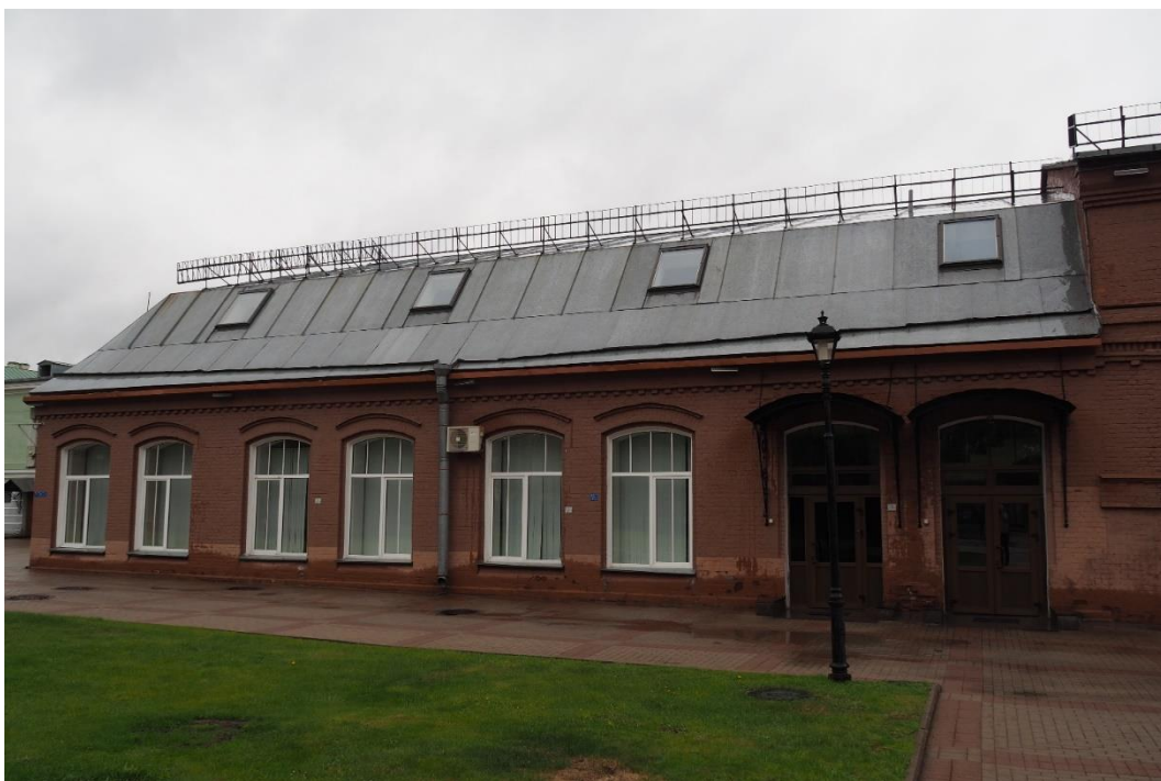
1. «Машинное отделение №3 с мастерскими и котельной и кладовые» в составе ансамбля «Комплекс главной станции Санкт-Петербургских городских водопроводов», ул. Шпалерная, д. 56, лит. АК. Восточный фасад. Общий вид. Фото 08.08.2022г.
