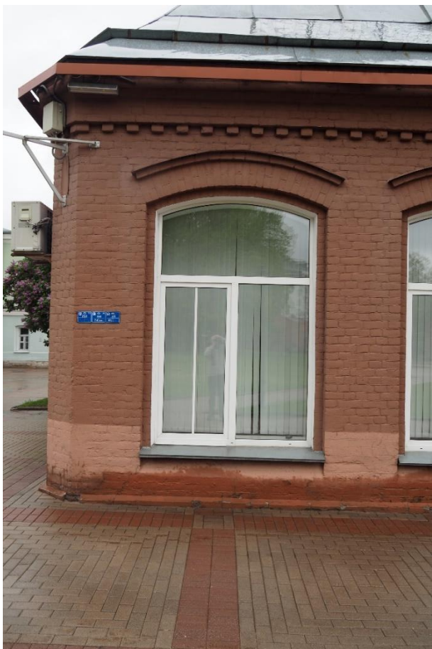
7. «Машинное отделение №3 с мастерскими и котельной и кладовые» в составе ансамбля «Комплекс главной станции Санкт-Петербургских городских водопроводов», ул. Шпалерная, д. 56, лит. АК. Восточный фасад. Фрагмент. Фото 08.08.2022г.
