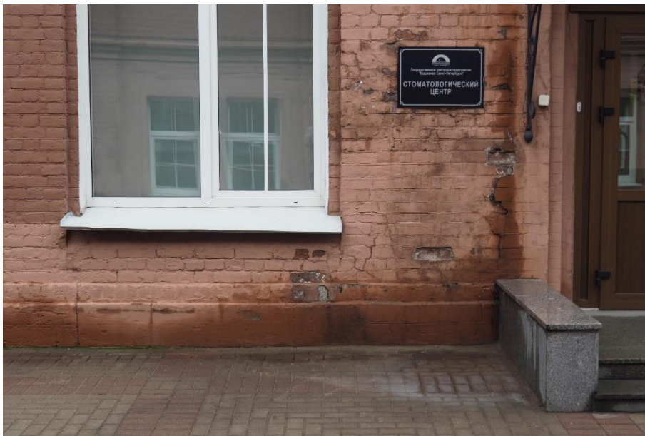
37. «Машинное отделение №3 с мастерскими и котельной и кладовые» в составе ансамбля «Комплекс главной станции Санкт-Петербургских городских водопроводов», ул. Шпалерная, д. 56, лит. АК. Западный фасад. Фрагмент. Фото 08.08.2022г.
