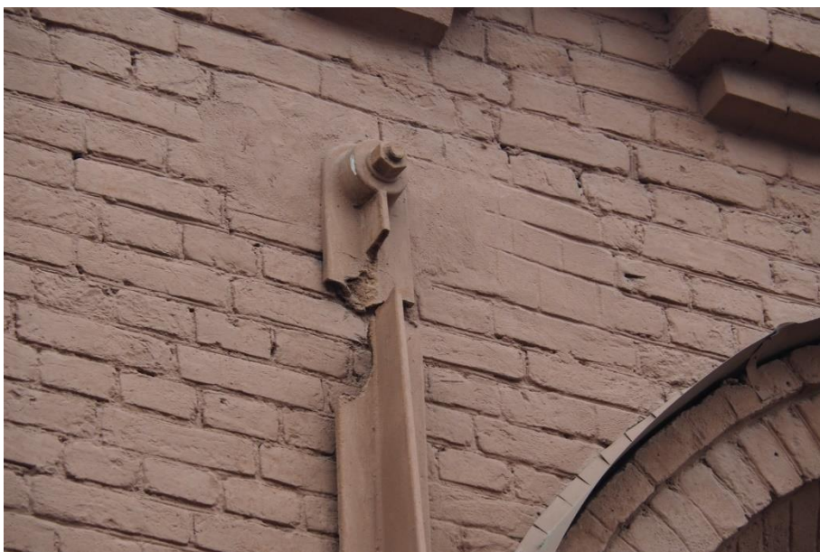
30. «Машинное отделение №3 с мастерскими и котельной и кладовые» в составе ансамбля «Комплекс главной станции Санкт-Петербургских городских водопроводов», ул. Шпалерная, д. 56, лит. АК. Западный фасад. Фрагмент. Фото 08.08.2022г.
