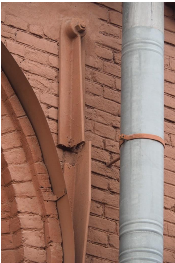
28. «Машинное отделение №3 с мастерскими и котельной и кладовые» в составе ансамбля «Комплекс главной станции Санкт-Петербургских городских водопроводов», ул. Шпалерная, д. 56, лит. АК. Западный фасад. Фрагмент. Фото 08.08.2022г.
