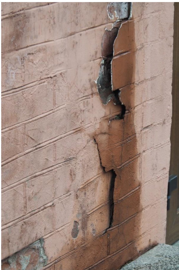
38. «Машинное отделение №3 с мастерскими и котельной и кладовые» в составе ансамбля «Комплекс главной станции Санкт-Петербургских городских водопроводов», ул. Шпалерная, д. 56, лит. АК. Западный фасад. Фрагмент. Фото 08.08.2022г.
