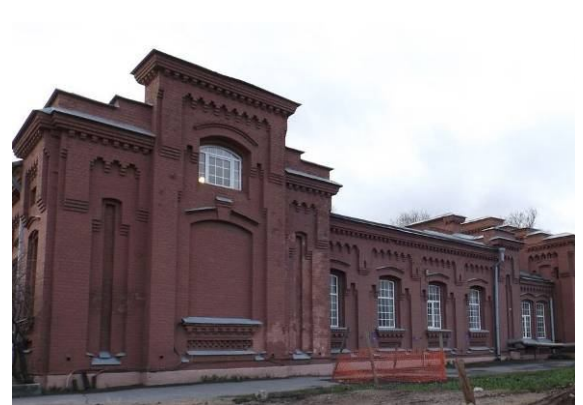
Северный фасад северо-восточного корпуса
