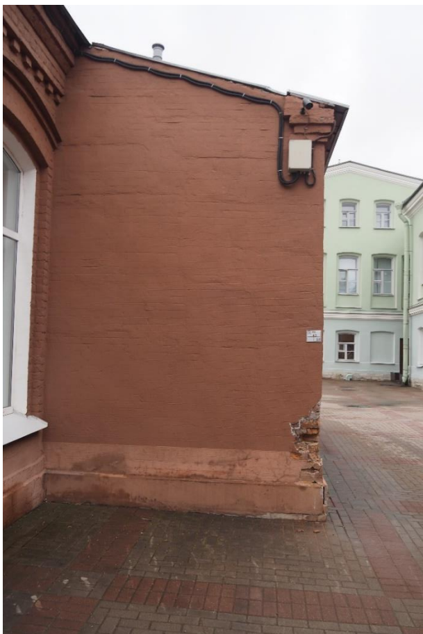
39. «Машинное отделение №3 с мастерскими и котельной и кладовые» в составе ансамбля «Комплекс главной станции Санкт-Петербургских городских водопроводов», ул. Шпалерная, д. 56, лит. АК. Западный фасад. Фрагмент. Фото 08.08.2022г.
