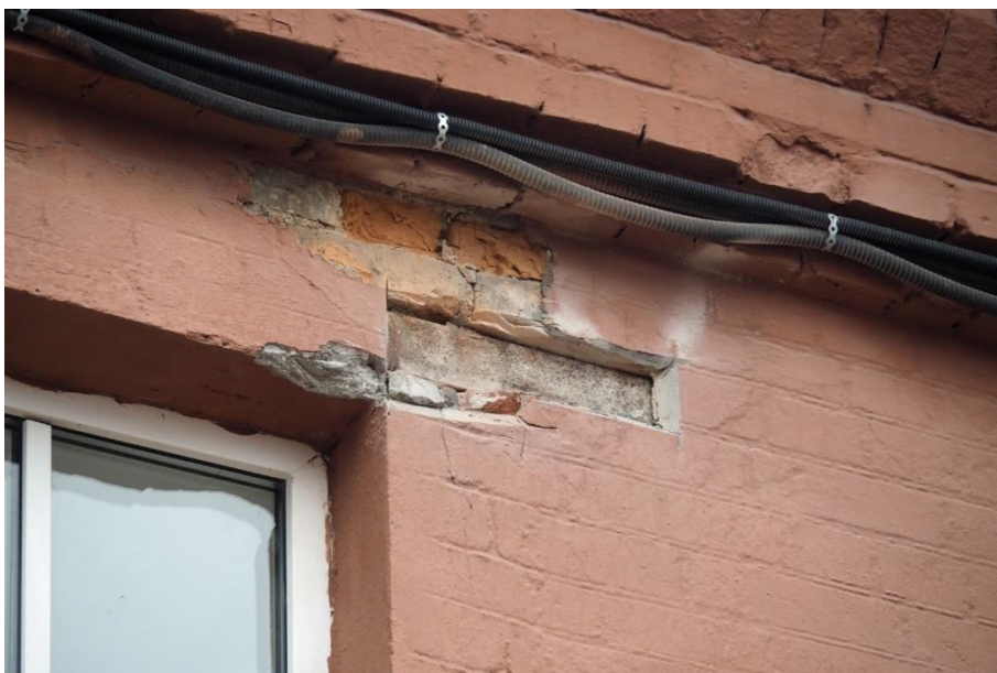
33. «Машинное отделение №3 с мастерскими и котельной и кладовые» в составе ансамбля «Комплекс главной станции Санкт-Петербургских городских водопроводов», ул. Шпалерная, д. 56, лит. АК. Западный фасад. Фрагмент. Фото 08.08.2022г.
