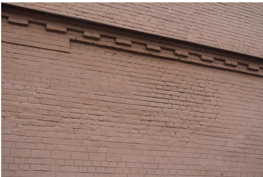
22. «Машинное отделение №3 с мастерскими и котельной и кладовые» в составе ансамбля «Комплекс главной станции Санкт-Петербургских городских водопроводов», ул. Шпалерная, д. 56, лит. АК. Северный фасад. Фрагмент. Фото 08.08.2022г.
