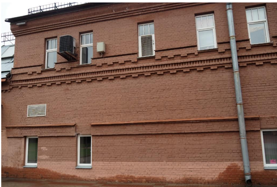
13. «Машинное отделение №3 с мастерскими и котельной и кладовые» в составе ансамбля «Комплекс главной станции Санкт-Петербургских городских водопроводов», ул. Шпалерная, д. 56, лит. АК. Восточный фасад. Фрагмент. Фото 08.08.2022г.
