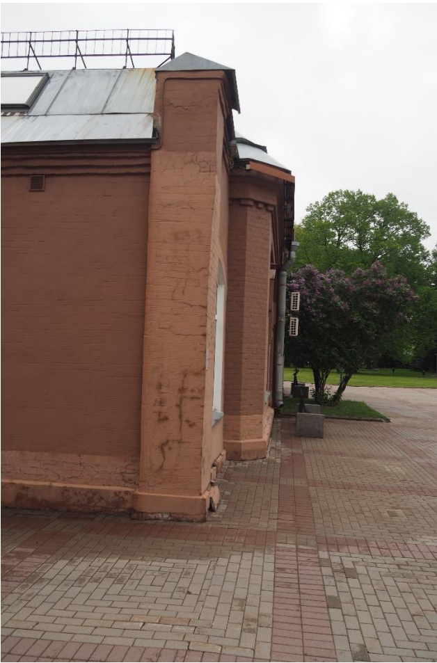
5. «Машинное отделение №3 с мастерскими и котельной и кладовые» в составе ансамбля «Комплекс главной станции Санкт-Петербургских городских водопроводов», ул. Шпалерная, д. 56, лит. АК. Южный фасад. Общий вид. Фото 08.08.2022г.
