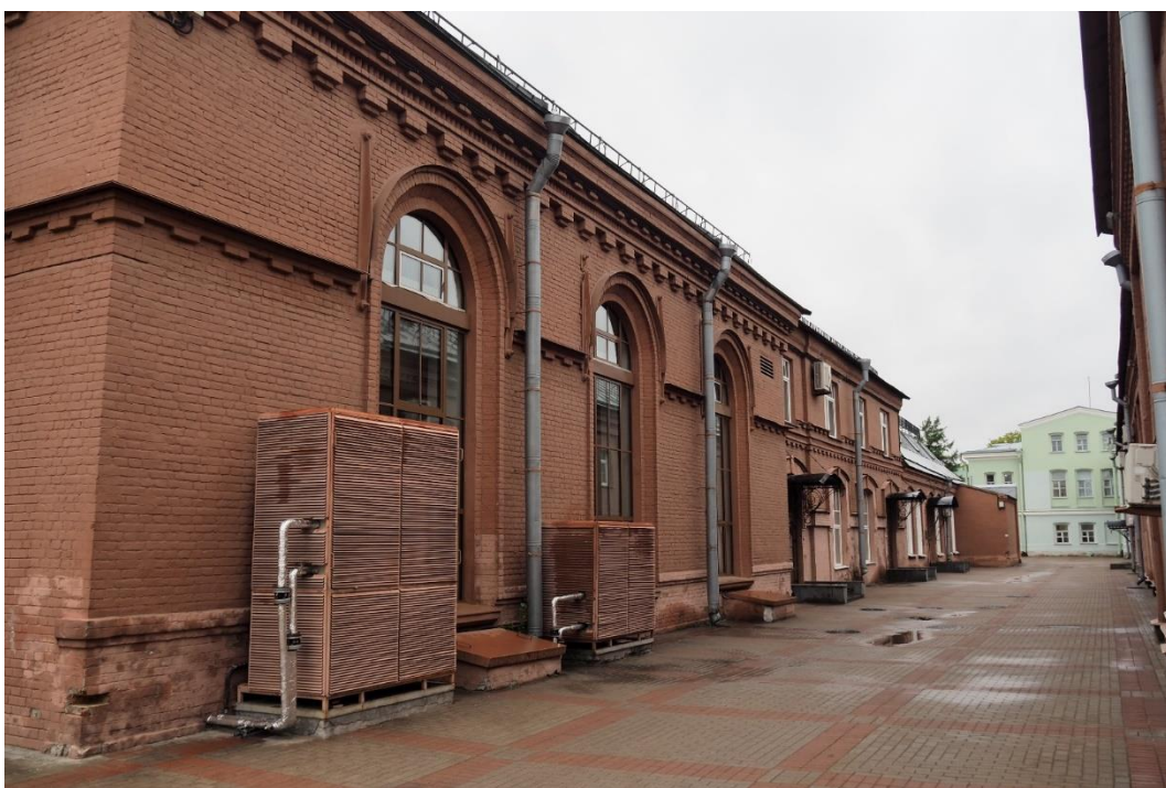
4. «Машинное отделение №3 с мастерскими и котельной и кладовые» в составе ансамбля «Комплекс главной станции Санкт-Петербургских городских водопроводов», ул. Шпалерная, д. 56, лит. АК. Западный фасад. Общий вид. Фото 08.08.2022г.
