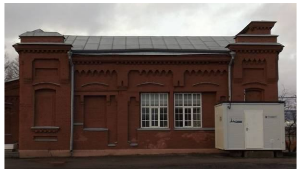
Восточный фасад северо-восточного корпуса
