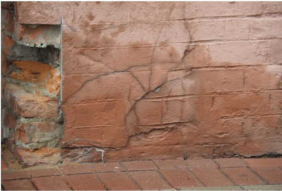
17. «Машинное отделение №3 с мастерскими и котельной и кладовые» в составе ансамбля «Комплекс главной станции Санкт-Петербургских городских водопроводов», ул. Шпалерная, д. 56, лит. АК. Восточный фасад. Фрагмент. Фото 08.08.2022г.
