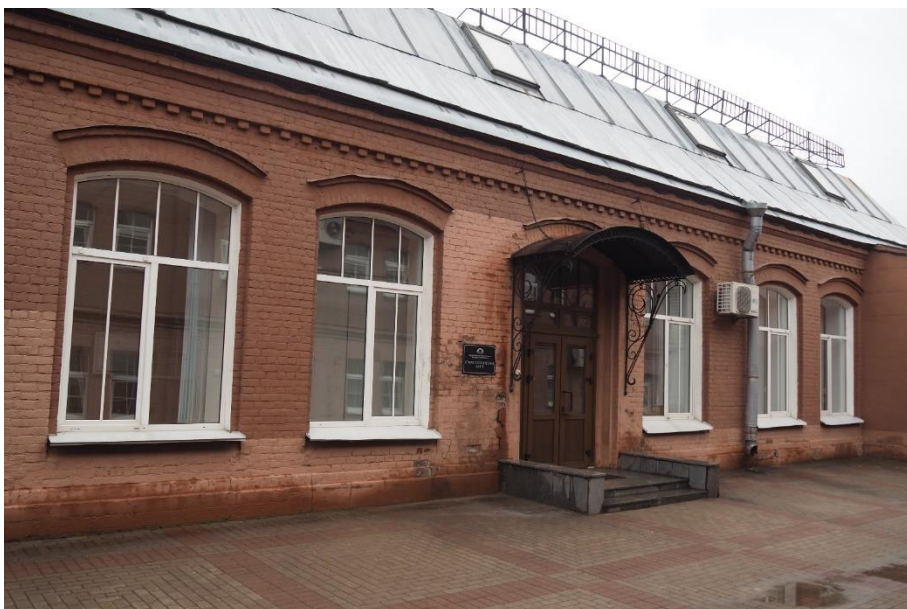
36. «Машинное отделение №3 с мастерскими и котельной и кладовые» в составе ансамбля «Комплекс главной станции Санкт-Петербургских городских водопроводов», ул. Шпалерная, д. 56, лит. АК. Западный фасад. Фрагмент. Фото 08.08.2022г.
