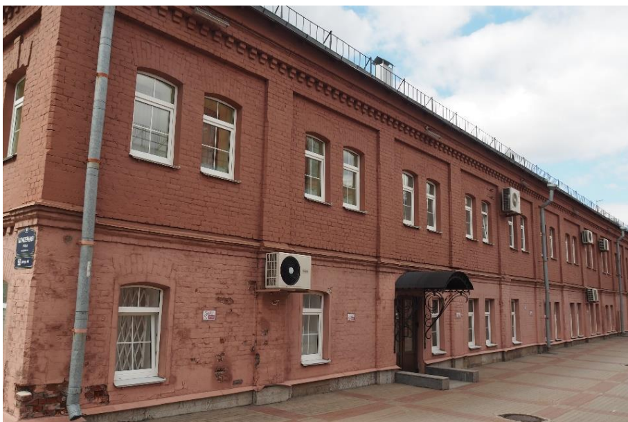
8. «Машинное отделение №3 с мастерскими и котельной и кладовые» в составе ансамбля «Комплекс главной станции Санкт-Петербургских городских водопроводов», ул. Шпалерная, д. 56, лит. АИ. Восточный фасад. Фрагмент. Фото 08.08.2022г.
