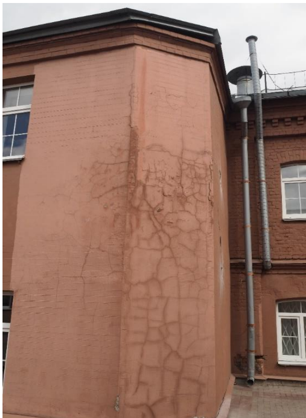
29. «Машинное отделение №3 с мастерскими и котельной и кладовые» в составе ансамбля «Комплекс главной станции Санкт-Петербургских городских водопроводов», ул. Шпалерная, д. 56, лит. АИ. Западный фасад. Фрагмент. Фото 08.08.2022г.
