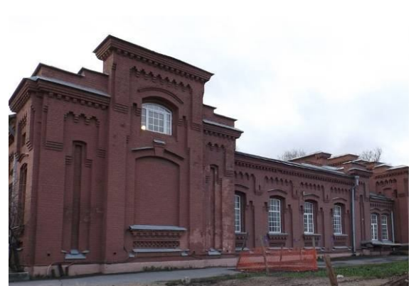
Северный фасад северо-восточного корпуса
