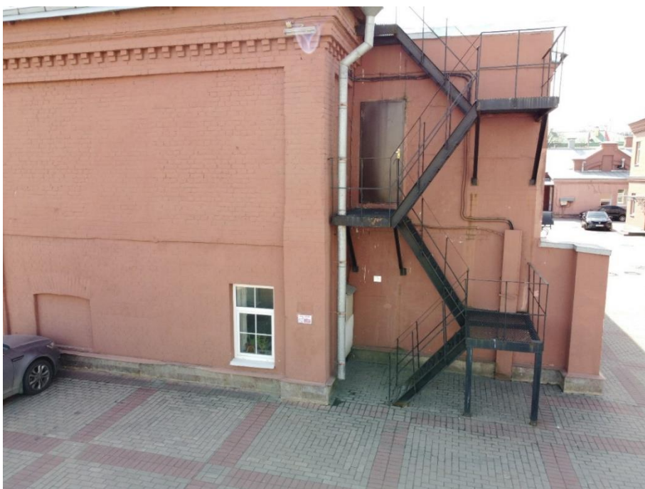
16. «Машинное отделение №3 с мастерскими и котельной и кладовые» в составе ансамбля «Комплекс главной станции Санкт-Петербургских городских водопроводов», ул. Шпалерная, д. 56, лит. АИ. Северный фасад. Общий вид. Фото 08.08.2022г.
