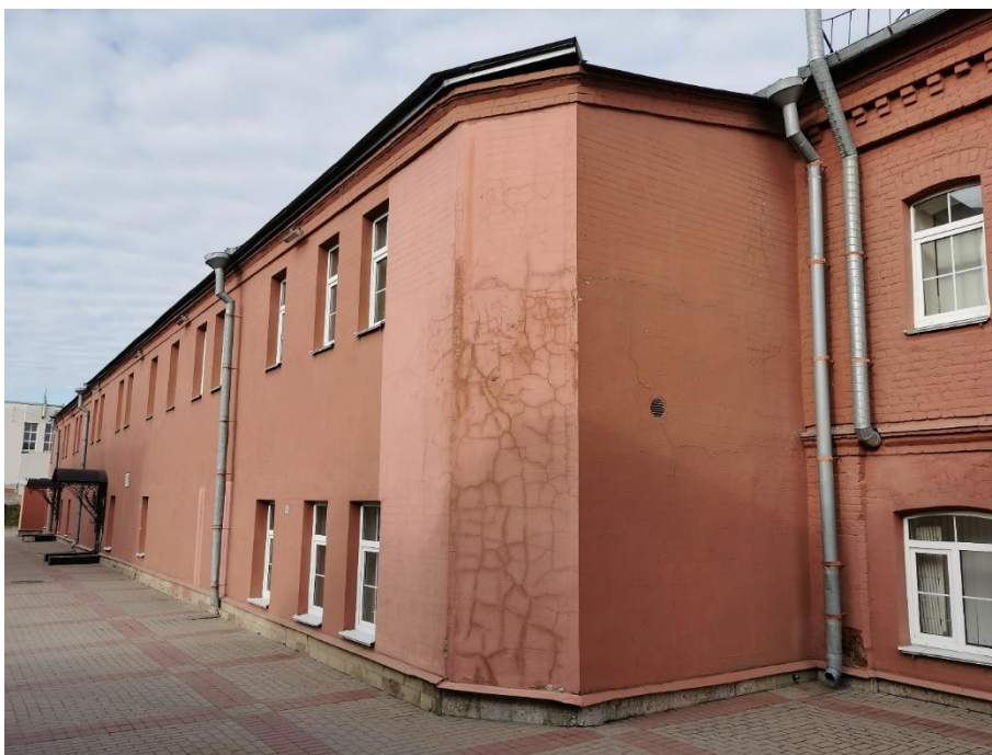
28. «Машинное отделение №3 с мастерскими и котельной и кладовые» в составе ансамбля «Комплекс главной станции Санкт-Петербургских городских водопроводов», ул. Шпалерная, д. 56, лит. АИ. Западный фасад. Фрагмент. Фото 08.08.2022г.
