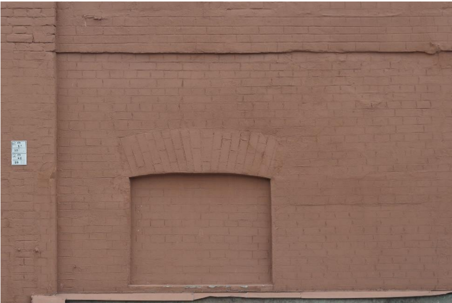
18. «Машинное отделение №3 с мастерскими и котельной и кладовые» в составе ансамбля «Комплекс главной станции Санкт-Петербургских городских водопроводов», ул. Шпалерная, д. 56, лит. АИ. Северный фасад. Фрагмент. Фото 08.08.2022г.
