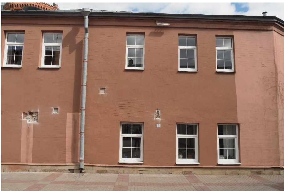
22. «Машинное отделение №3 с мастерскими и котельной и кладовые» в составе ансамбля «Комплекс главной станции Санкт-Петербургских городских водопроводов», ул. Шпалерная, д. 56, лит. АИ. Западный фасад. Фрагмент. Фото 08.08.2022г.
