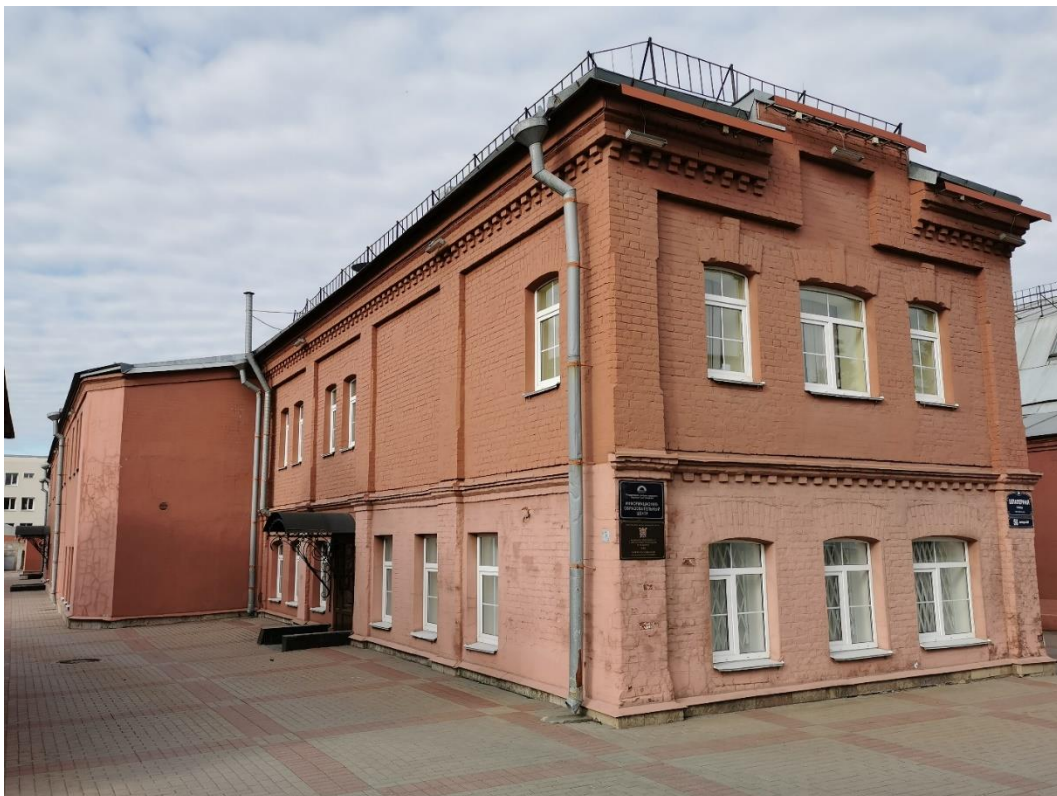
1. «Машинное отделение №3 с мастерскими и котельной и кладовые» в составе ансамбля «Комплекс главной станции Санкт-Петербургских городских водопроводов», ул. Шпалерная, д. 56, лит. АИ. Общий вид с юго-запада. Фото 08.08.2022г.
