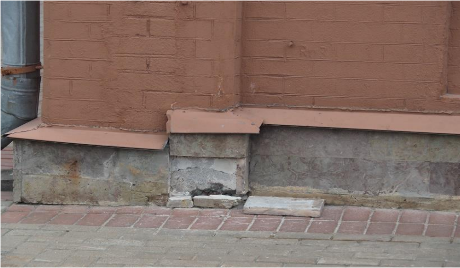
17. «Машинное отделение №3 с мастерскими и котельной и кладовые» в составе ансамбля «Комплекс главной станции Санкт-Петербургских городских водопроводов», ул. Шпалерная, д. 56, лит. АИ. Северный фасад. Фрагмент. Фото 08.08.2022г.
