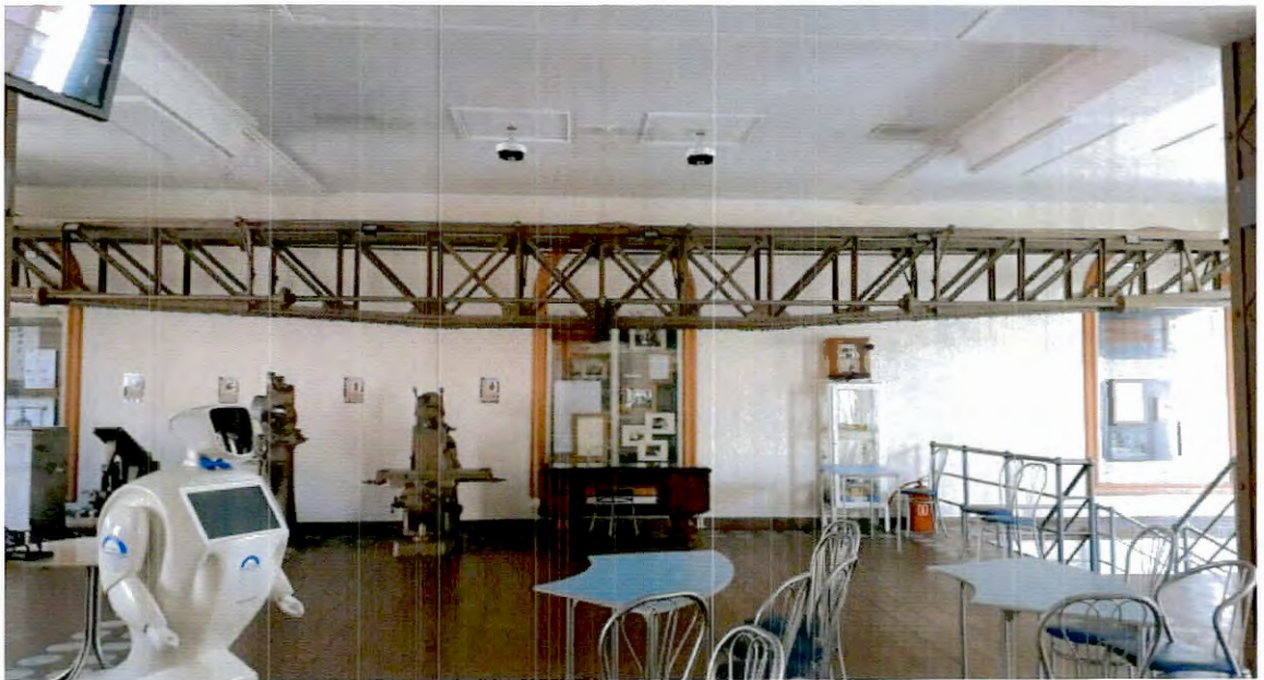
11. Пилоны и двутавровые балки машинного зала
