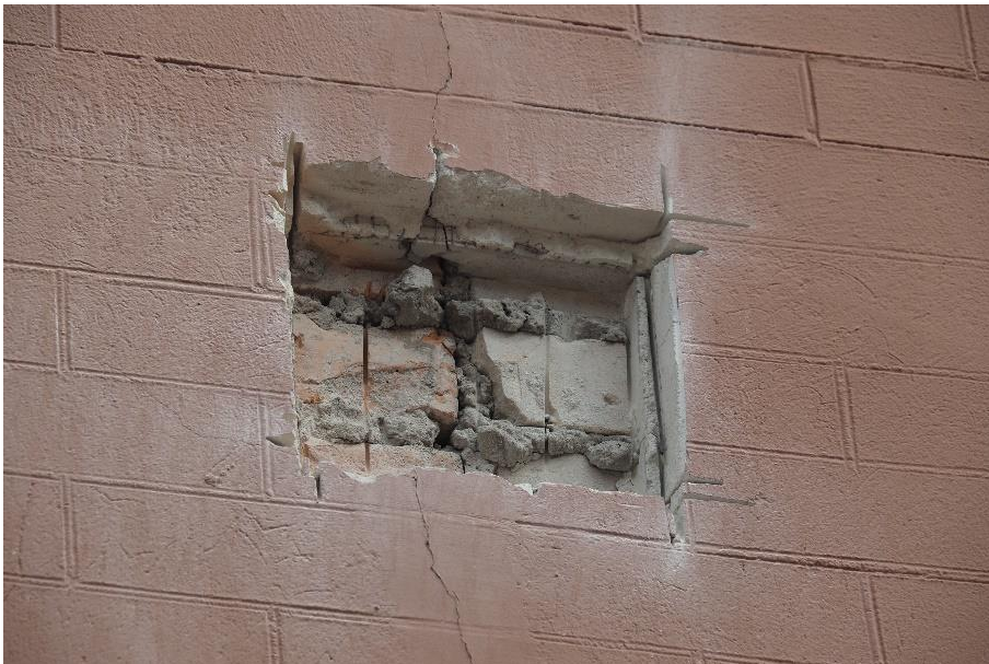
23. «Машинное отделение №3 с мастерскими и котельной и кладовые» в составе ансамбля «Комплекс главной станции Санкт-Петербургских городских водопроводов», ул. Шпалерная, д. 56, лит. АИ. Западный фасад. Фрагмент. Фото 08.08.2022г.
