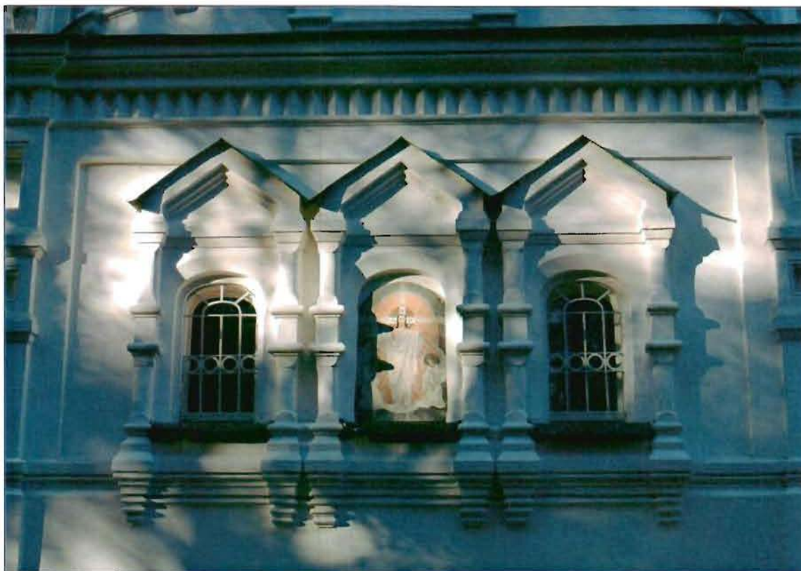
4. Восточный фасад. Фрагмент.
