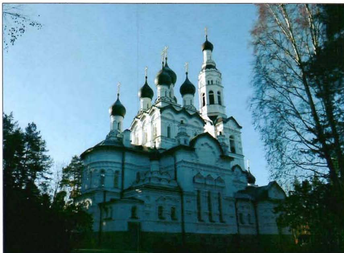
3. Общий вид с северо-востока.
