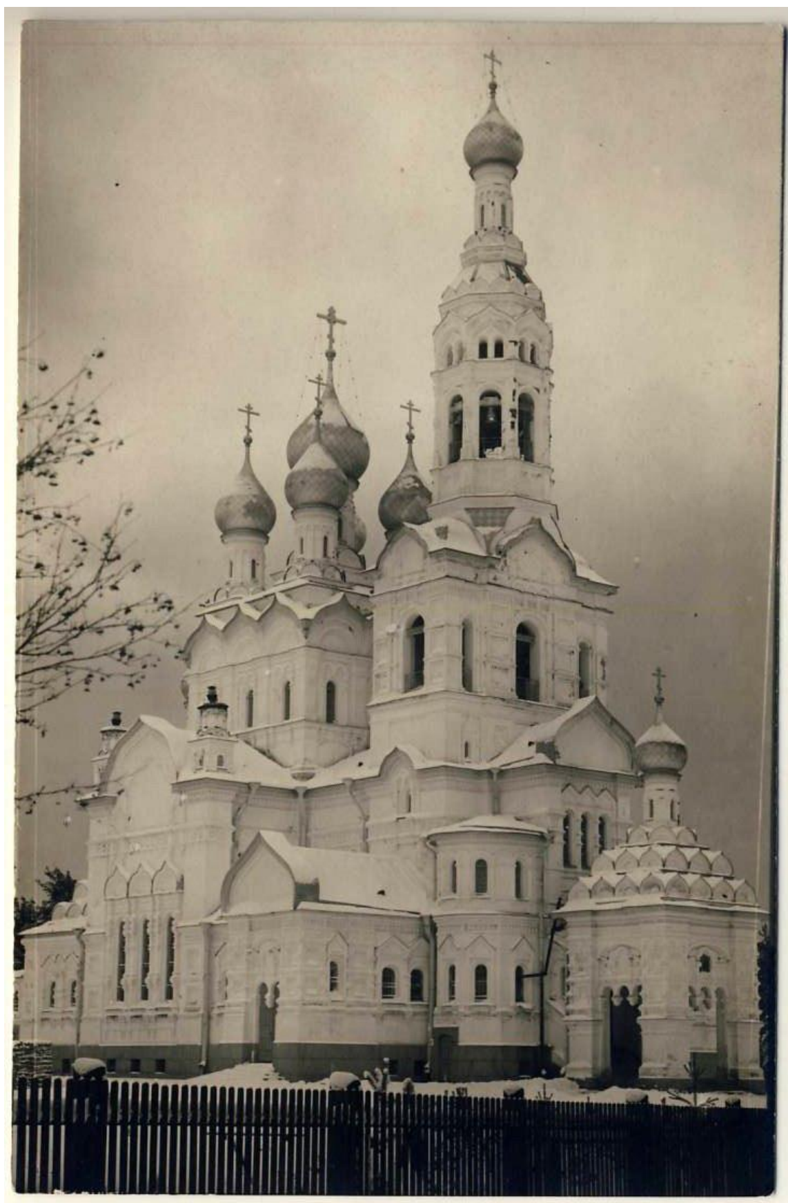
Илл. 20. Териоки. Церковь Казанской иконы Божьей Матери. 1915-1930 гг. Направление съемки: юго-восток// https://pastvu.com/p/960098
