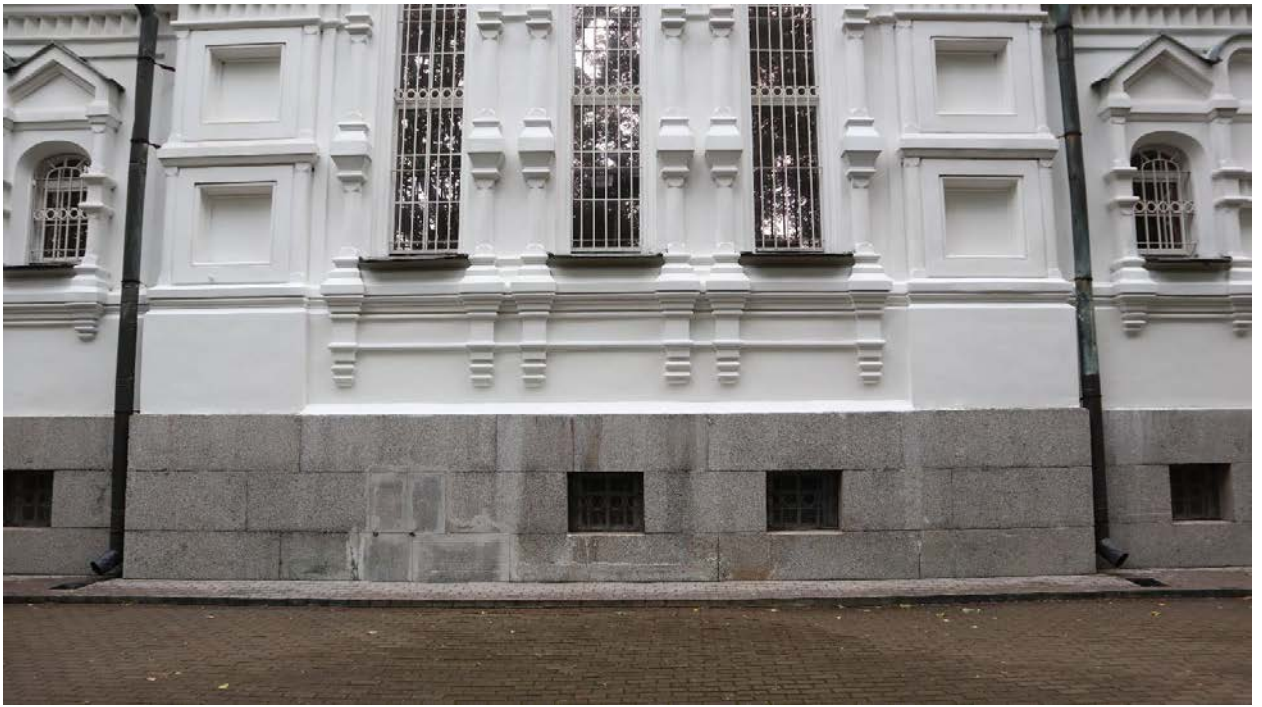
Фото 13. Фрагмент южного фасада – отделка цоколя.
