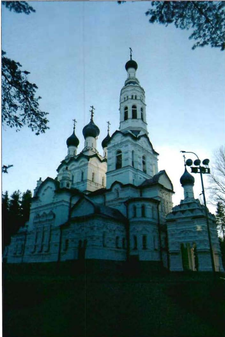
1. Общий вид с северо-запада.
