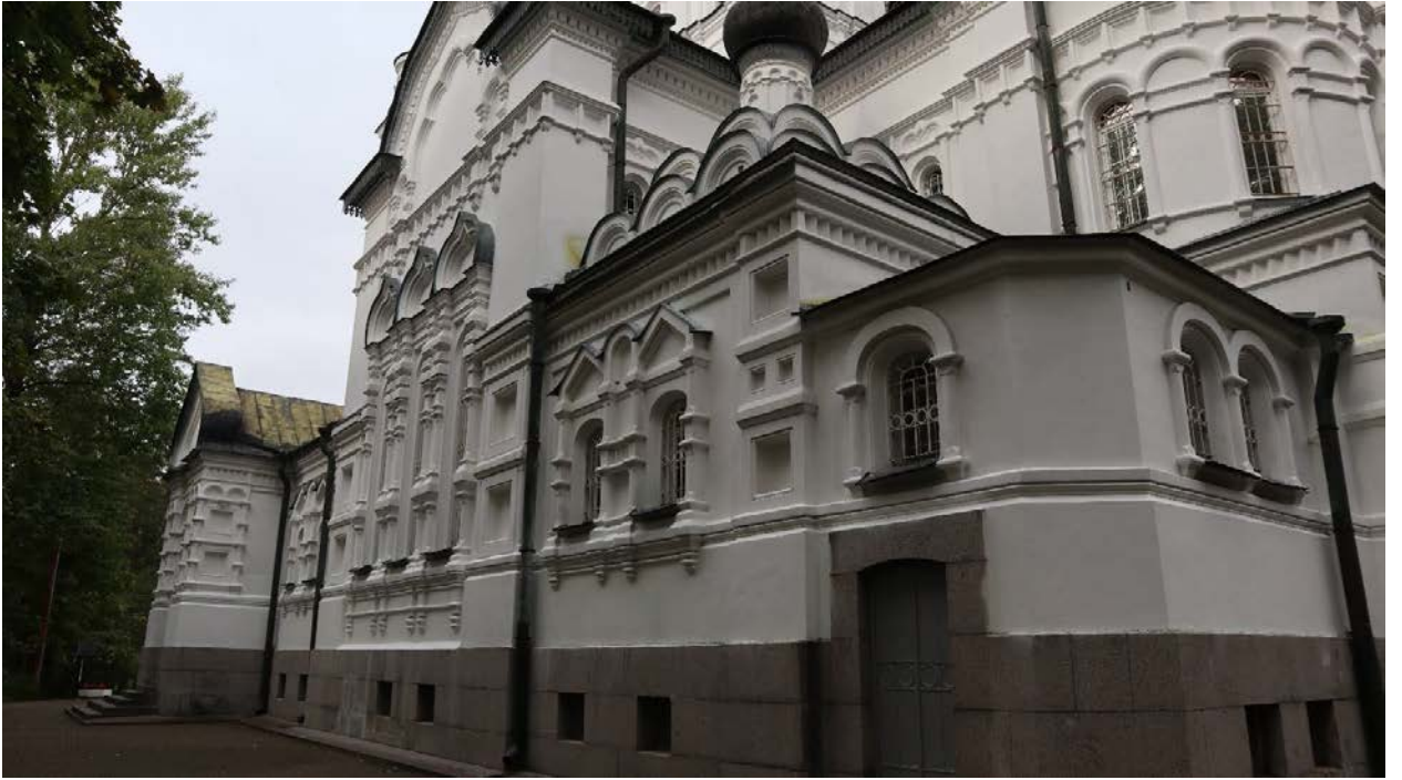
Фото 12. Южный фасад здания.
