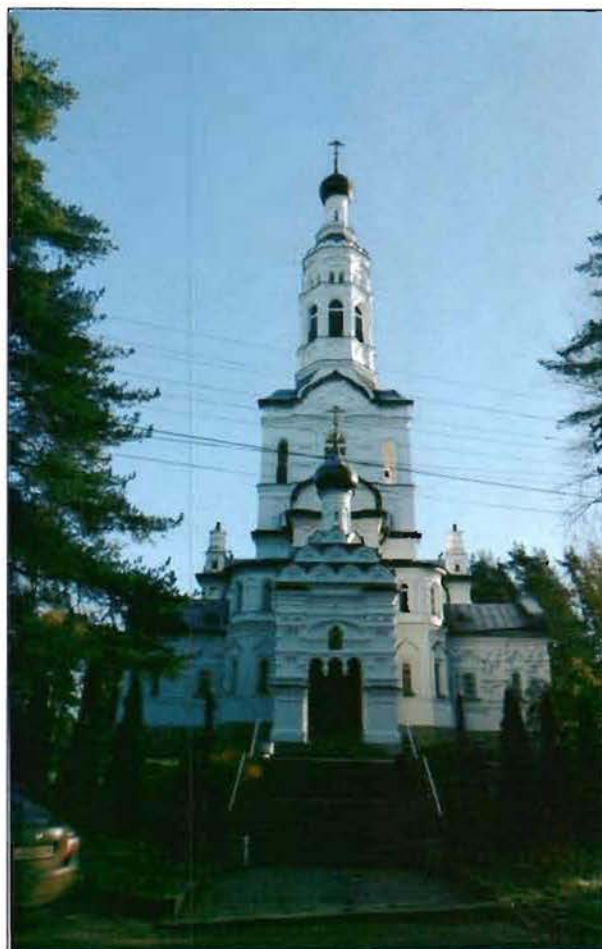
2. Западный фасад. Общий вид.
