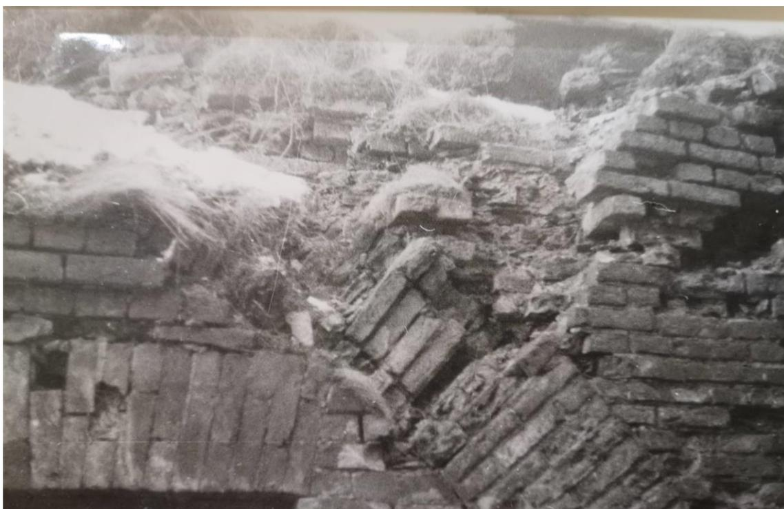
Илл. 58. Состояние кирпичной кладки лицевой поверхности валганговой (южной) стены, ось 21. // Научно-проектная документация «Северная оборонительная стена в г. Кронштадте. Участок №5. Северный фасад». Том 2. Обмерные чертежи. Фотофиксация. ЦНТТМ «Эра» Смольнинского РК ВЛКСМ. Ленинград. 1989 г. Архив КГИОП, п.615-5-1 пр-2.
