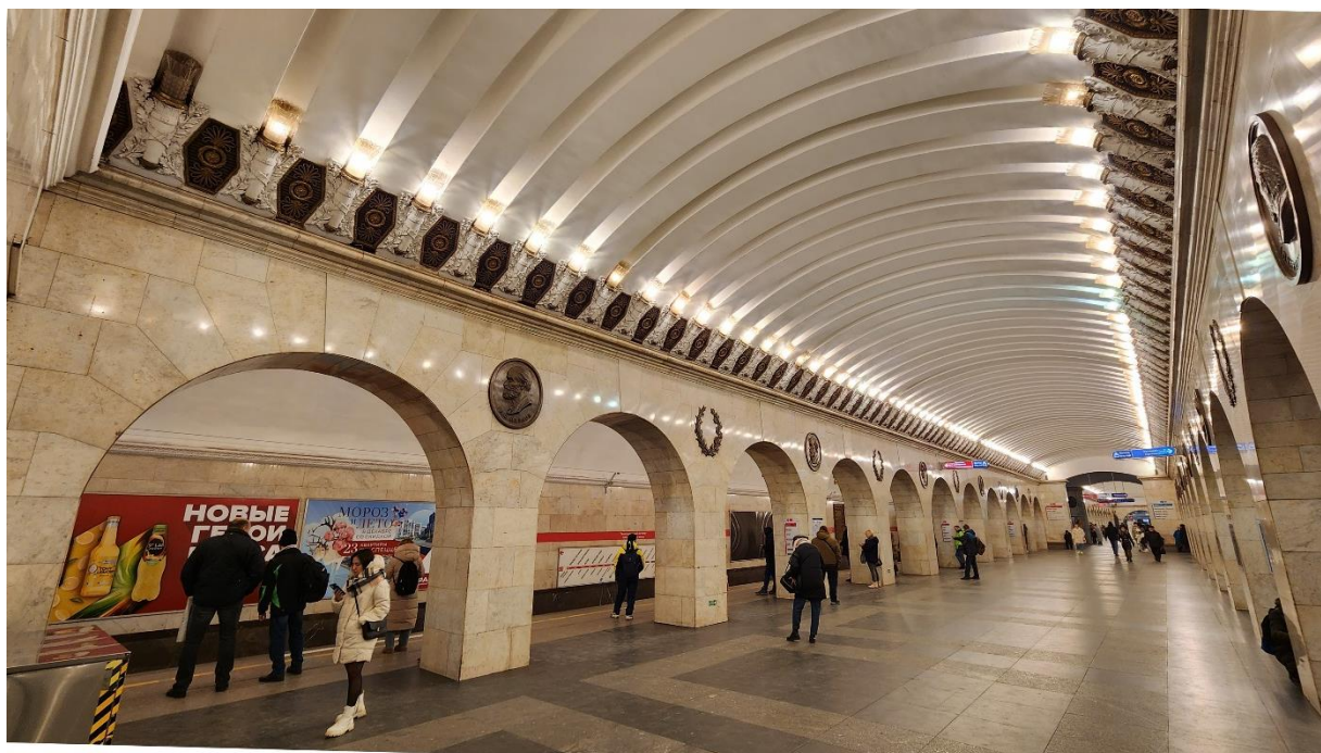
Фото 29. Перронный зал. Вид в сторону эскалаторов.
