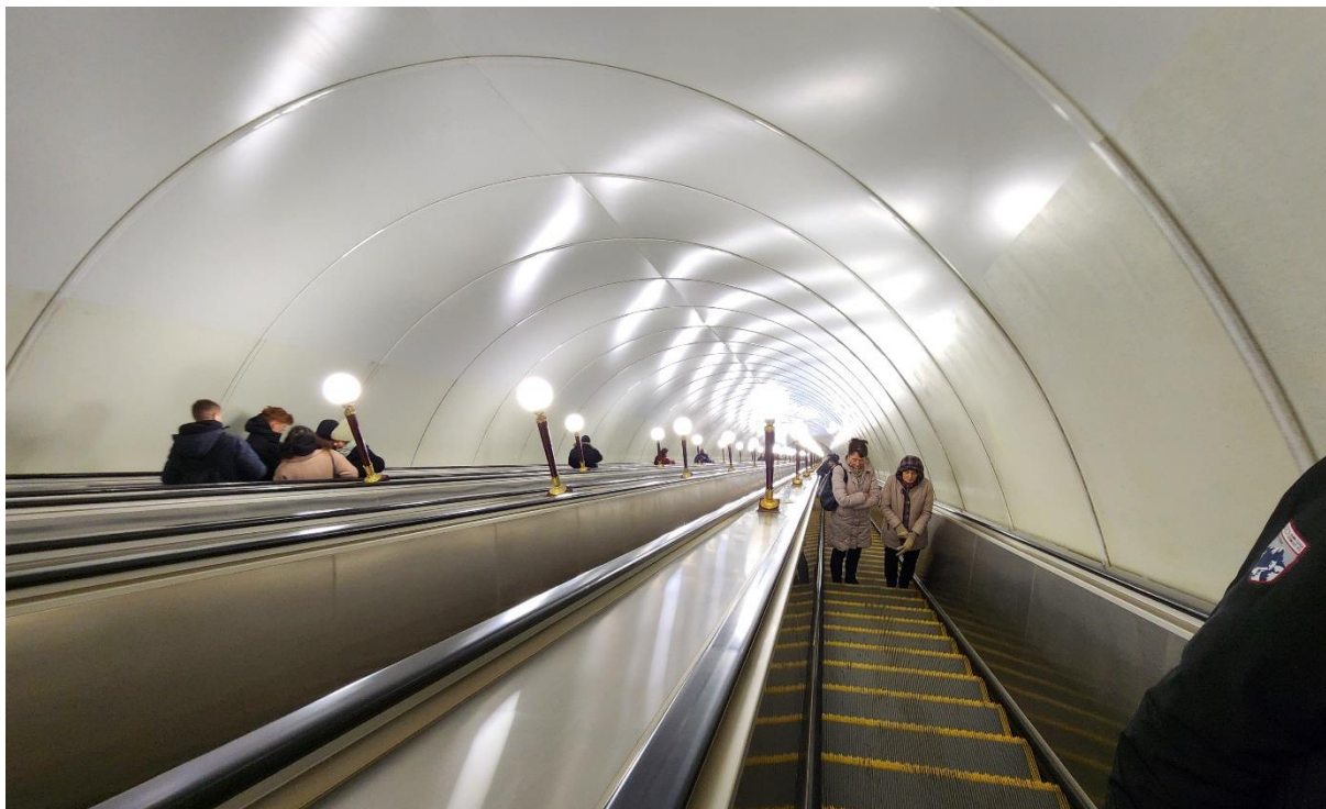
Фото 19. Помещение № 3. Наклонный вход.
