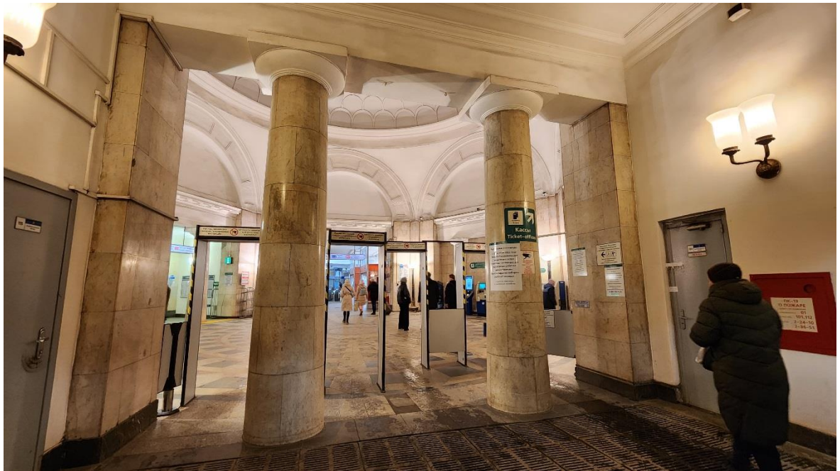
Фото 7. Колонны. Вид в сторону кассового зала.
