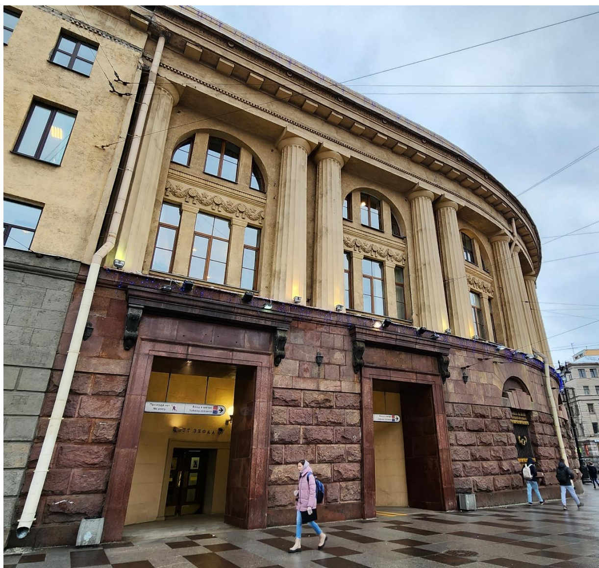
Фото 2. Фасад со стороны Загородного пр.
