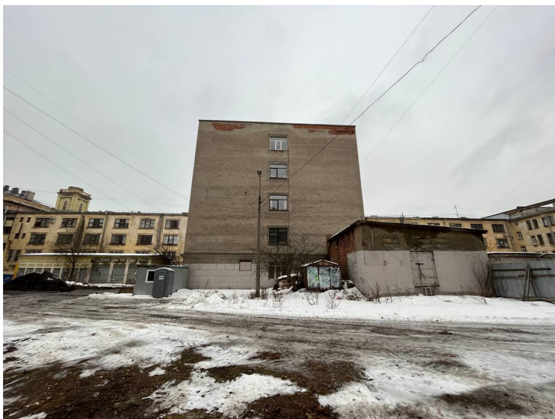
Фото 13. Участок производства работ.
