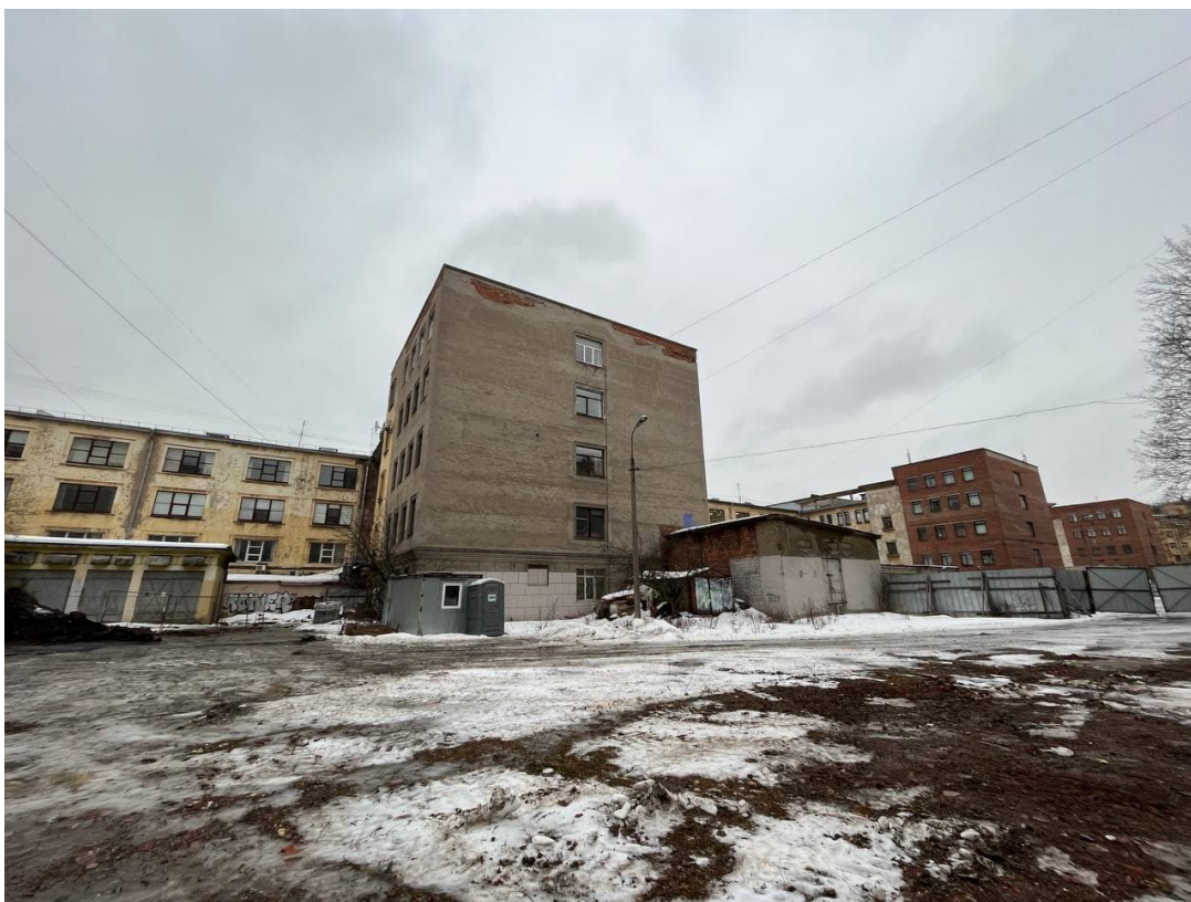
Фото 14. Участок производства работ.
