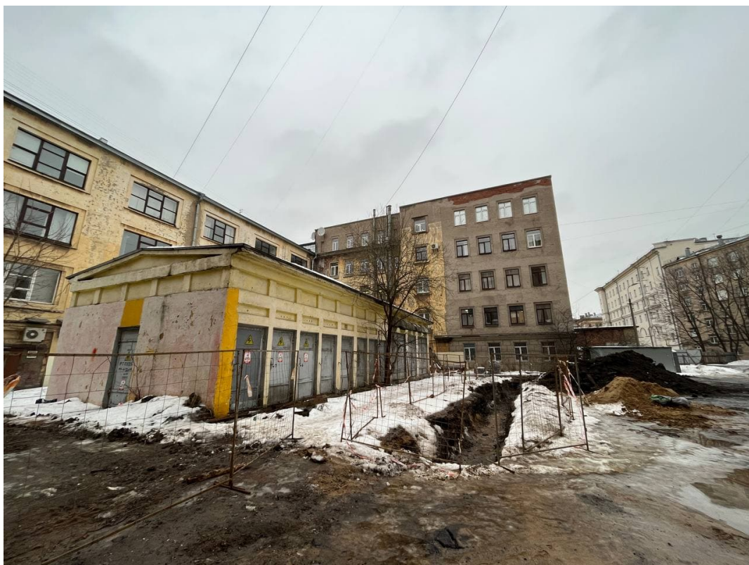
Фото 16. Участок производства работ.
