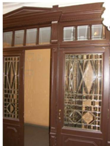
заполнение дверного проема верхней лестничной площадки – материал (дерево), конструкция (двери двустворчатые), оформление (профилированные филенки разной конфигурации, по три на каждом полотне);
