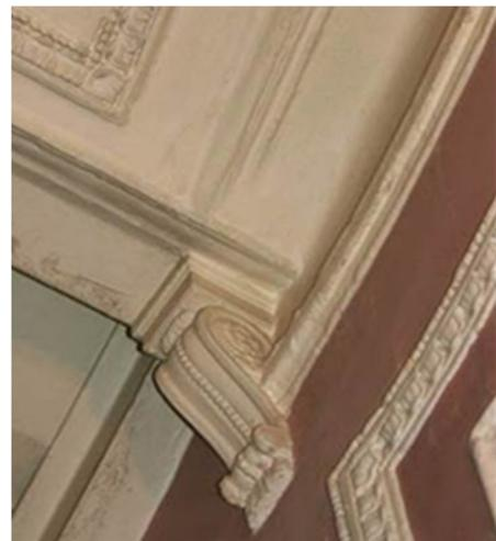
отделка стен лестницы (зеркала с филенками с порезкой), декор карниза в виде кессонов, лепные консоли;
