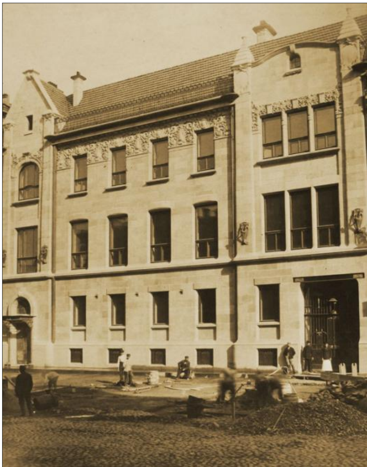
Илл. 15. Окончание строительства. Фотография. 1908 – 1909 гг. (?). Автор съемки: неизвестен.
