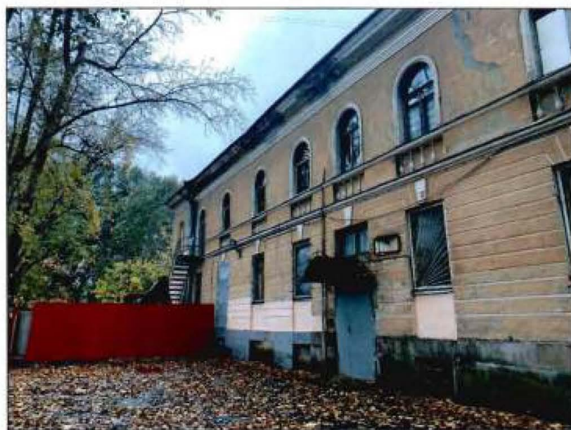
4. Южный фасад объекта культурного наследия.
