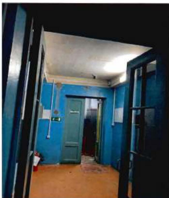
8. Помещения объекта культурного наследия.
