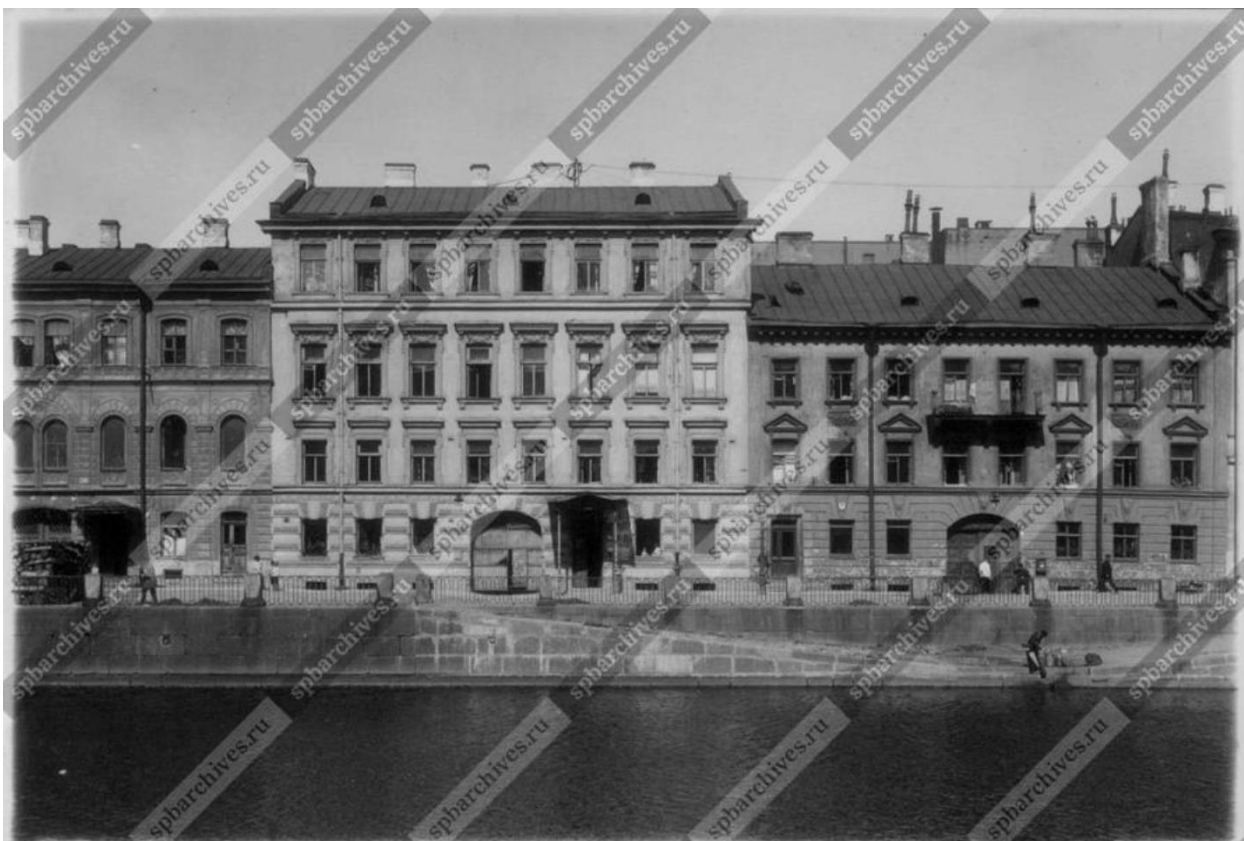
Илл. 11. Вид на дома № 43-№ 47 по набережной реки Фонтанки. Июль 1926 г. (источник: ЦГАКФФД СПб. Фотодокумент Гр 65884).
