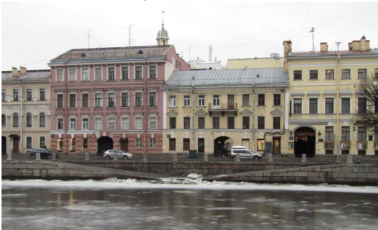
Фото 1. Вид на спуск № 5 объекта культурного наследия федерального значения «Набережные со спусками» на участке Аничков мост - мост Ломоносова», литера А с правого берега реки Фонтанки.
