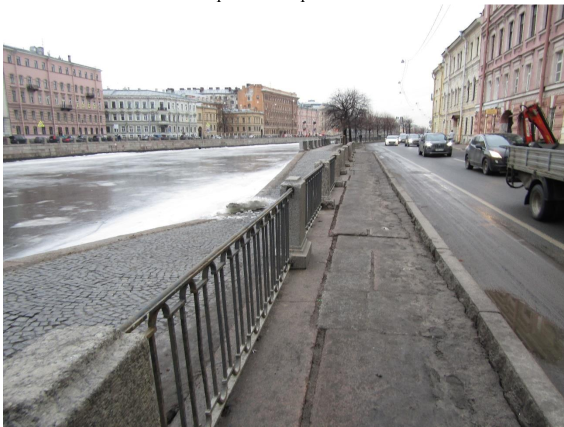
Фото 10. Вид на тротуар из гранитных плит в обход спуска № 5 объекта культурного наследия федерального значения «Набережные со спусками» на участке Аничков мост - мост Ломоносова», литера А с северо-востока.
