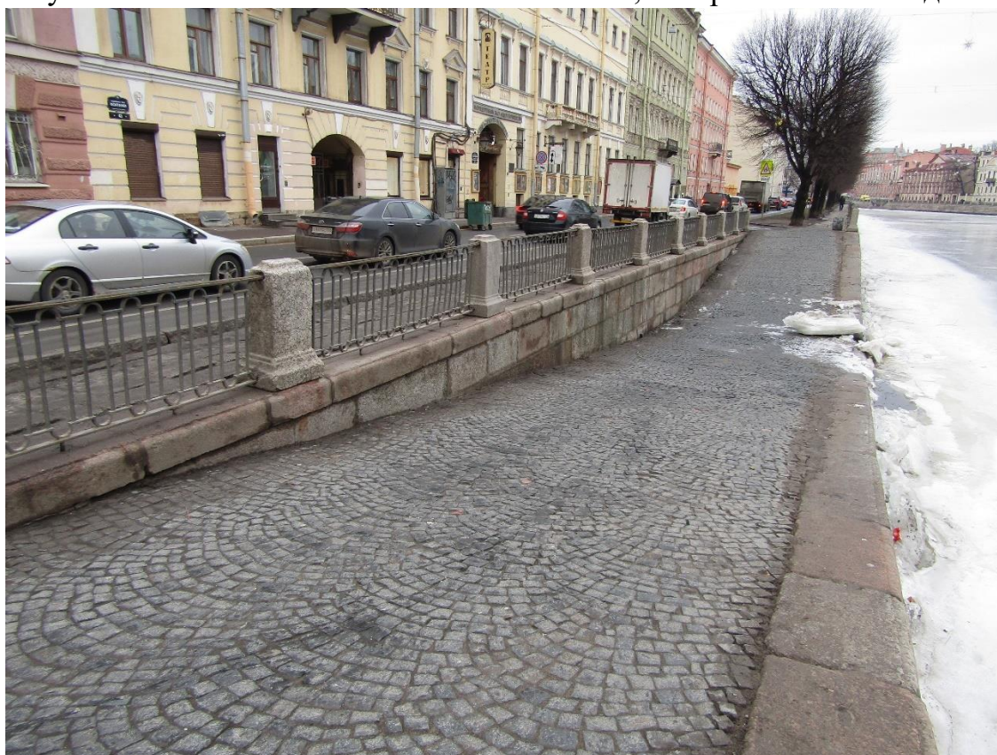
Фото 4. Вид на спуск № 5 объекта культурного наследия федерального значения «Набережные со спусками» на участке Аничков мост - мост Ломоносова), литера А с юго-запада.
