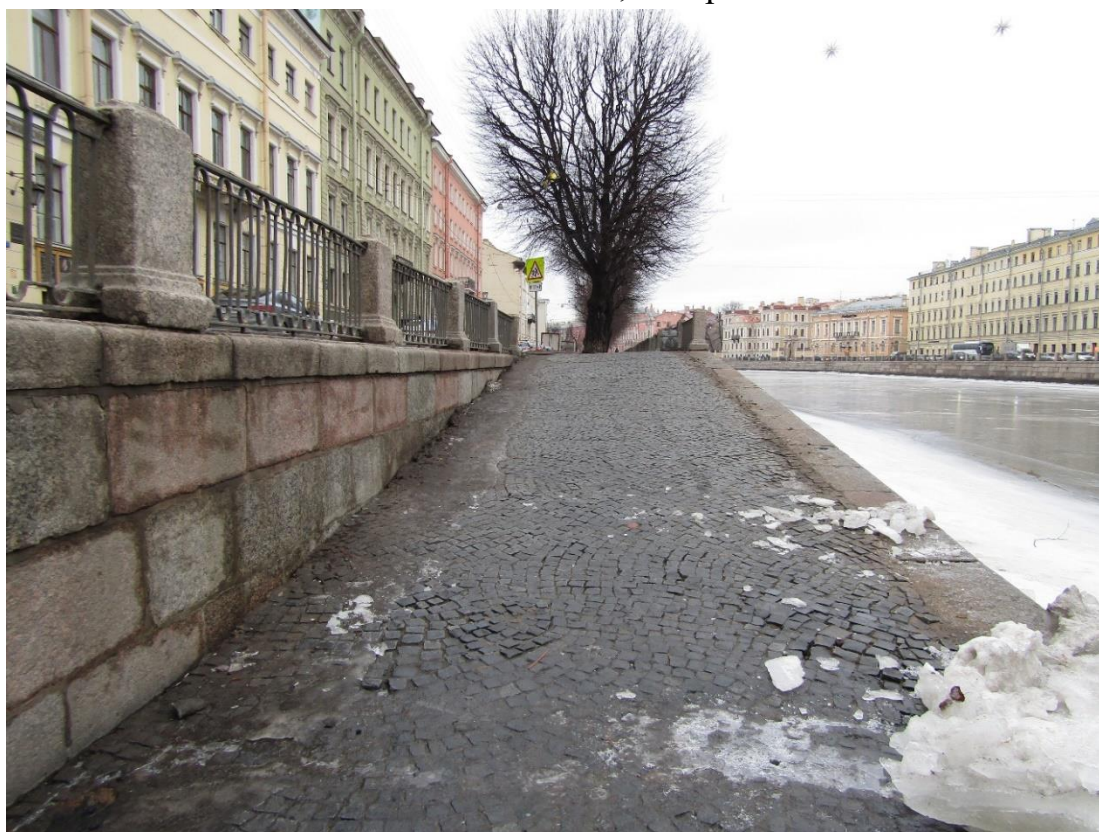
Фото 8. Вид на северо-восточный пандус спуска № 5 объекта культурного наследия федерального значения «Набережные со спусками» на участке Аничков мост - мост Ломоносова), литера А.
