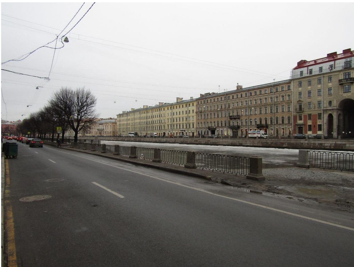
Фото 11. Вид на спуск № 5 объекта культурного наследия федерального значения «Набережные со спусками» на участке Аничков мост - мост Ломоносова», литера А с запада.
