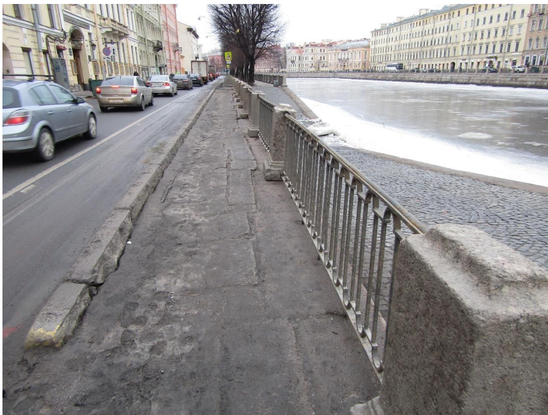
Фото 3. Вид на тротуар из гранитных плит в обход спуска № 5 объекта культурного наследия федерального значения «Набережные со спусками» на участке Аничков мост - мост Ломоносова), литера А с юго-запада.
