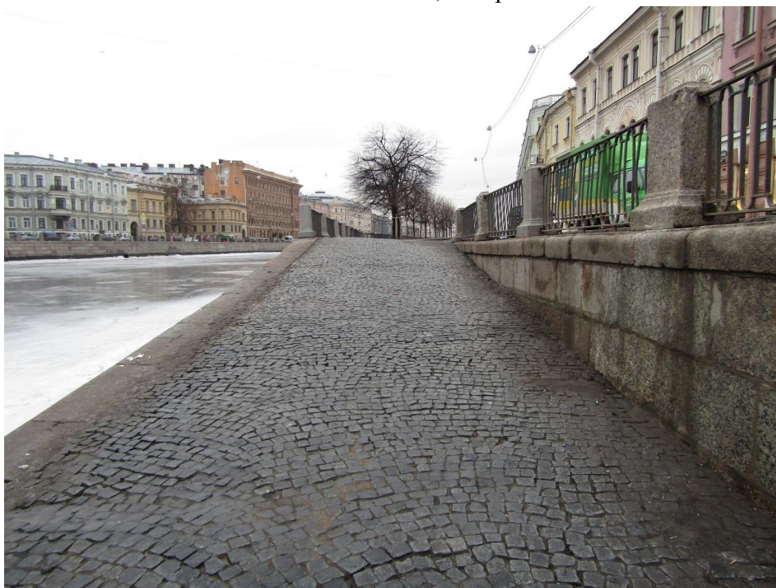
Фото 6. Вид на подпорную стенку спуска № 5 объекта культурного наследия федерального значения «Набережные со спусками» на участке Аничков мост - мост Ломоносова», литера А.
