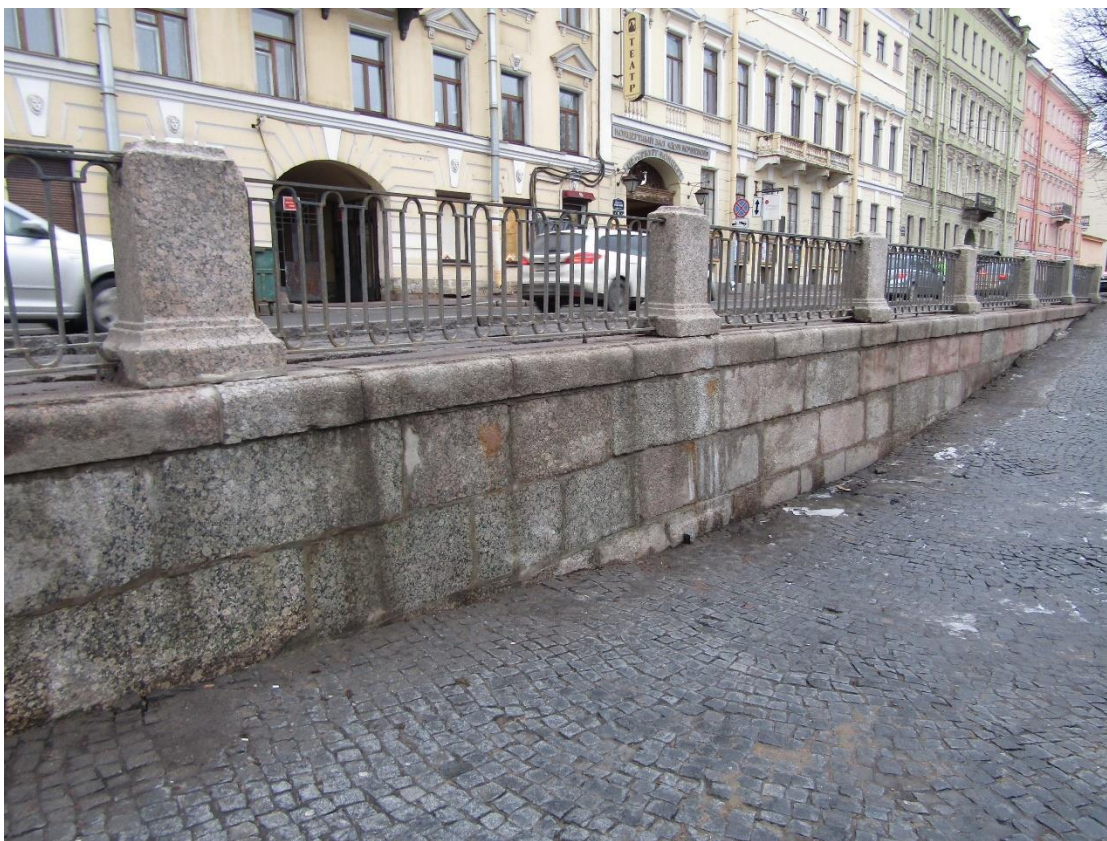
Фото 5. Вид на юго-западный пандус спуска № 5 объекта культурного наследия федерального значения «Набережные со спусками» на участке Аничков мост - мост Ломоносова», литера А.
