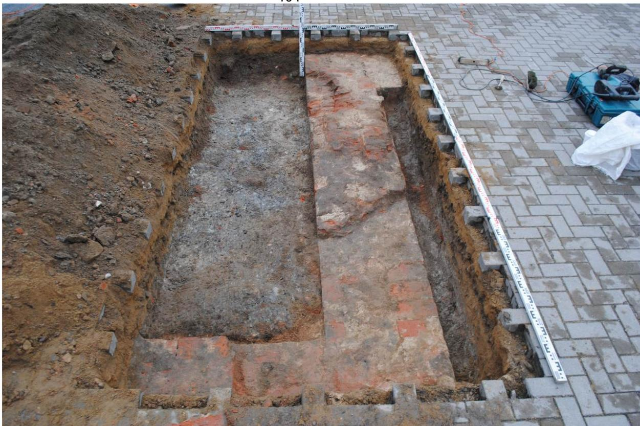
Рис. 41. Санкт-Петербург, Инструментальная улица, дом 3. Шурф 2. Фиксация по слою серой мешаной супеси со строительным мусором. Уровень выявления фундамента. Вид на юго-восток
