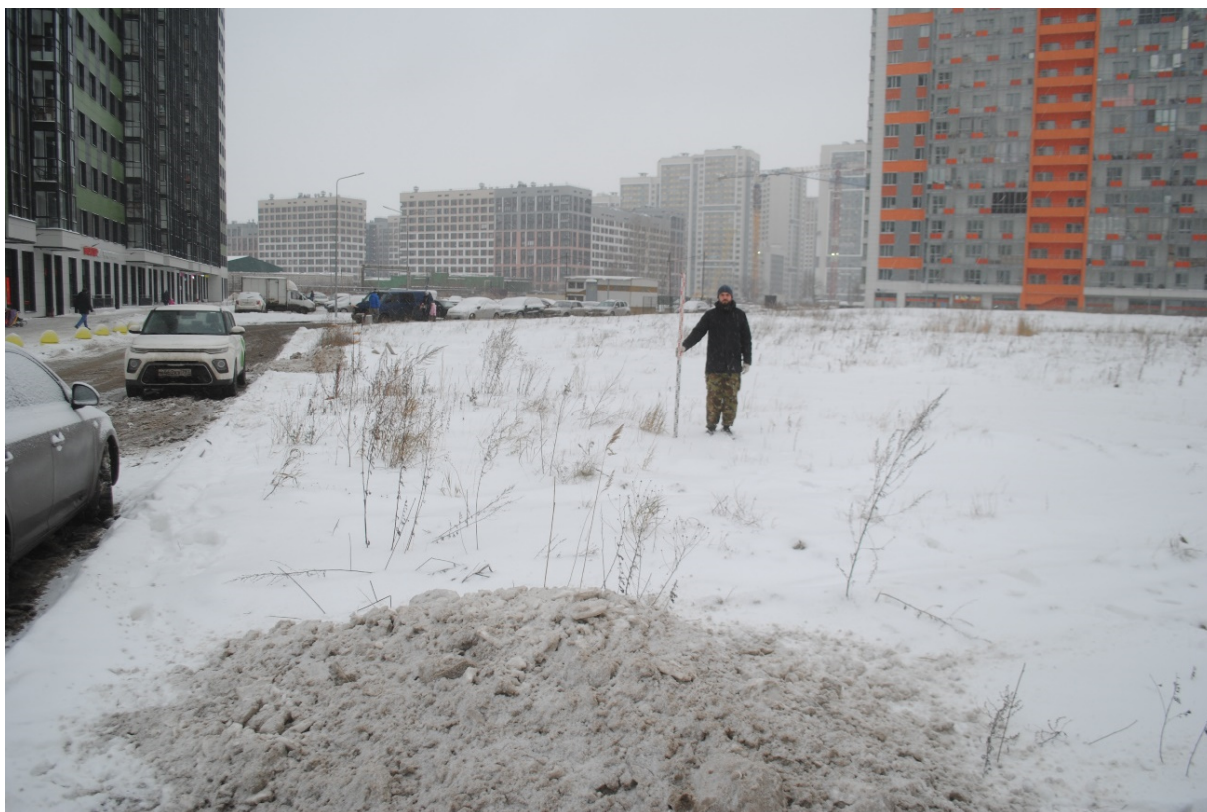
Рис. 11. Санкт-Петербург, Московское шоссе, участок 176, (юго-западнее пересечения с Дунайским проспектом) (кадастровый номер: 78:14:0007691:9436). Общий вид участка обследования. Точка съемки 1. Вид на юго-запад
