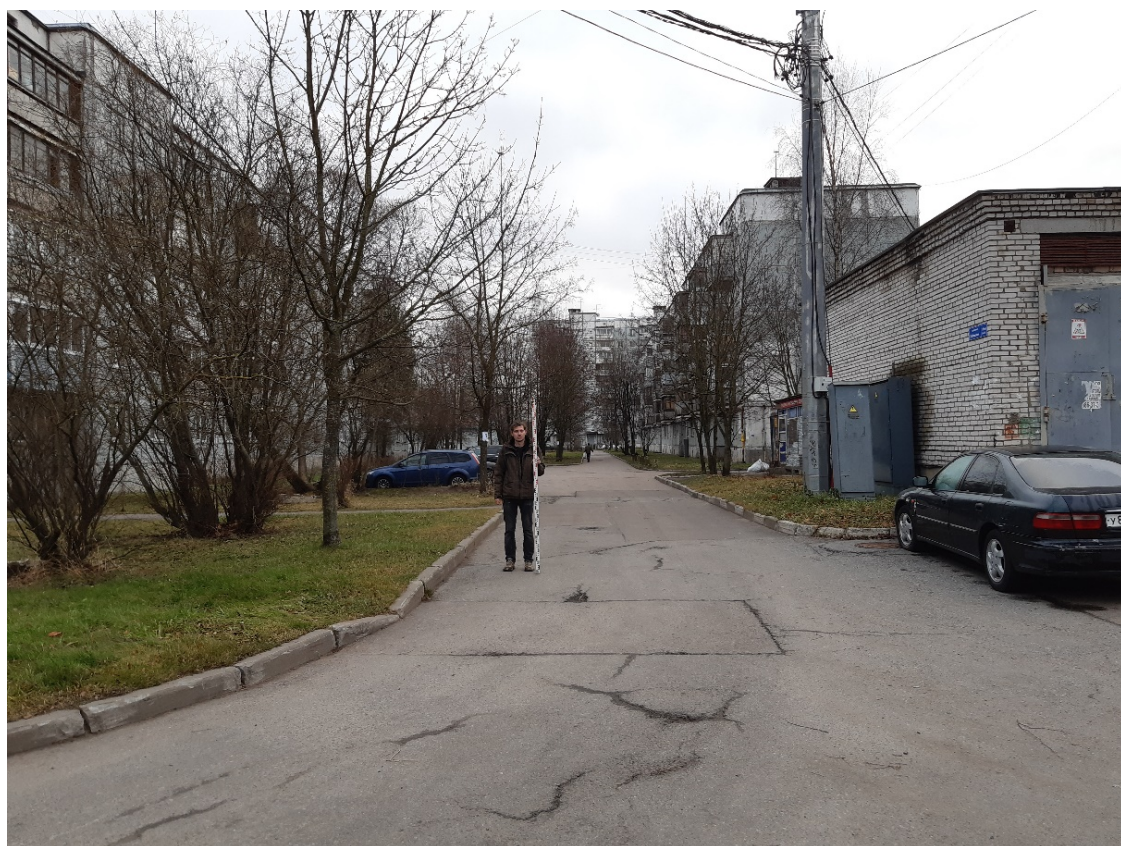
Рис. 15. Санкт-Петербург, квартал 38А, Рябовское шоссе (от ул. Окраинная до ул. Сосновая). Общий вид трассы обследования. Точка съемки 3. Вид на юго-восток.
