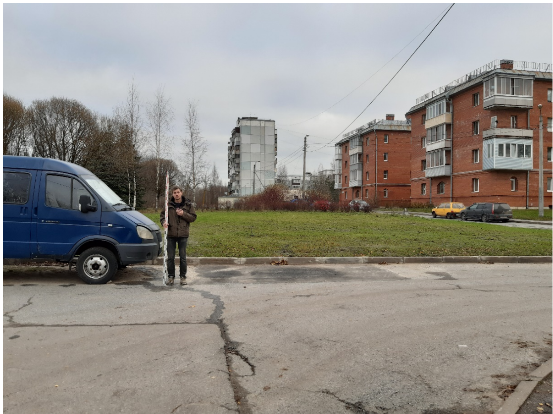
Рис. 19. Санкт-Петербург, квартал 38А, Рябовское шоссе (от ул. Окраинная до ул. Сосновая). Общий вид трассы обследования. Точка съемки 5. Вид на северо-восток.
