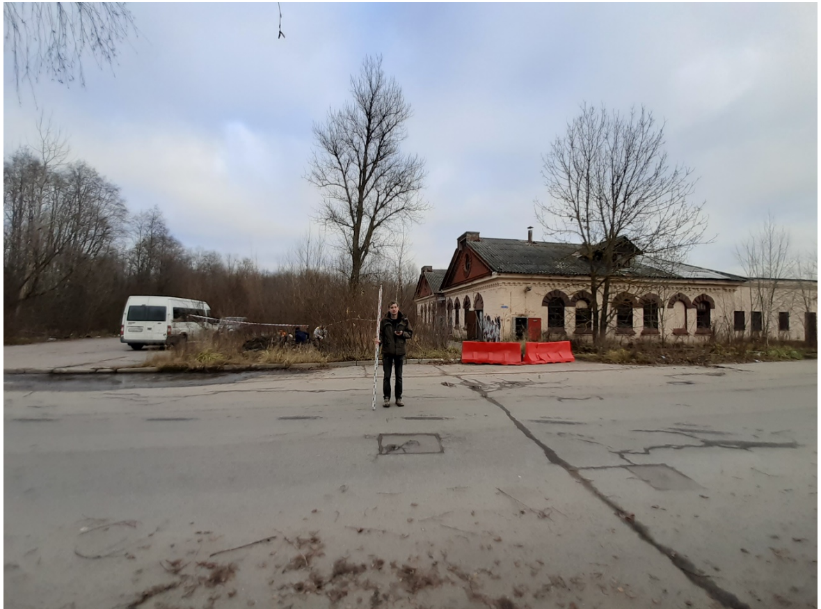
Рис. 11. Санкт-Петербург, квартал 38А, Рябовское шоссе (от ул. Окраинная до ул. Сосновая). Общий вид трассы обследования. Точка съемки 1. Вид на северо-восток.
