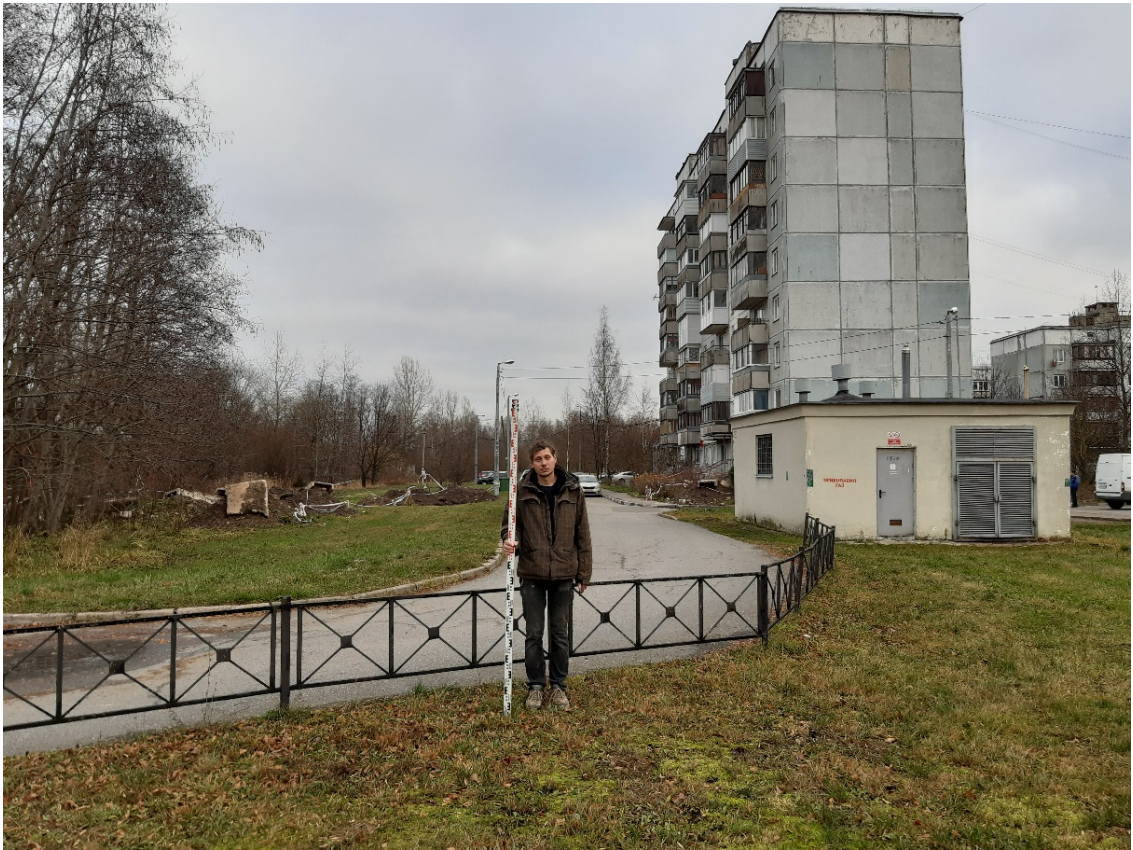
Рис. 18. Санкт-Петербург, квартал 38А, Рябовское шоссе (от ул. Окраинная до ул. Сосновая). Общий вид трассы обследования. Точка съемки 4. Вид на северо-восток.
