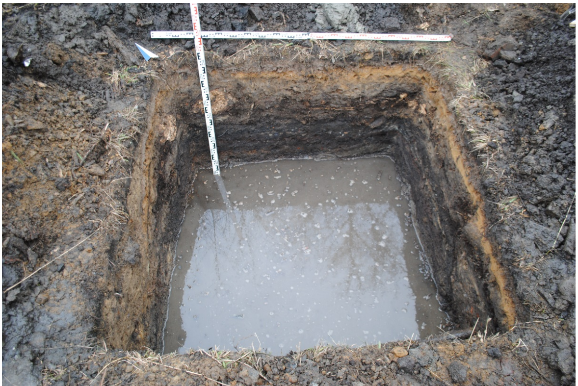
Рис. 45. Санкт-Петербург, квартал 38А, Рябовское шоссе (от ул. Окраинная до ул. Сосновая). Шурф 2. Фиксация по уровню грунтовых вод. Уровень прекращения работ. Вид на северо-восток.
