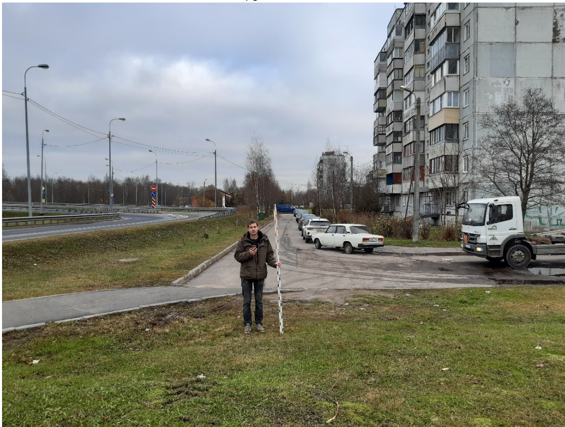
Рис. 22. Санкт-Петербург, квартал 38А, Рябовское шоссе (от ул. Окраинная до ул. Сосновая). Общий вид трассы обследования. Точка съемки 7. Вид на северо-восток.
