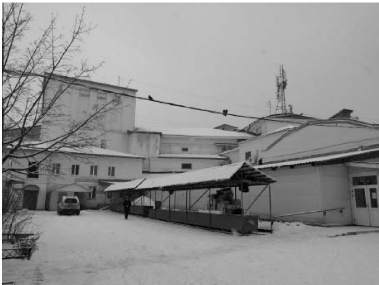
Фото 4. Выявленный объект культурного наследия «Дом культуры Текстильщиков (Дворец культуры им. Н.К. Крупской) (с флигелем), Санкт-Петербург, Обуховской Обороны пр., 105, лит. А. Юго-восточный (дворовый) фасад.
