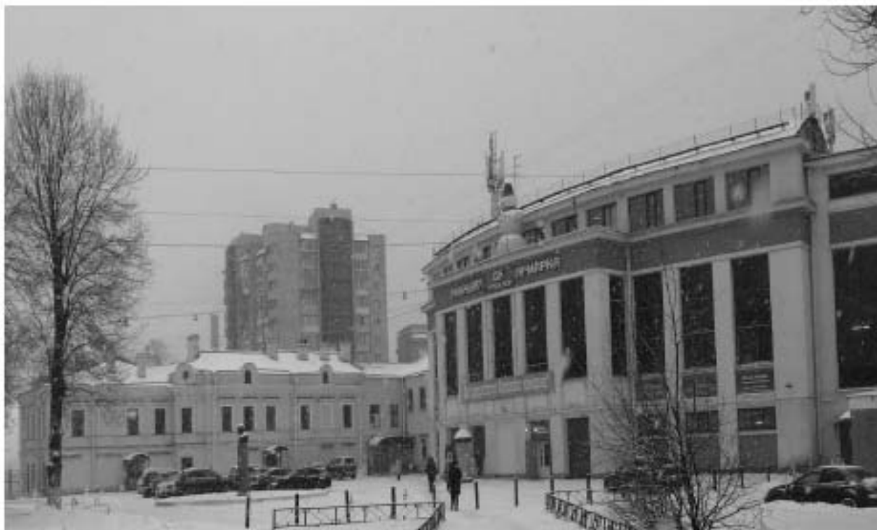
Фото 1. Выявленный объект культурного наследия «Дом культуры Текстильщиков (Дворец культуры им. Н.К. Крупской) (с флигелем), Санкт-Петербург, Обуховской Обороны пр., 105, лит. А. Общий вид.
