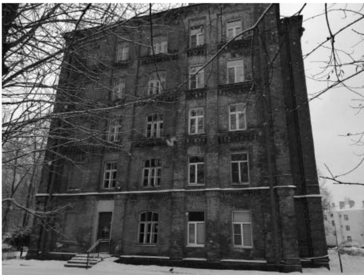
Фото 10. Выявленный объект культурного наследия «Казарма для рабочих фабрики Максвелла», Санкт-Петербург, Ткачей ул., 3. Северо-западный фасад.
