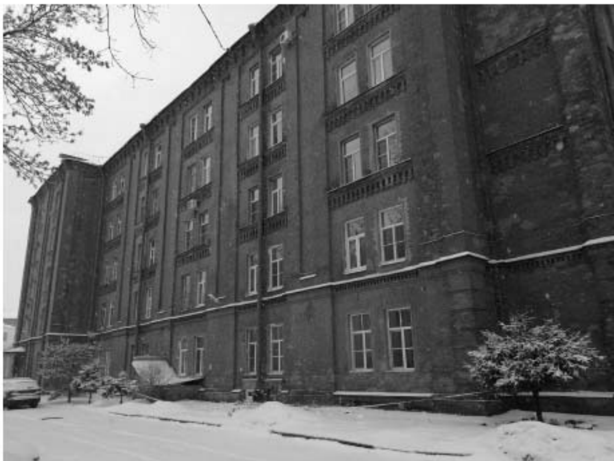
Фото 9. Выявленный объект культурного наследия «Казарма для рабочих фабрики Максвелла», Санкт-Петербург, Ткачей ул., 3. Северо-восточный фасад.
