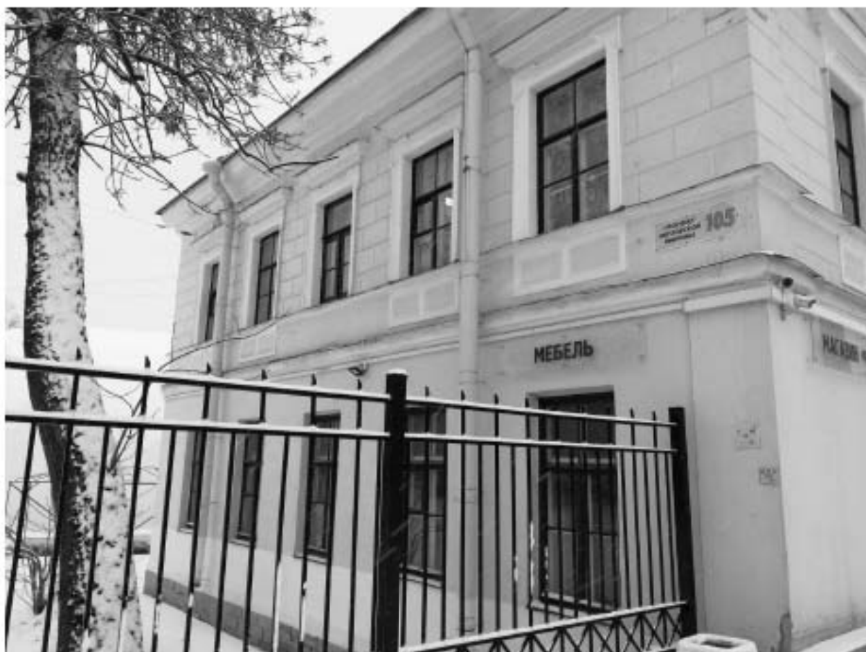
Фото 6. Выявленный объект культурного наследия «Дом культуры Текстильщиков (Дворец культуры им. Н.К. Крупской) (с флигелем), Санкт-Петербург, Обуховской Обороны пр., 105, лит. А. Флигель. Северо-восточный фасад.
