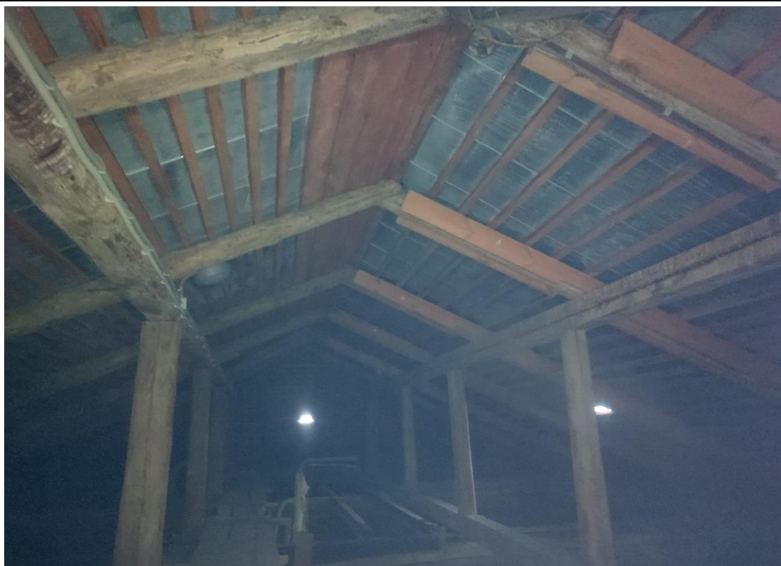
60. Объект культурного наследия регионального значения «Женская гимназия Павловой», расположенный по адресу: Санкт-Петербург, город Петергоф, Эрлеровский бульвар, дом 1/35, литера А. Общий вид стропильной системы крыши.
