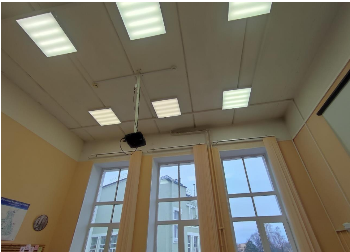
31. Объект культурного наследия регионального значения «Женская гимназия Павловой», расположенный по адресу: Санкт-Петербург, город Петергоф, Эрлеровский бульвар, дом 1/35, литера А. Общий вид фрагмент пом. 2-Н (21) 2-го этажа.
