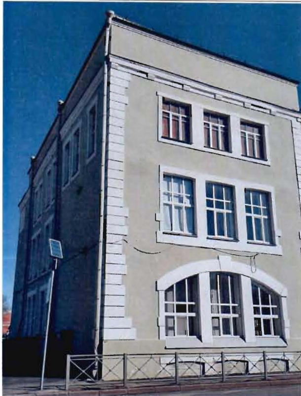
4. Фрагмент юго-западного фасада
