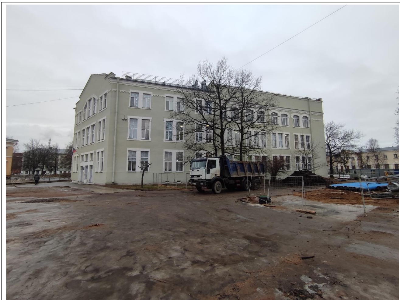
5. Объект культурного наследия регионального значения «Женская гимназия Павловой», расположенный по адресу: Санкт-Петербург, город Петергоф, Эрлеровский бульвар, дом 1/35, литера А. Общий вид лицевого фасада здания по ул. Аврова.
