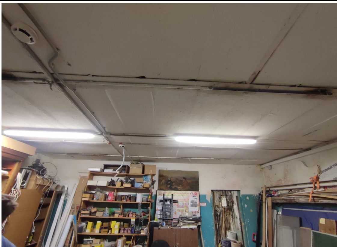
11. Объект культурного наследия регионального значения «Женская гимназия Павловой», расположенный по адресу: Санкт-Петербург, город Петергоф, Эрлеровский бульвар, дом 1/35, литера А. Общий вид пом. 5-Н (11) подвального этажа.
