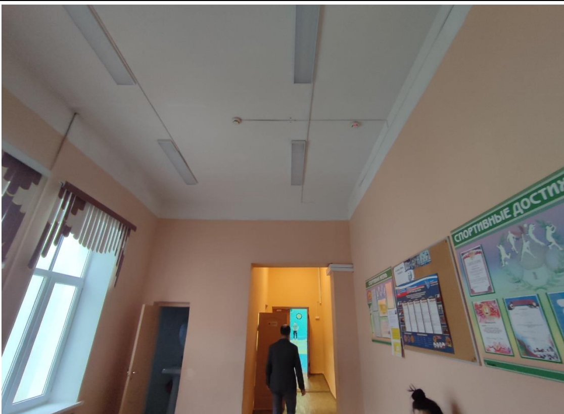
58. Объект культурного наследия регионального значения «Женская гимназия Павловой», расположенный по адресу: Санкт-Петербург, город Петергоф, Эрлеровский бульвар, дом 1/35, литера А. Фрагмент пом. 3-Н (1) 3-го этажа.
