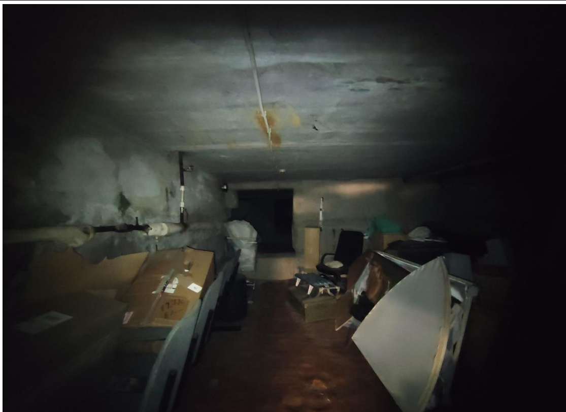
10. Объект культурного наследия регионального значения «Женская гимназия Павловой», расположенный по адресу: Санкт-Петербург, город Петергоф, Эрлеровский бульвар, дом 1/35, литера А. Общий вид пом. 5-Н (20) подвального этажа.
