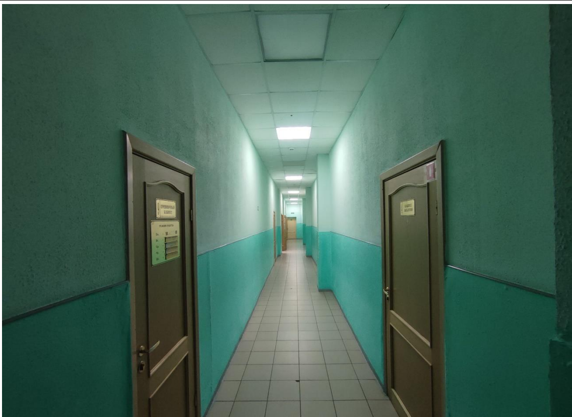
24. Объект культурного наследия регионального значения «Женская гимназия Павловой», расположенный по адресу: Санкт-Петербург, город Петергоф, Эрлеровский бульвар, дом 1/35, литера А. Общий вид пом. 1-Н (34) 1-го этажа.
