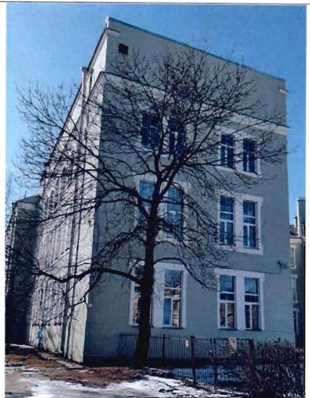
5. Фрагмент северо-восточного фасада
