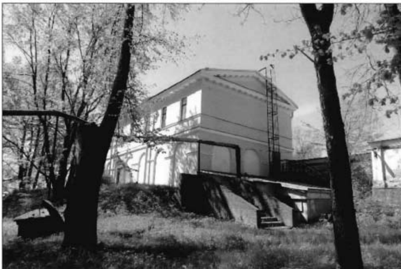
3. Северный дворовый фасад объекта культурного наследия. Общий вид с северо-востока.
