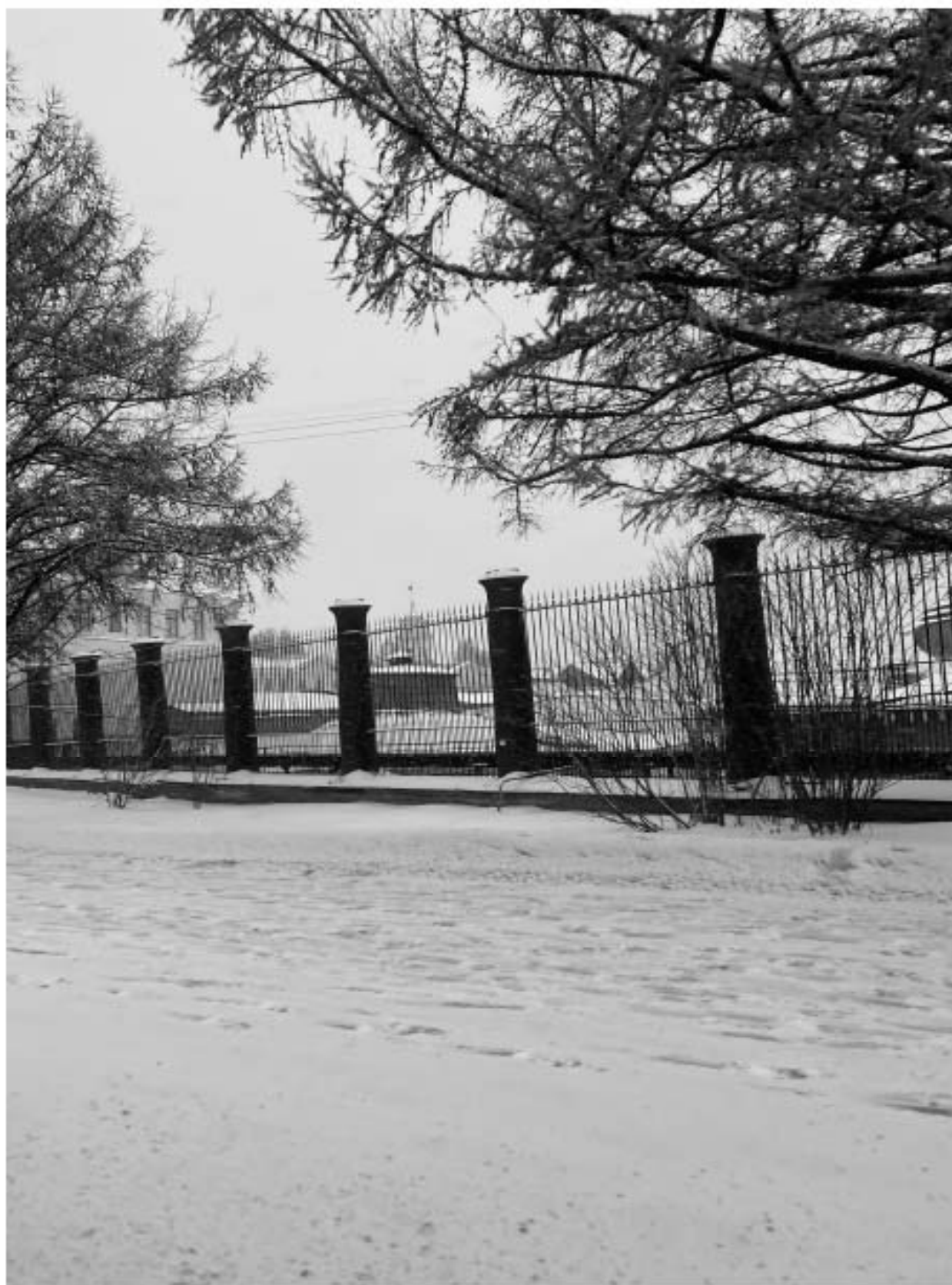
17. Вид на объект культурного наследия «Ограда на подпорной стене главной плотины»;
