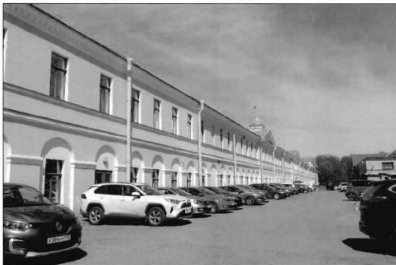
5. Восточный дворовый фасад объекта культурного наследия. Общий вид с юго-востока.
