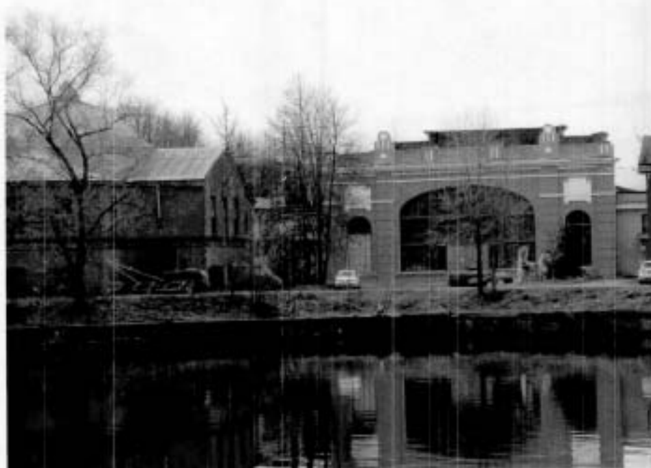
2. Вид со стороны нижнего бьефа
