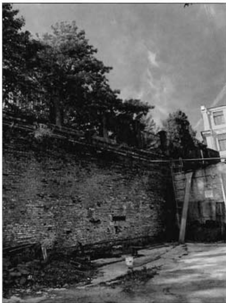
2. Фрагмент ограды и подпорной стены со стороны завода.
