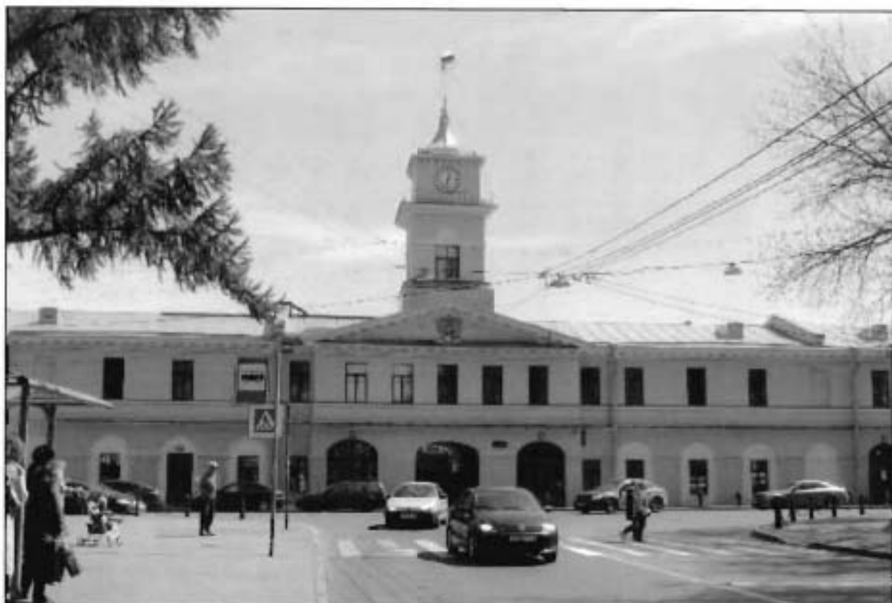
2. Лицевой западный фасад объекта культурного наследия. Фрагмент.
