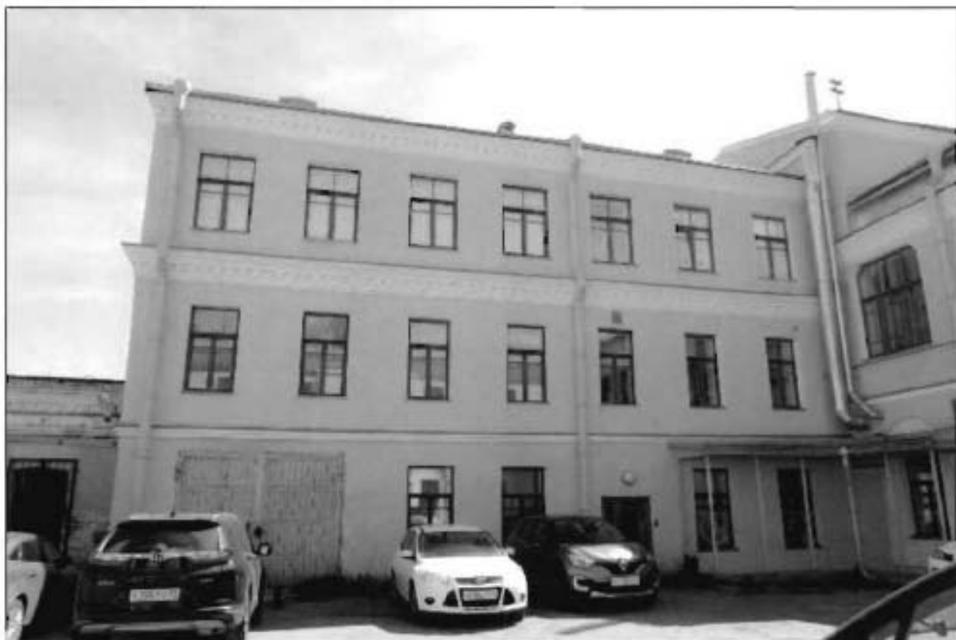
7. Западный дворовый фасад объекта культурного наследия.
