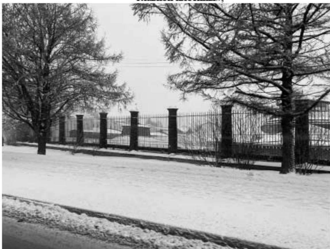
19. Вид на объект культурного наследия «Ограда на подпорной стене главной плотины».
