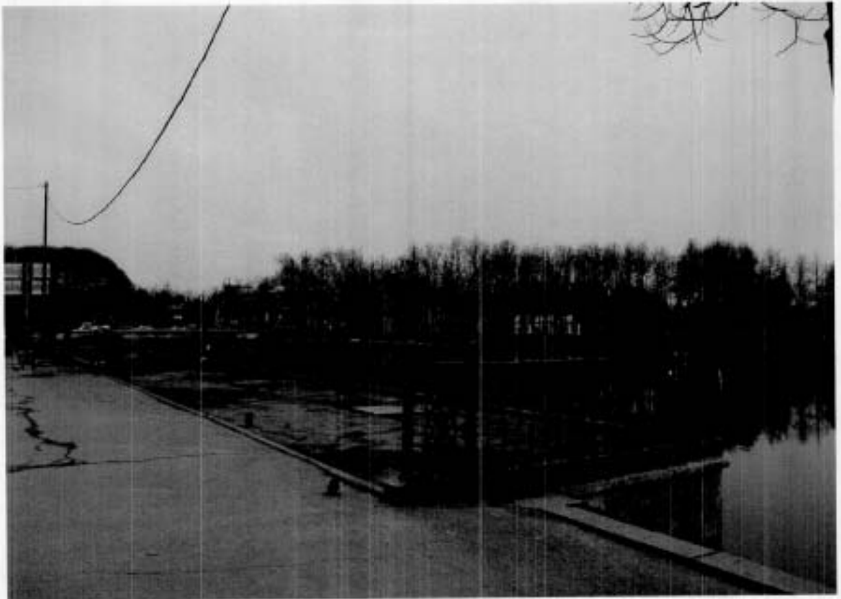
5. Смотровая площадка с прямыми для подъемного оборудования
