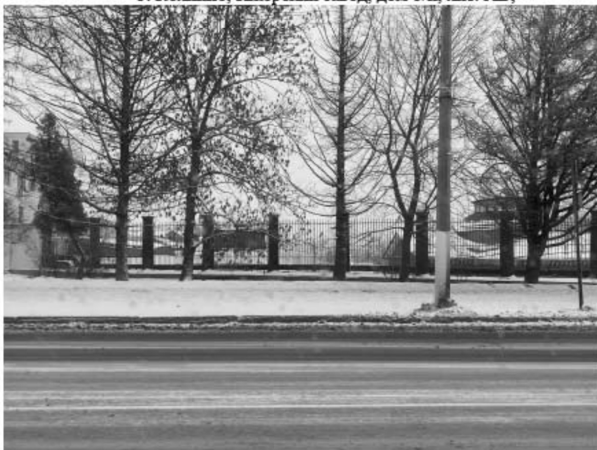
16. Вид на объект культурного наследия «Ограда на подпорной стене главной плотины»;
