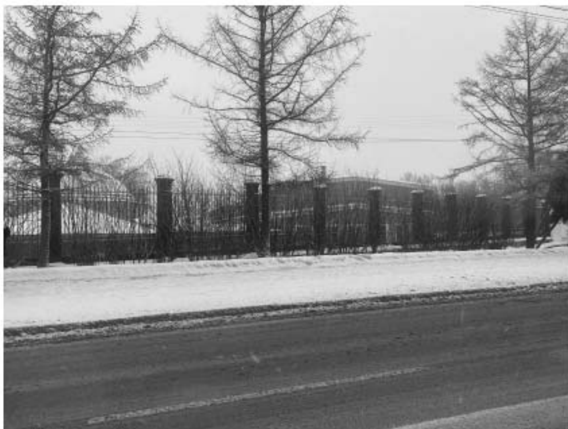
18. Вид на объект культурного наследия «Ограда на подпорной стене главной плотины»;
