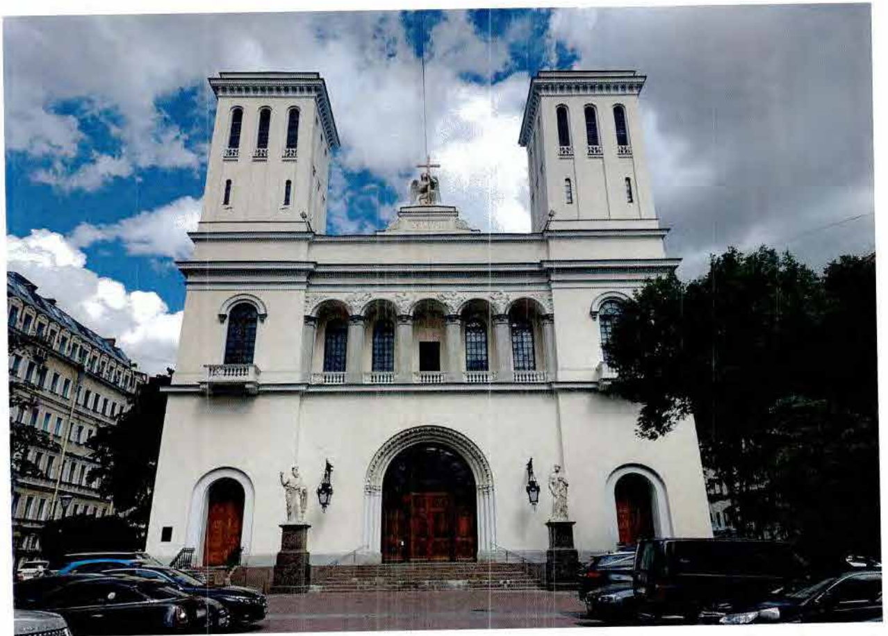
1. Вид на южный фасад.
