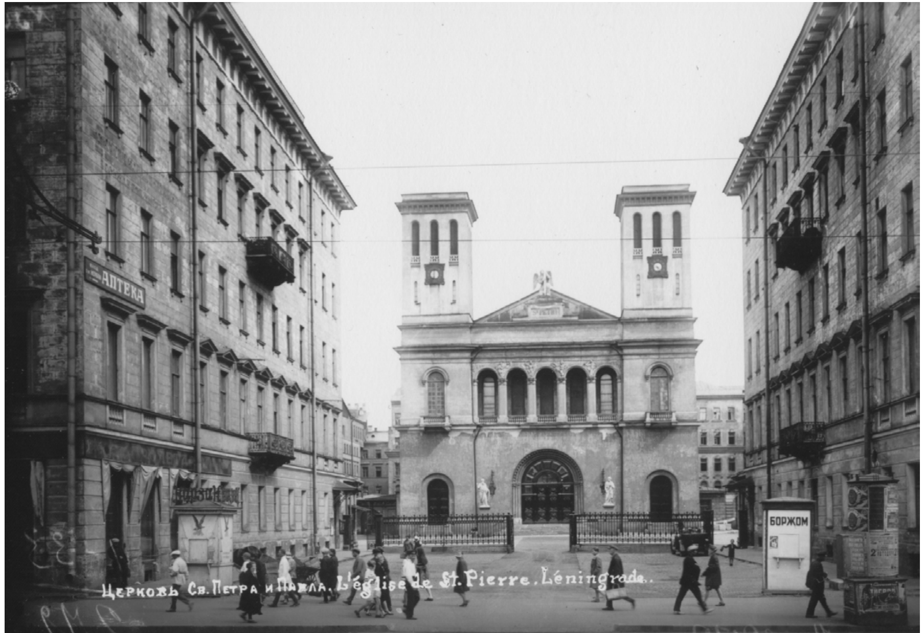
Ил. 13 Фасад здания лютеранской церкви Св. Петра. 1934 г. ЦГАКФФД СПб., № Гр 39178
