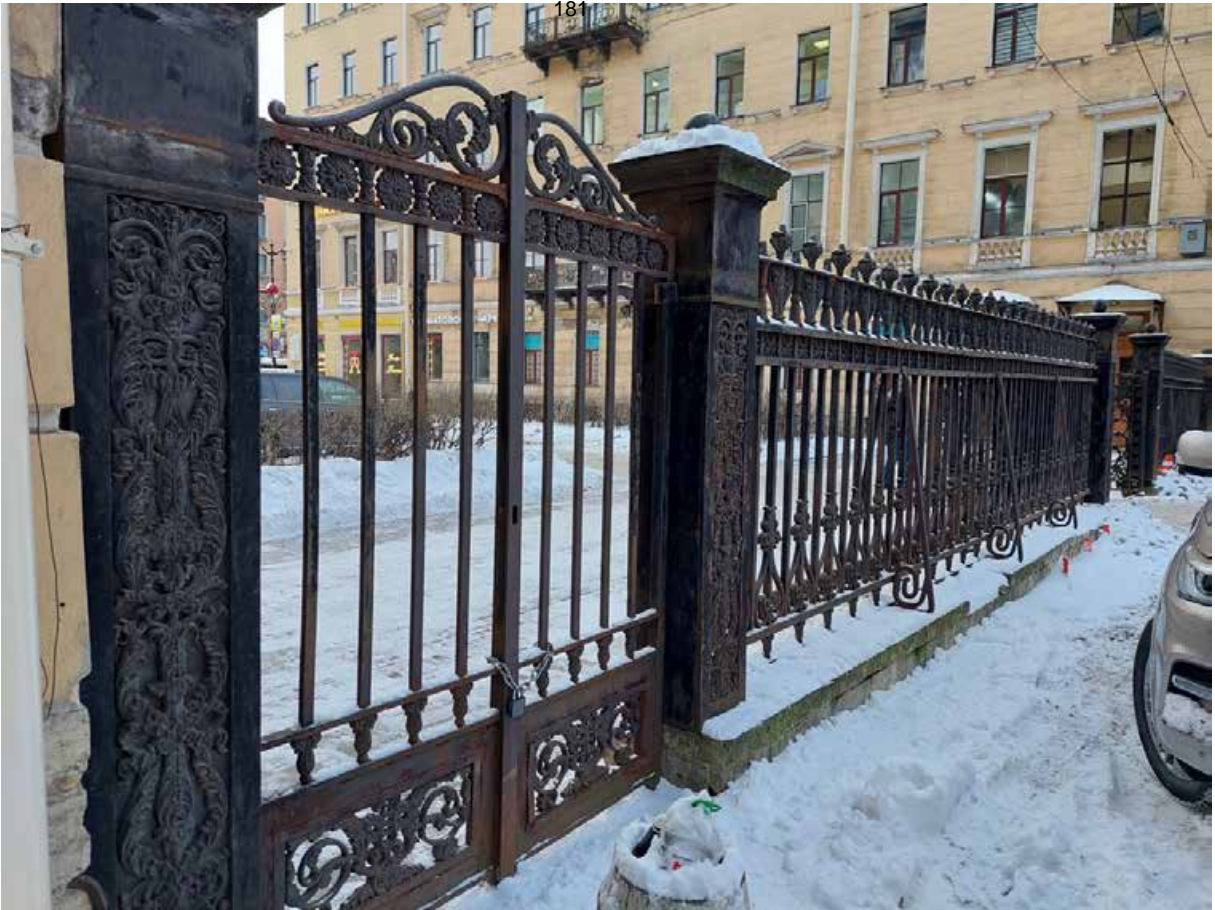
15 ОКН федерального значения “Ограда между домами” (в составе «Храм евангелическо-лютеранский Апостола Петра») по адресу: Санкт-Петербург, Невский пр., д. 22-24, лит. Б. Общий вид ограды. Вид с северо-востока. Дата съемки: 01.12.2022 г.
