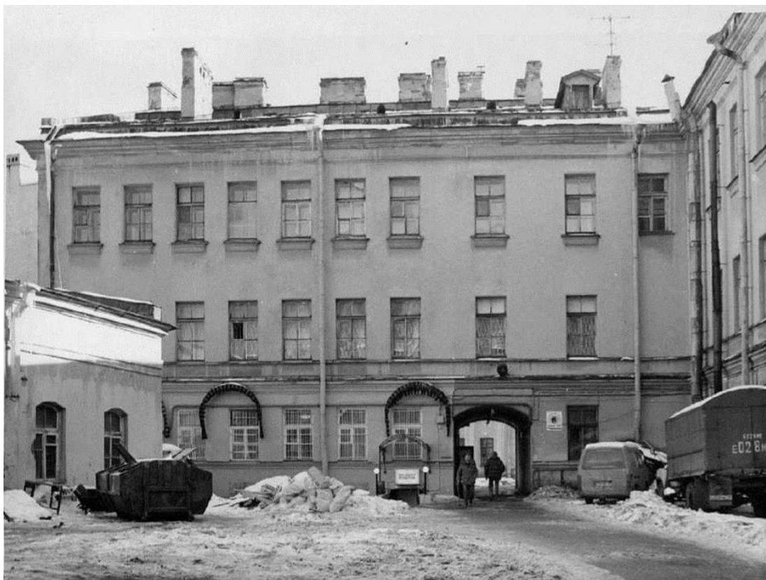
14. Придворная певческая Капелла. Дворовые фасады. Фотография. 1997 г. КГИОП. Предоставлено заказчиком. Материалы проекта: «ПРОЕКТНАЯ ДОКУМЕНТАЦИЯ. Реставрация, ремонт и приспособление для современного использования помещений 3-го этажа литеры А-6 (22-Н, 57-Н, 29-Н, 58-Н, 59-Н) по адресу: наб. р. Мойки, д. 20. Объект культурного наследия федерального значения «Главное здание (концертный зал с учебными флигелями)» (в составе «Капелла Придворная певческая»)» (Шифр 323-19-22).
