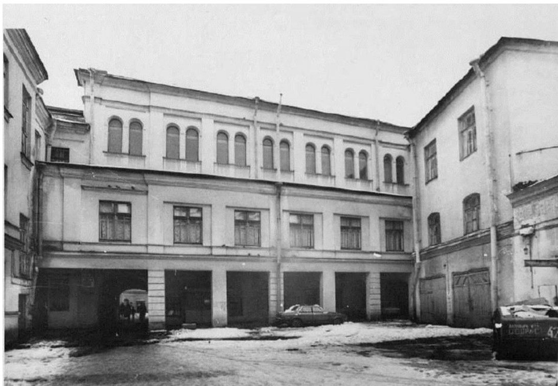
13. Придворная певческая Капелла. Дворовые фасады. Фотография. 1997 г. КГИОП. Предоставлено заказчиком. Материалы проекта: «ПРОЕКТНАЯ ДОКУМЕНТАЦИЯ. Реставрация, ремонт и приспособление для современного использования помещений 3-го этажа литеры А-6 (22-Н, 57-Н, 29-Н, 58-Н, 59-Н) по адресу: наб. р. Мойки, д. 20. Объект культурного наследия федерального значения «Главное здание (концертный зал с учебными флигелями)» (в составе «Капелла Придворная певческая»)» (Шифр 323-19-22).
