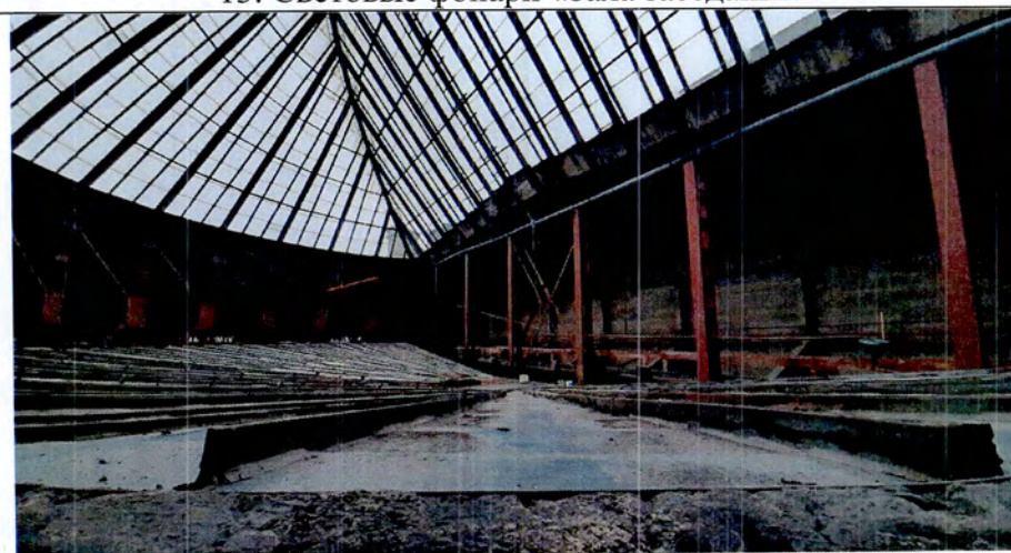
14. Конструкции световых фонарей «Зала заседаний»
