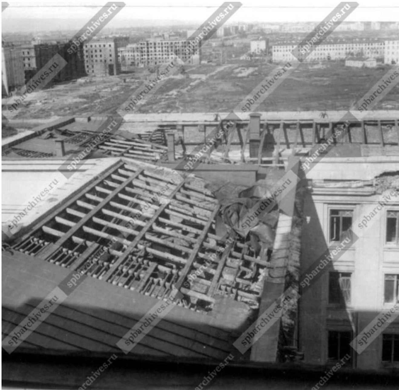
Илл. 68. Вид поврежденной крыши Дома Советов на Московском шоссе (архитекторы Н.А. Троцкий, Л.М. Тверской, Я.О. Свирский, 1936-1941 гг.). Дата съёмки: 1948 г. // ЦГАКФФД СПб. Архивный шифр: Вр 69215
