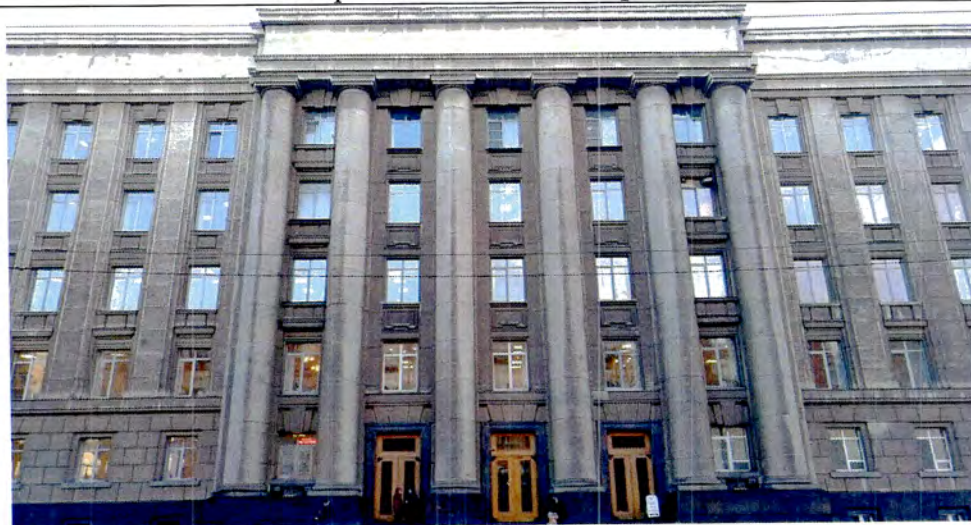
3. Фрагмент северного фасада
