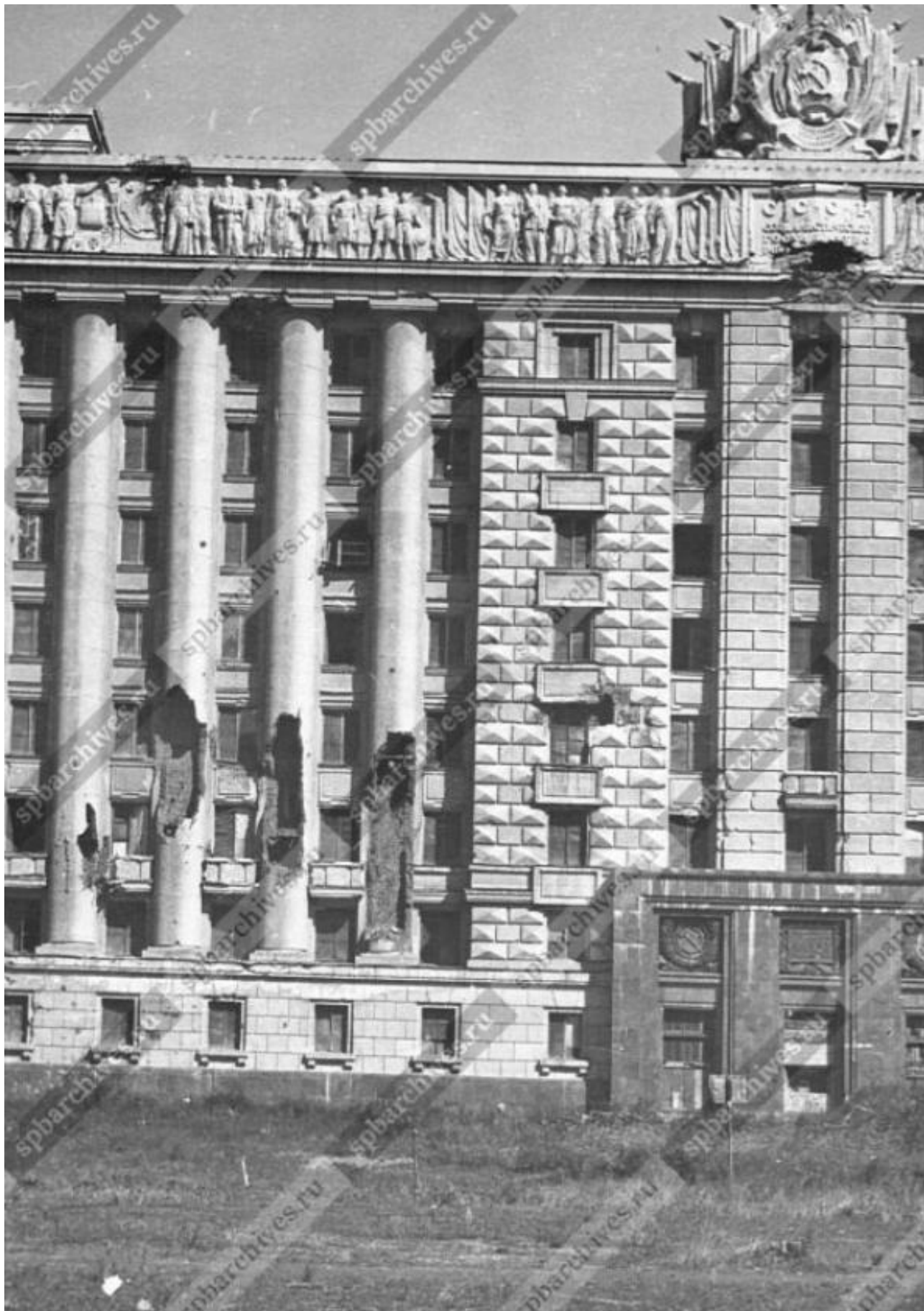
Илл. 67. Вид пробоин на здании Дома Советов. Дата съёмки: 1945 г. // ЦГАКФФД СПб. Архивный шифр: Бр 14049
