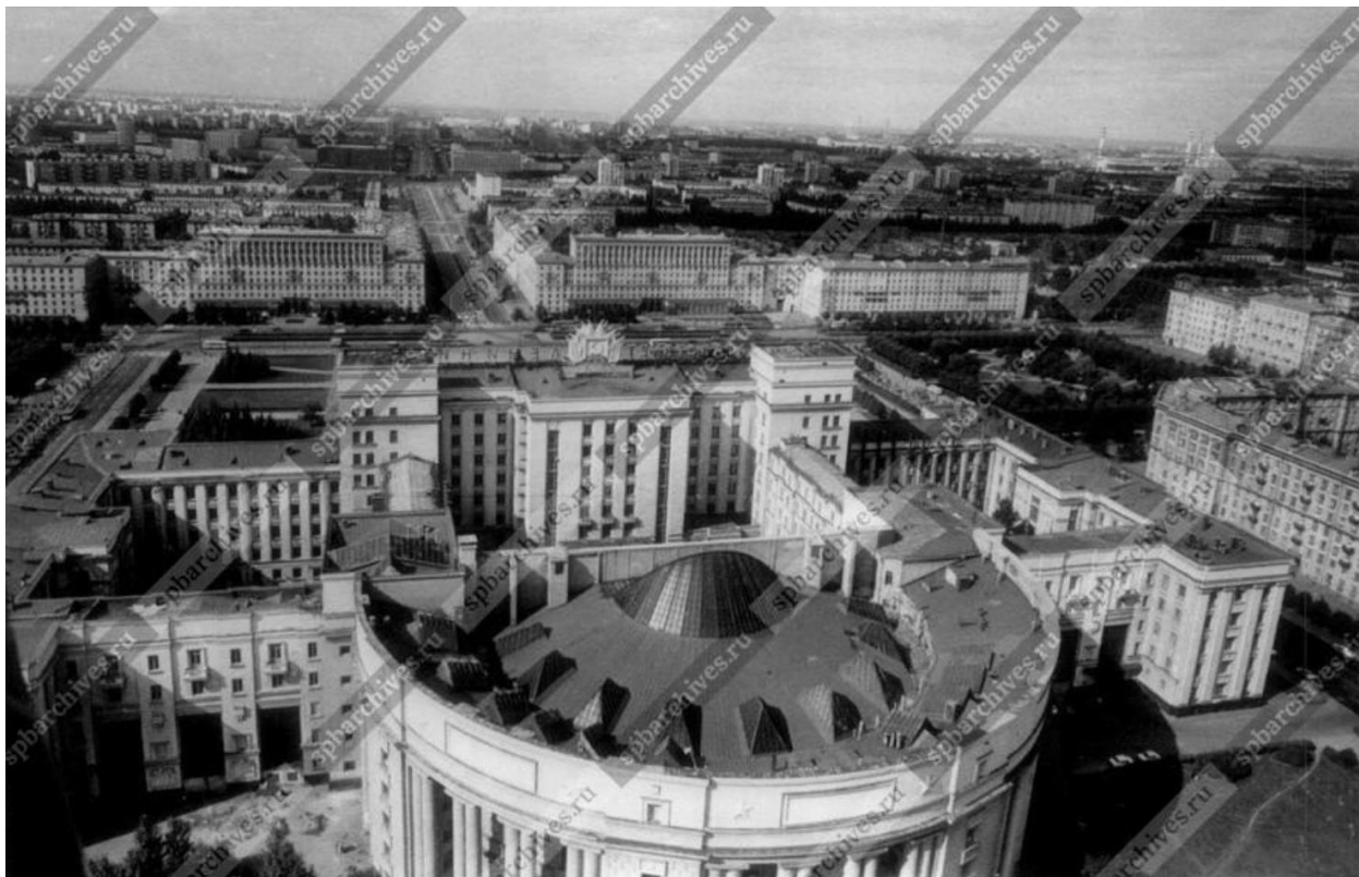
Илл. 85. Вид с вертолета на здание Дома Советов со стороны восточного фасада (1936-1941 гг. - архитекторы Н.А. Троцкий; Я.Н. Лукин, Я.О. Свирский, Л.М. Тверской, М.А. Шепиловский; инженер С.С. Голушкевич). Дата съёмки: июль 1980 г. // ЦГАКФФД СПб. Архивный шифр: Ар 146434
