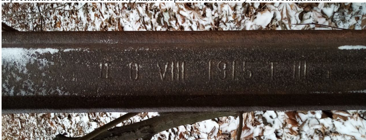
Рис. 49. Санкт-Петербург, ул. Киевская д. 5, кадастровый участок № 78:14:0007525:3838. Рельса Новороссийского общества в конструкции опоры столба южнее участка обследования.
