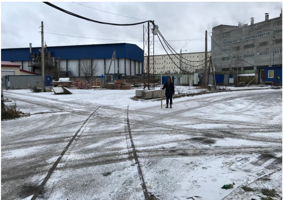
Рис. 36. Санкт-Петербург, ул. Киевская д. 5, кадастровый участок № 78:14:0007525:3838. ТФ 9. Вид с юго-запада. Для масштаба использована нивелировочная рейка 2 м.
