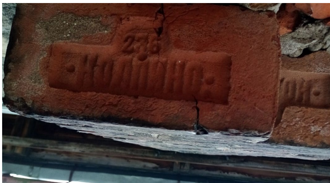
Рис. 30. Санкт-Петербург, ул. Киевская д. 5, кадастровый участок № 78:14:0007525:3838. Клейменный кирпич в кладке здания по адресу: ул. Киевская, д. 5С.
