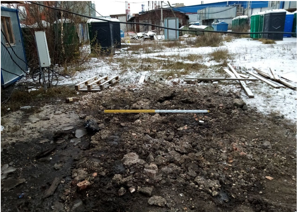
Рис. 60. Санкт-Петербург, ул. Киевская д. 5, кадастровый участок № 78:14:0007525:3838. Шурф 2 рекультивации. Общий вид с юга.
