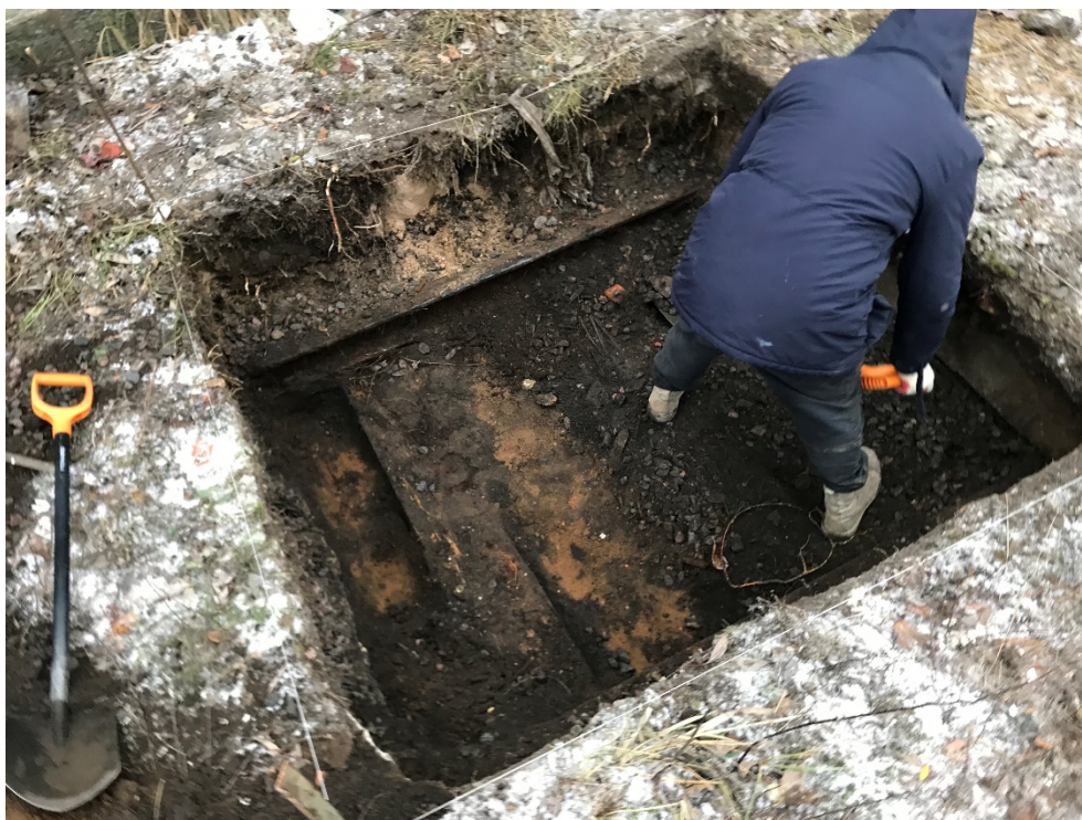
Рис. 39. Санкт-Петербург, ул. Киевская д. 5, кадастровый участок № 78:14:0007525:3838. Шурф 1 разбор щебневой засыпки над рельсами. Рабочий момент. Общий вид с востока.
