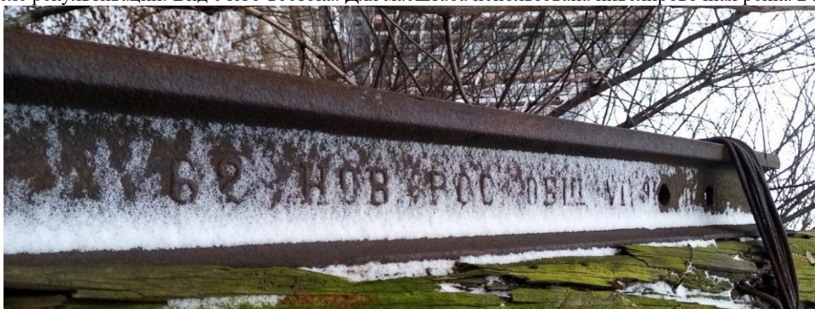
Рис. 48. Санкт-Петербург, ул. Киевская д. 5, кадастровый участок № 78:14:0007525:3838. Рельса Новороссийского общества в конструкции опоры столба южнее участка обследования.
