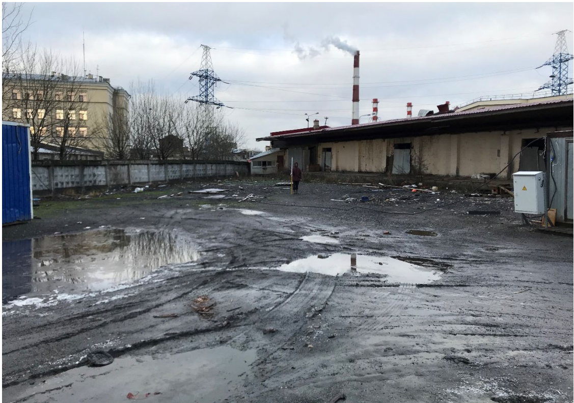
Рис. 27. Санкт-Петербург, ул. Киевская д. 5, кадастровый участок № 78:14:0007525:3838. Точка фотофиксации (далее ТФ) 1. Вид с юга. Для масштаба использована нивелировочная рейка 2 м.
